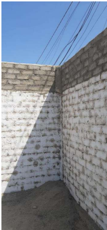
Fotografía N°4: cerco de ladrillo sin sobrecimiento, sin vigas de amarra, presenta columnas de anchos diversos, sin juntas sísmicas entre paños.
