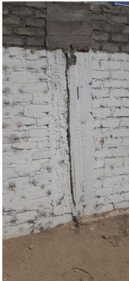
Fotografía N°4: cerco de ladrillo sin sobrecimiento, sin vigas de amarra, presenta columnas de anchos diversos, sin juntas sísmicas entre paños.
