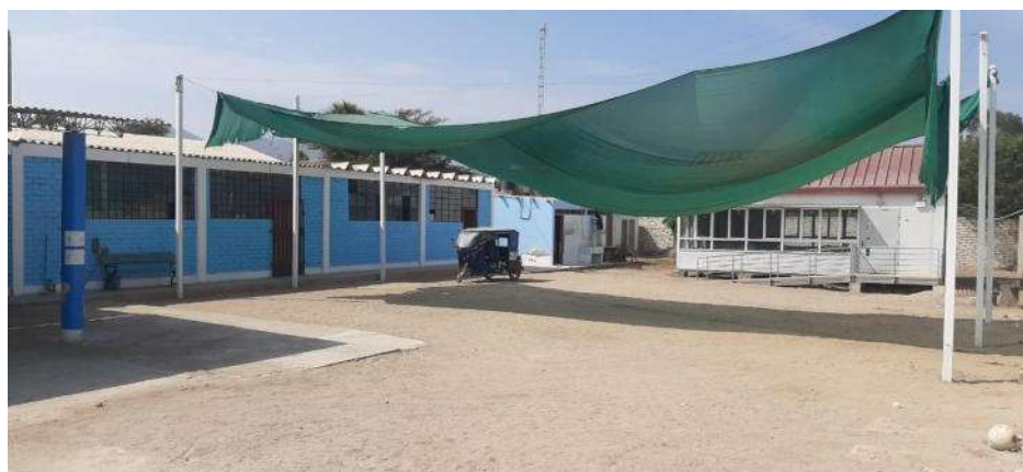
Fotografía N° 09: Modulo prefabricado para aula, entregado por PRONIED y patio interior de la IE 88112
