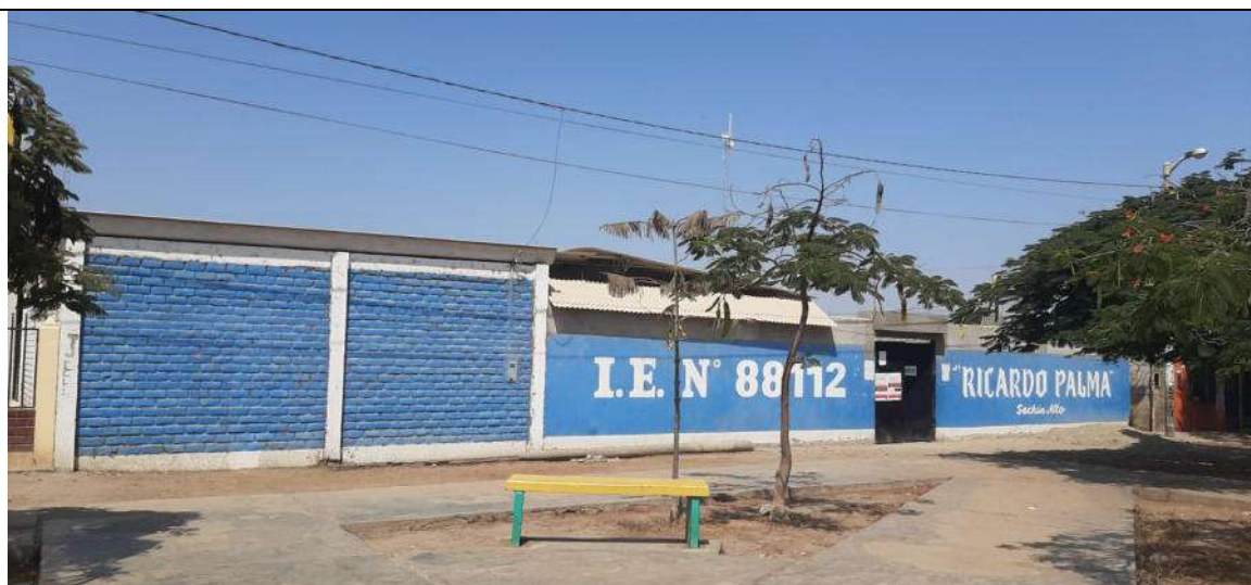
Fotografía N° 01: Ingreso a la IE N° 88112, vista desde el exterior
