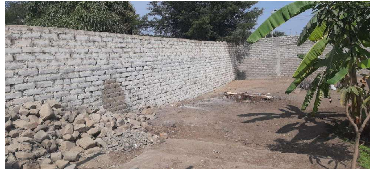
Fotografía N°3: encuentro entre cerco de adobe y cerco de ladrillo.
