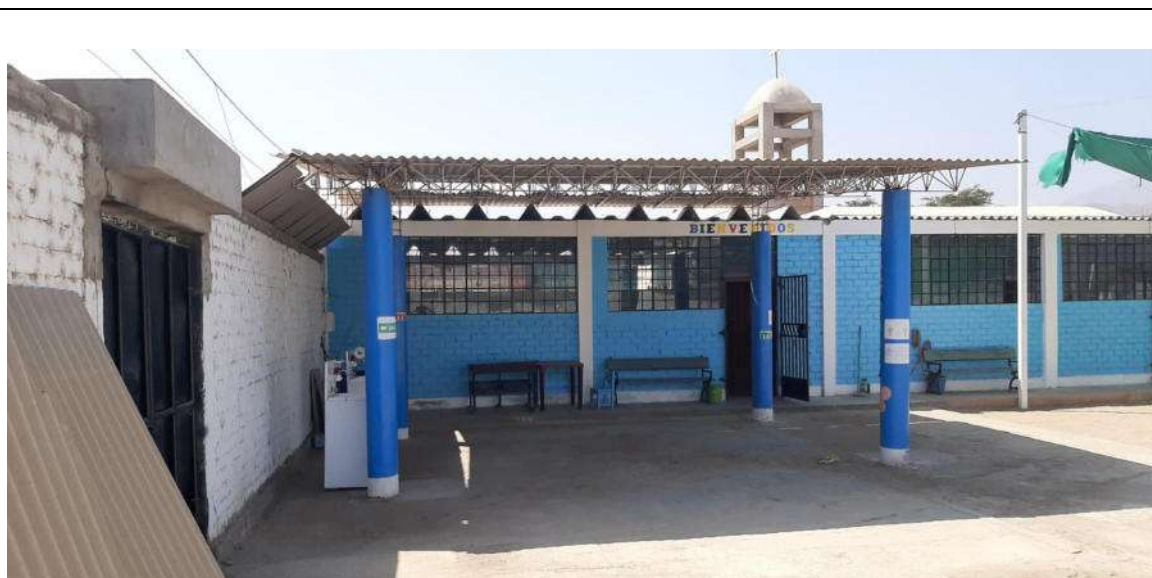
Fotografía N° 02: vista desde el interior, pabellón principal
