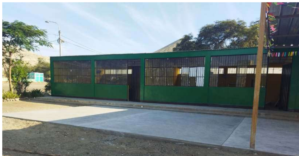
Fotografía N°06: Se visualiza la existencia de una losa de concreto.
