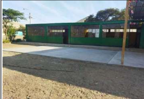
VISTA DE LA PARTE EXTERIOR, DONDE SE VE LA LOSA EXISTENTE
