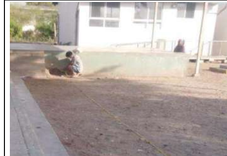
VISTA DEL INGRESO Y DE LAS AULAS EXISTENTES DE MODULOS PREFABRICADOS
