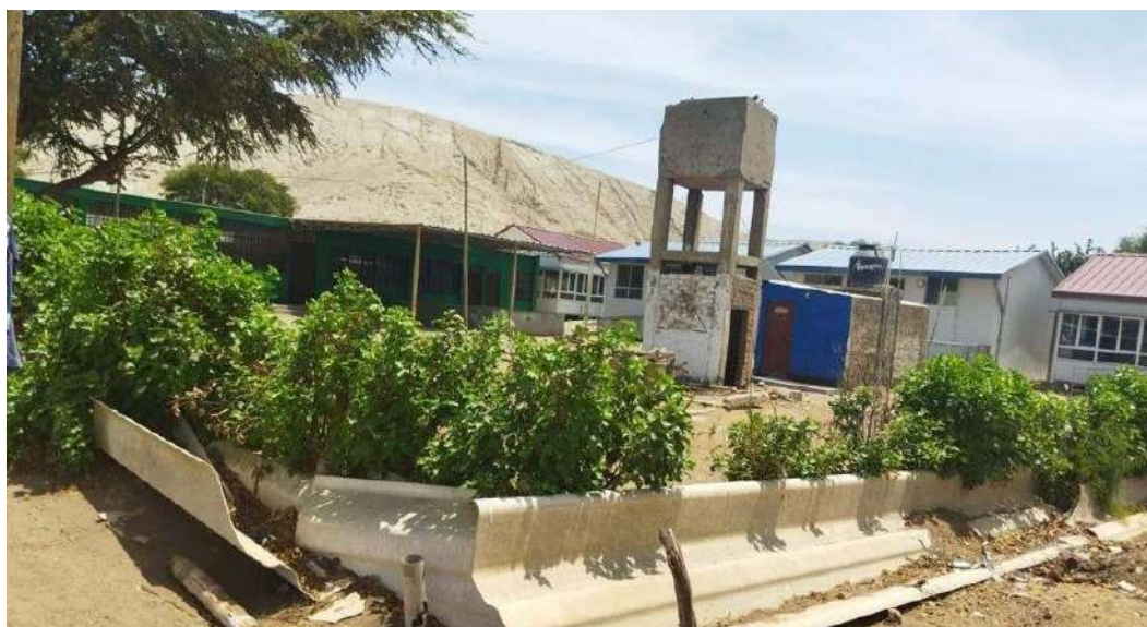
Fotografía N°07: Se visualiza que el cerco perimétrico vivo de la I.E. N° 88122, donde se ve el material precario para su desmontaje
