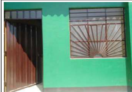
AMBIENTES EXISTENTES EN BUENAS CONDICIONES DE CONSERVACION
