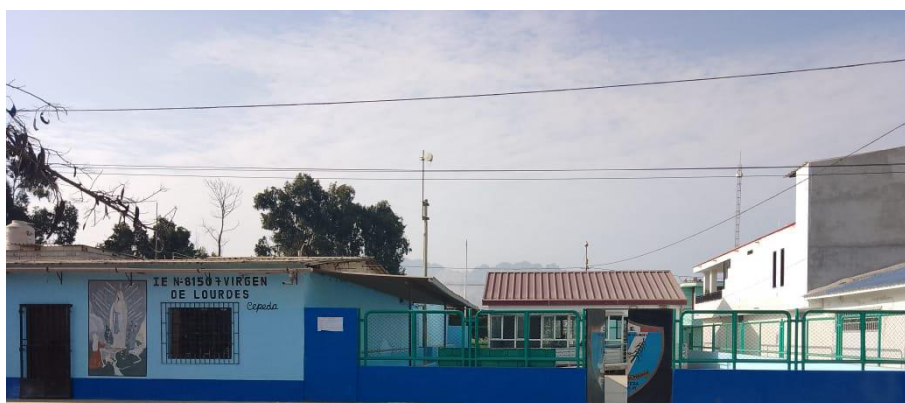
Fotografía N°06: Se visualiza el cerco perimétrico.
