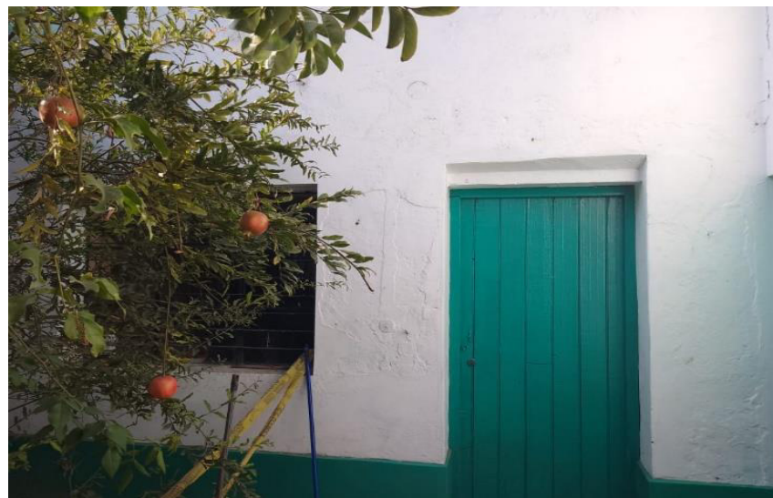
Fotografía N°04: Vista externa de la cocina existente, construido por financiamiento de la APAFA
