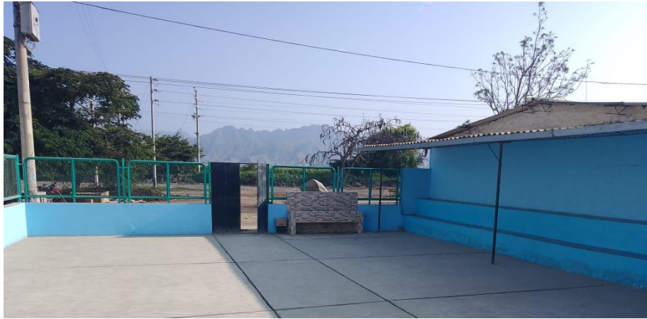
Fotografía N°07: Se visualiza el cerco perimétrico.
