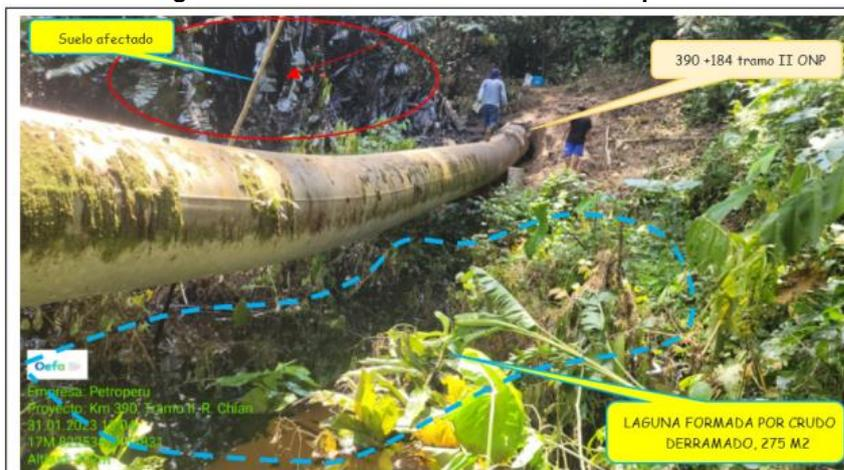
**Foto N° 1:** Vista del petróleo acumulado en la parte baja de la zona, del km 390 + 184 del Tramo II del ONP, y la zona del componente suelo afectado.
