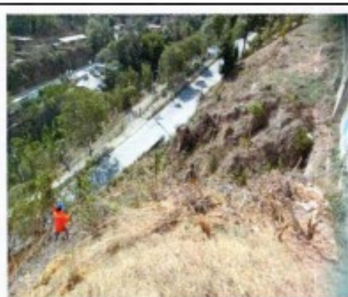
Actividad 01: Erradicación de puntos críticos de acumulación de residuos sólidos meta 03.
