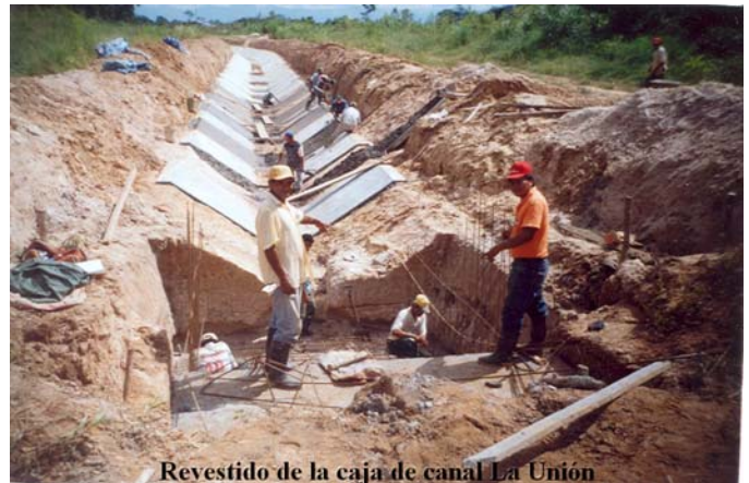
Revestido de la caja de canal La Unión
