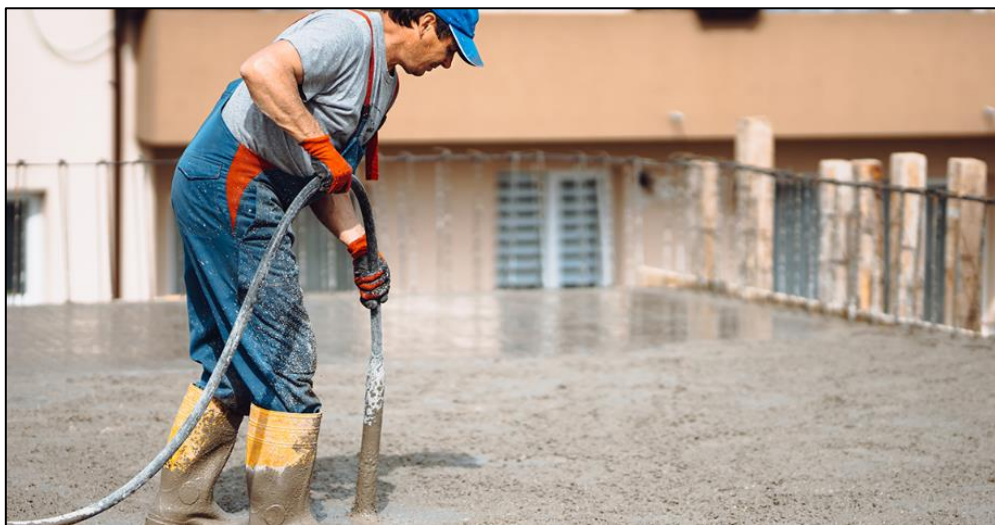
Figura 13: Vibrador interno utilizado en compactación de losa (Fuente: Pag. Web TERRA Equipos)
