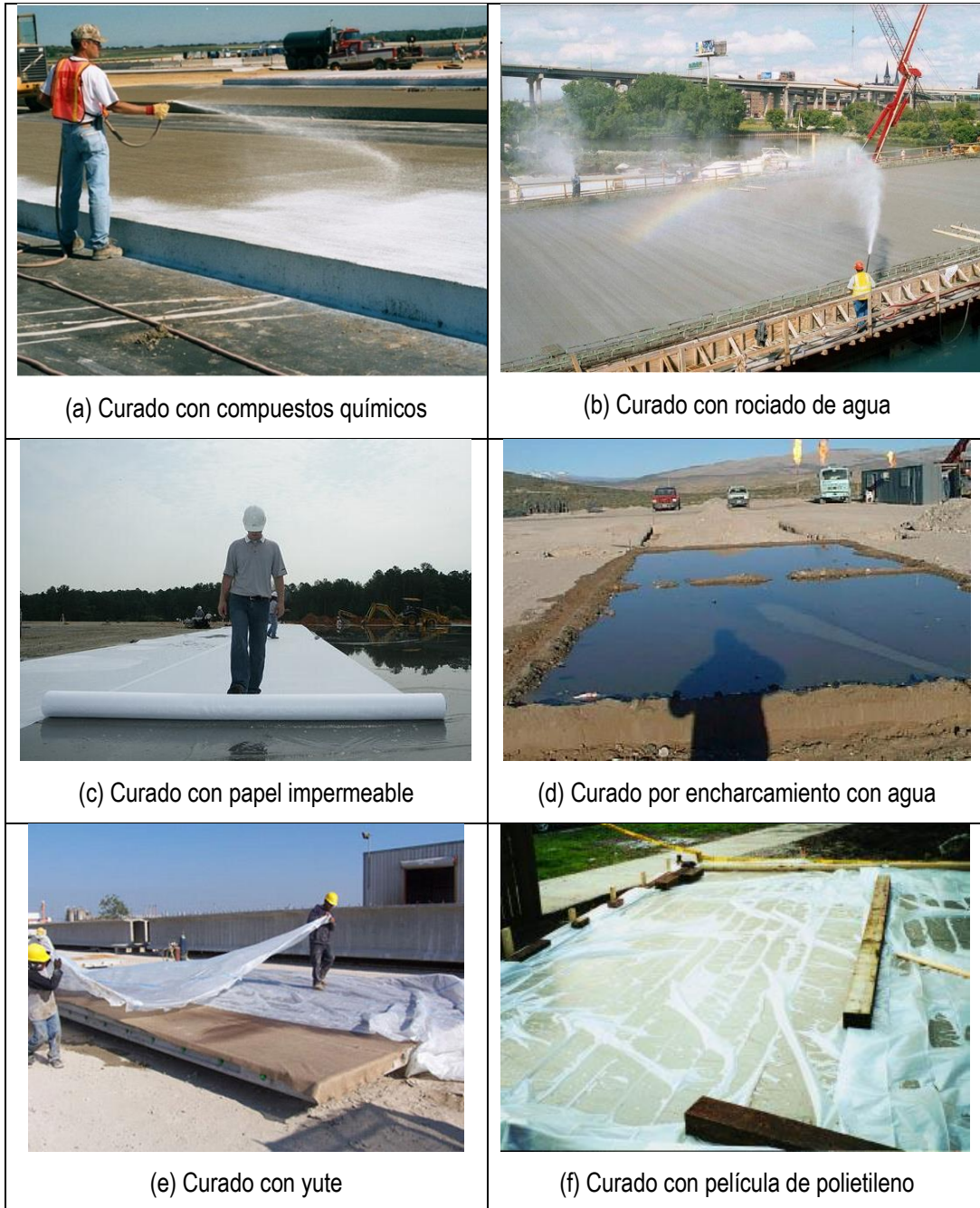
Figura 20: Métodos de curado del concreto
