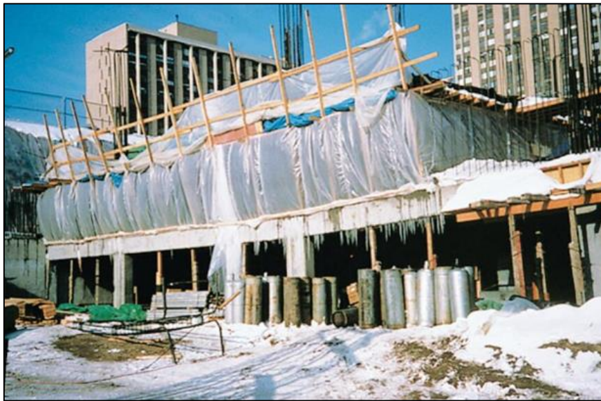
Figura 28: Microclima en estructura en construcción (PCA)
