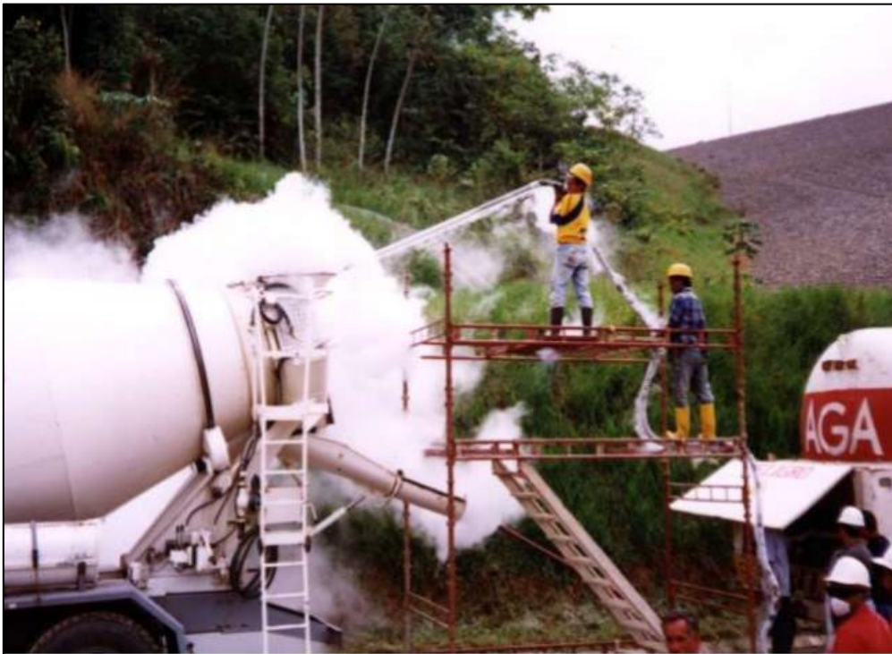
Figura 33: Enfriamiento del concreto utilizando nitrógeno líquido (Fuente: Internet - ARGOS).
