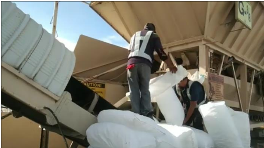
Figura 34: Introducción de hielo en la mezcla de concreto (Fuente: Youtube)
