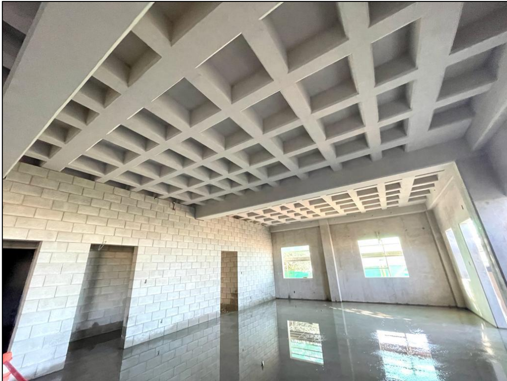
Figura 12: Superficie interna de concreto caravista
