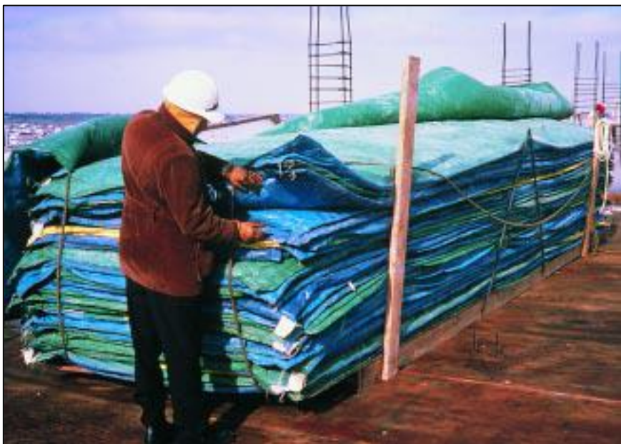
Figura 30: Pilas de cubiertas de aislamiento térmico (PCA)
