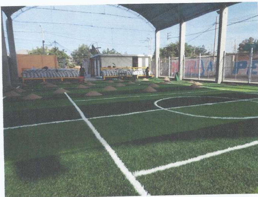
CAMPO DEPORTIVO INSTALACION DEL GRASS SINTETICO.
