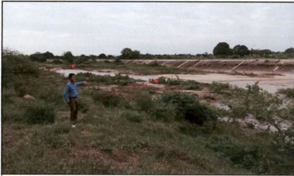
Figura Nº 2. Tramo a descolmatar en cauce del río Zarumilla Bocatoma La Palma – Uña de Gato distrito de Aguas Verdes, provincia de Zarumilla.
