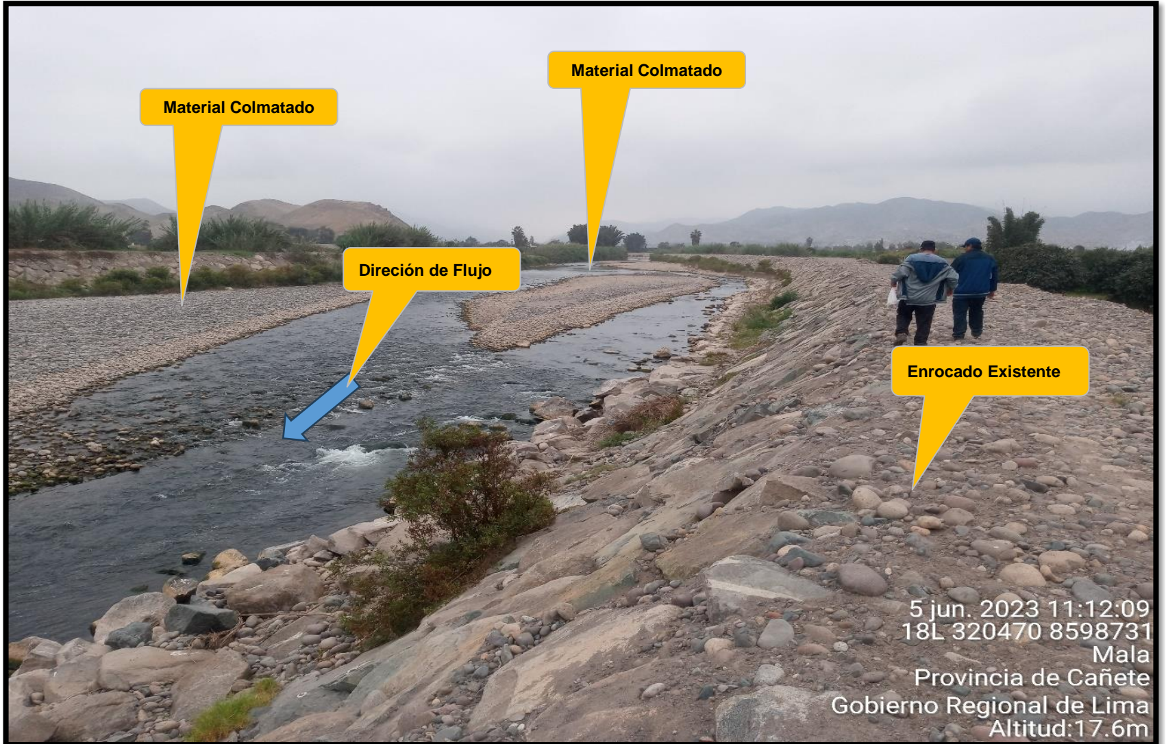
FIGURA N°02: AREA COLMATADA AGUAS ARRIBA DEL PUENTE MALA, EN TEMPORADAS DE MAXIMAS AVENIDAS DEL RIO MALA.
