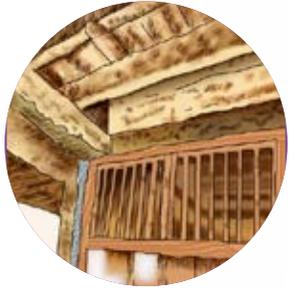
**3.** Deformación de estructura por humedad
