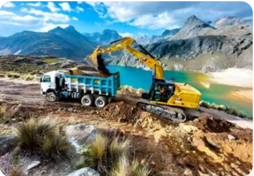
Ejecución de obras en el Proyecto Caridad.
