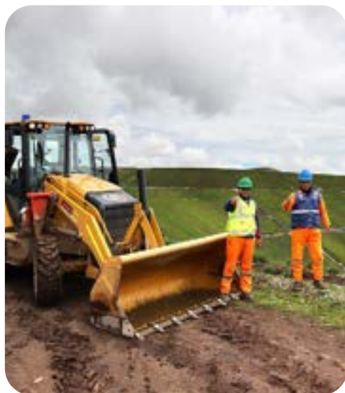
Trabajadores en el proyecto Excélsior.
