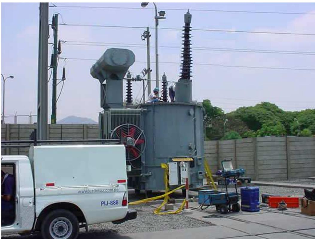
4.- Realizar el conexionado del equipo para el ensayo
