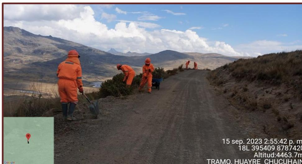
**Fotografía N°01** Realización de limpieza y deshierbamiento del Camino Vecinal JU-535 Tramo: Huayre - Chucuhuain L=16.70 KM
