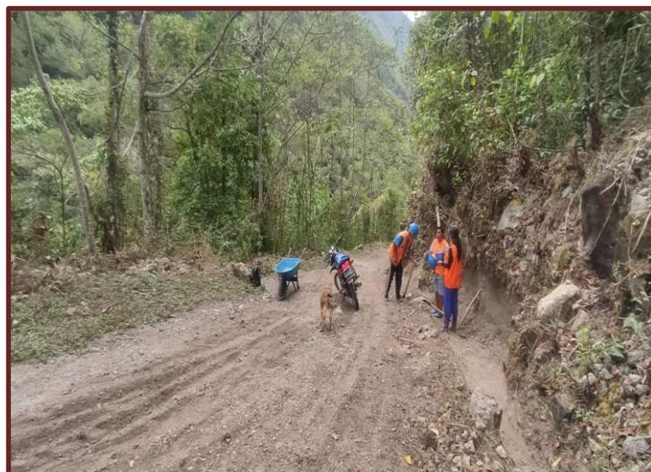
**Fotografía N°02.** Limpieza de calzada y cuneta de limpieza de cuneta del Camino Vecinal PA-675 Tramo: Llaupi – Pampa Seca L=11.20 KM
