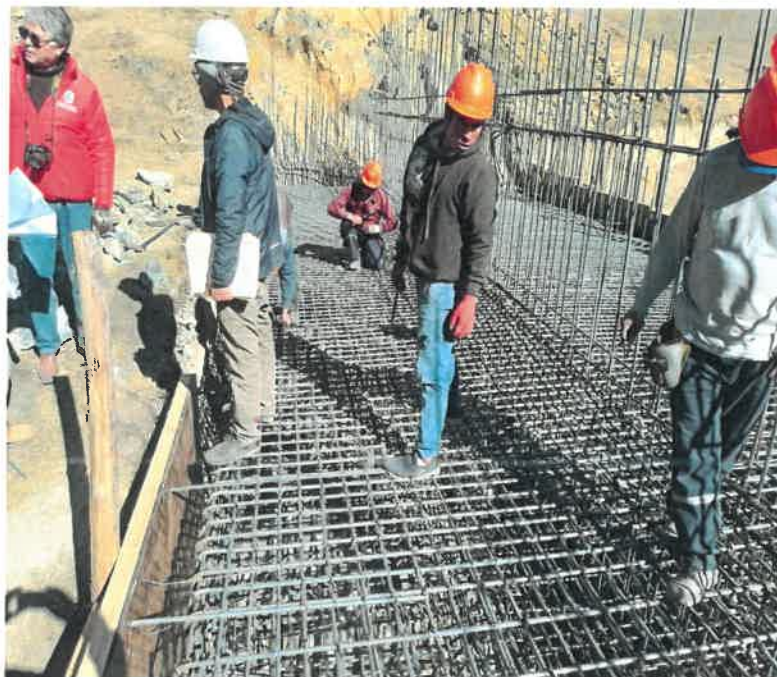
Vistas fotográficas en la que se constató laborar al personal obrero, No estuvo presente el Supervisor de Obra.
