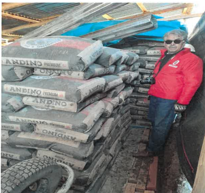
Inadecuado almacenamiento de cemento.
