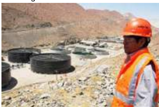
Imagen N°059 PTAR La Enlozada
