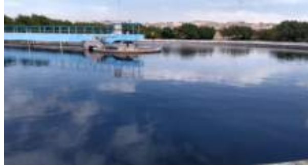
Imagen N° 048 Sedimentador Secundario PTAR Escalerilla
