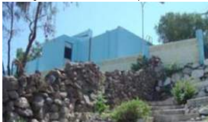
Imagen N°032 Reservorio R20 Capacidad: 460 m 3
