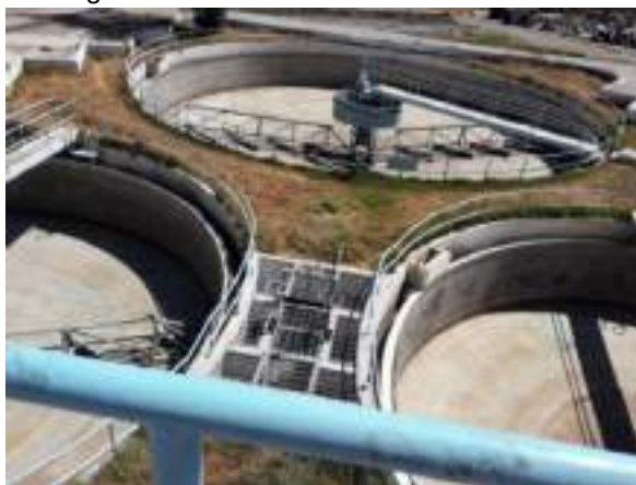
Imagen N°057 Sedimentadores Secundarios
