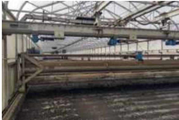
Imagen N°052 Evacuación de Lodos PTAR Escalerilla
