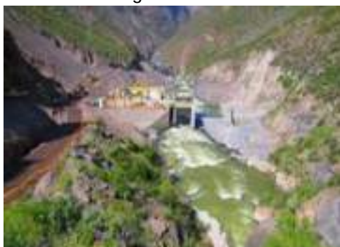
Imagen N°004 Vista desde aguas arriba de la Bocatoma PTAP MCI
