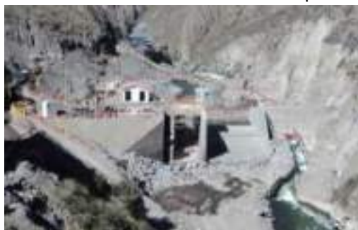
Imagen N°005 Vista de la Bocatoma durante época constructiva
