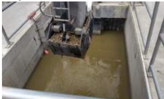
Imagen N°044 Cuchara Bivalva PTAR Escalerilla
