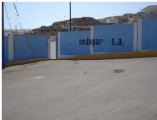
Imagen N° 097: Cerco perimétrico de Cocachacra
