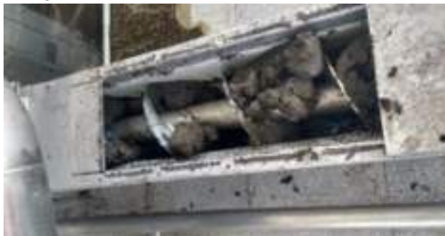
Imagen N°050 Acondicionamiento Químico del lodo
