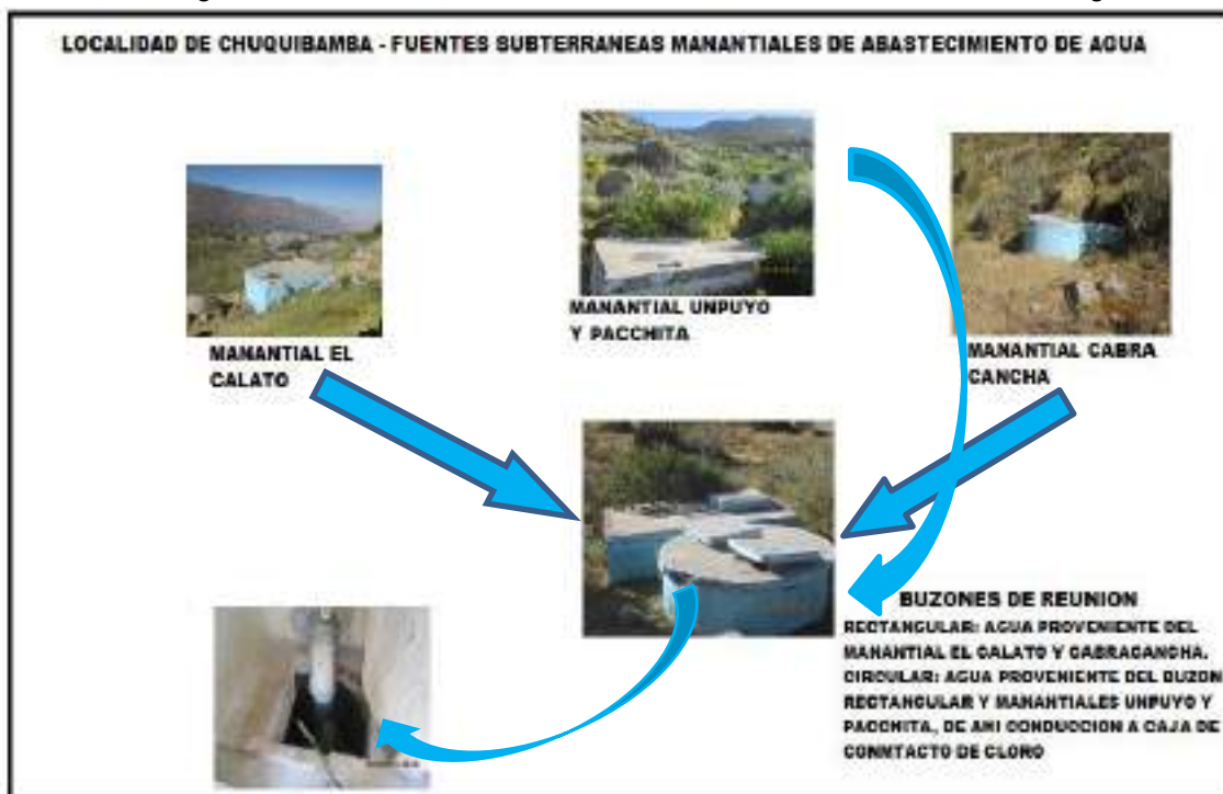
Imagen N°155 Fuentes subterránea manantiales de abastecimiento de agua
