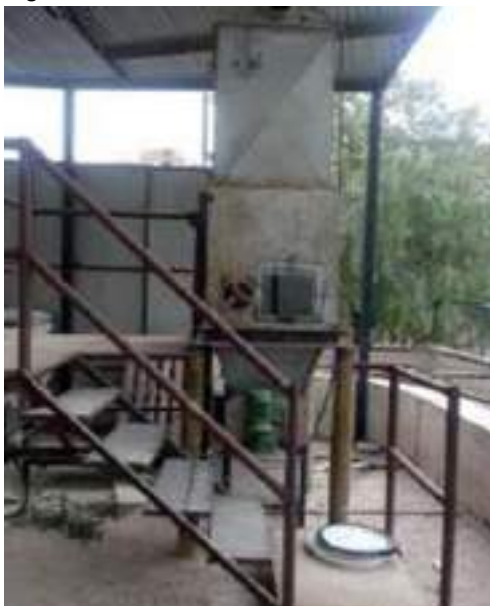
Imagen N°019 Dosificador de carbón activado
