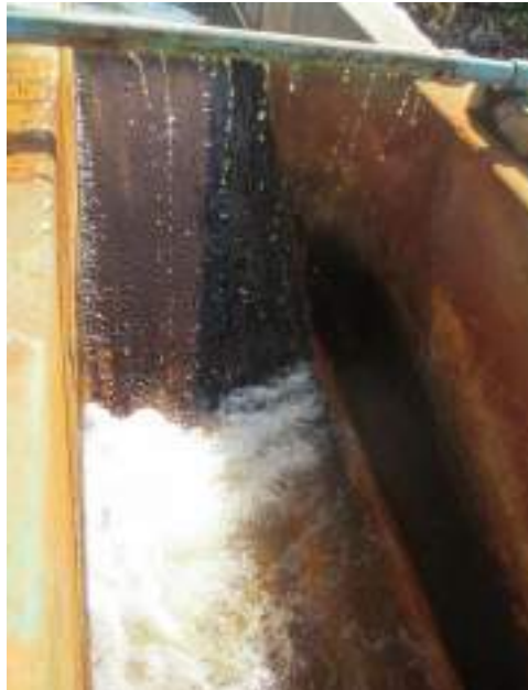
Imagen N°083 Canal Rectangular, mezcla rápida
