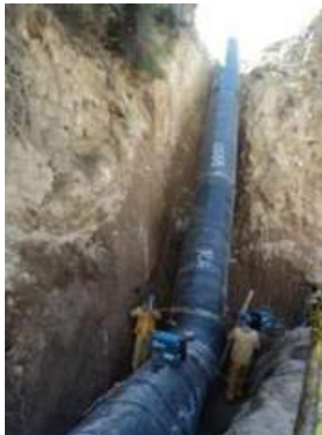
Imagen N°008 Instalación de la forzada N°1 PTAP MCI
