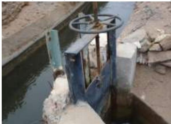
Imagen N°069 Compuerta captación de Canal Ensenada Mejía Mollendo
