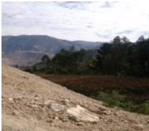
Zona de deslizamiento adyacente a la captación
