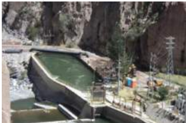
Imagen N° 009 Puente N°2 PTAP MCI
