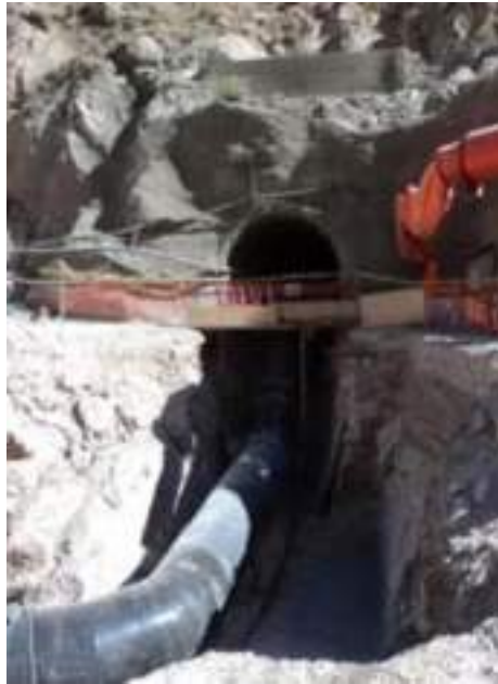
Imagen N°007 Instalación de la tubería a la salida del túnel N°1
