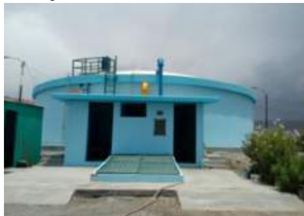
Imagen N°042 Reservorio R-33 Santa María
