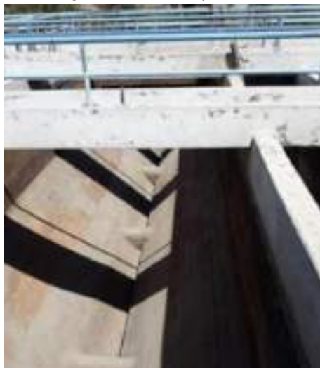
Imagen N°055 Tanques Imhoff
