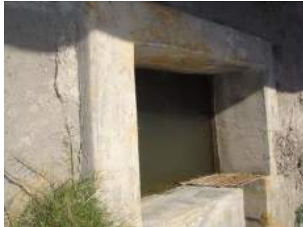
Imagen N°102 Caja Desarenadora
