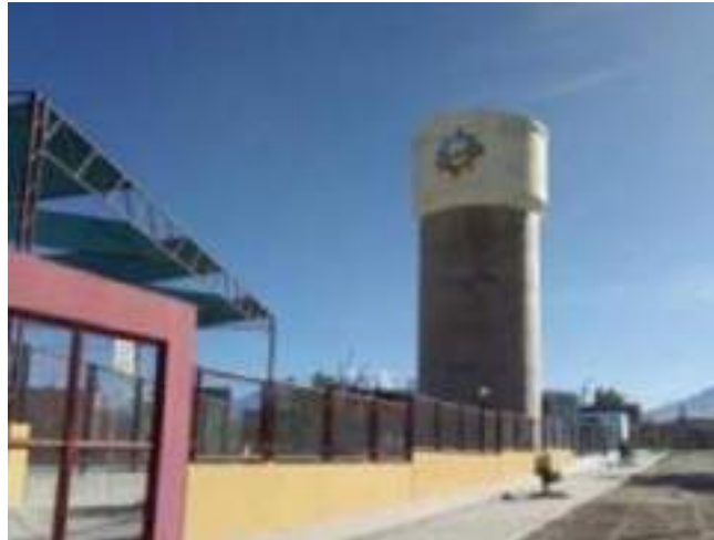
Imagen N°034 Reservorio R-35, tipo elevado capacidad 250 m 3
