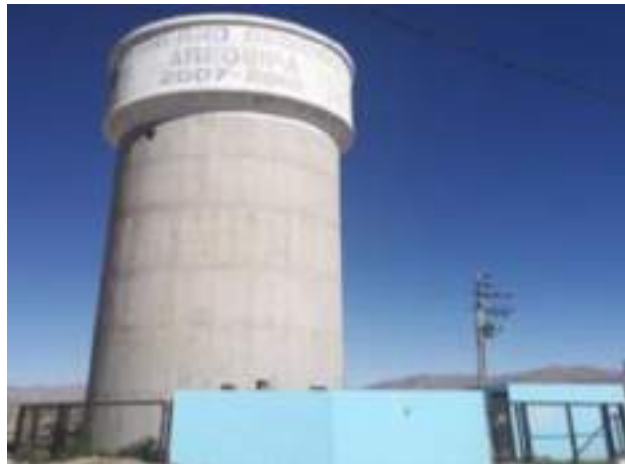
Imagen N°035 Reservorio R-36, tipo elevado capacidad 200m 3 .
