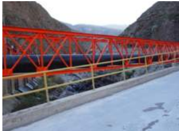
Imagen N°006 Puente N°1 del Tramo 1 de la Línea de conducción
