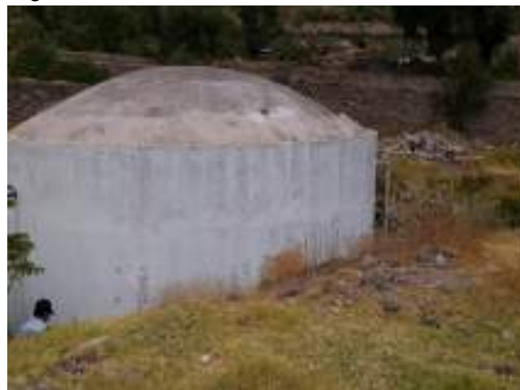
Imagen N°148 Vista del Reservorio R2 cerco rustico
