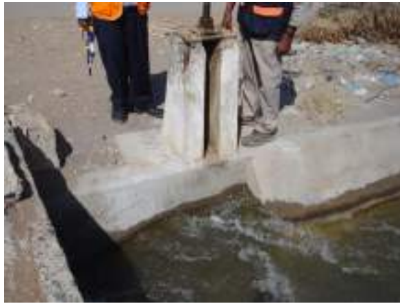
Imagen N° 127: Compuerta captación de Canal Ensenada Mejía Mollendo
