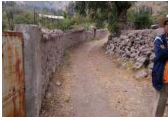
Imagen N°151 Vista cerco rustico y vías de acceso al reservorio
