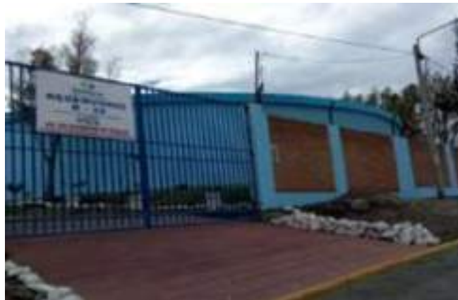
Imagen N°033 Reservorio R35 Capacidad 1000 m3
