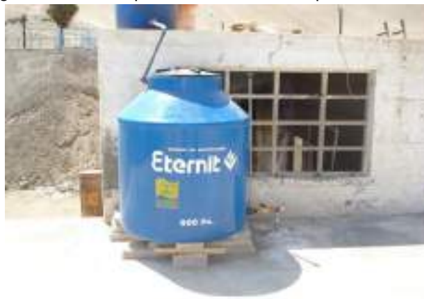
Imagen N° 109 Tanque con solución de Hipoclorito de Calcio
