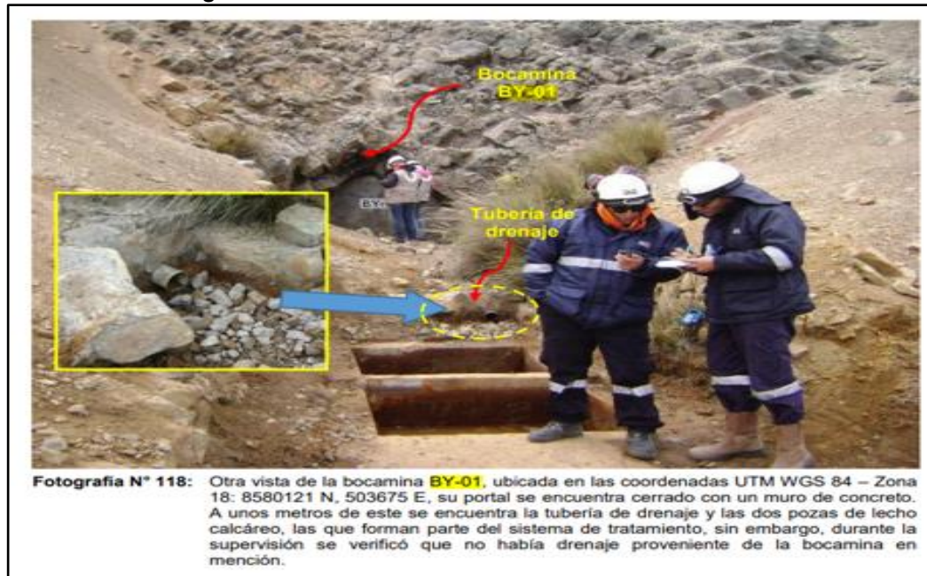
Imagen N° 25: Estado del efluente de la bocamina BY-01
