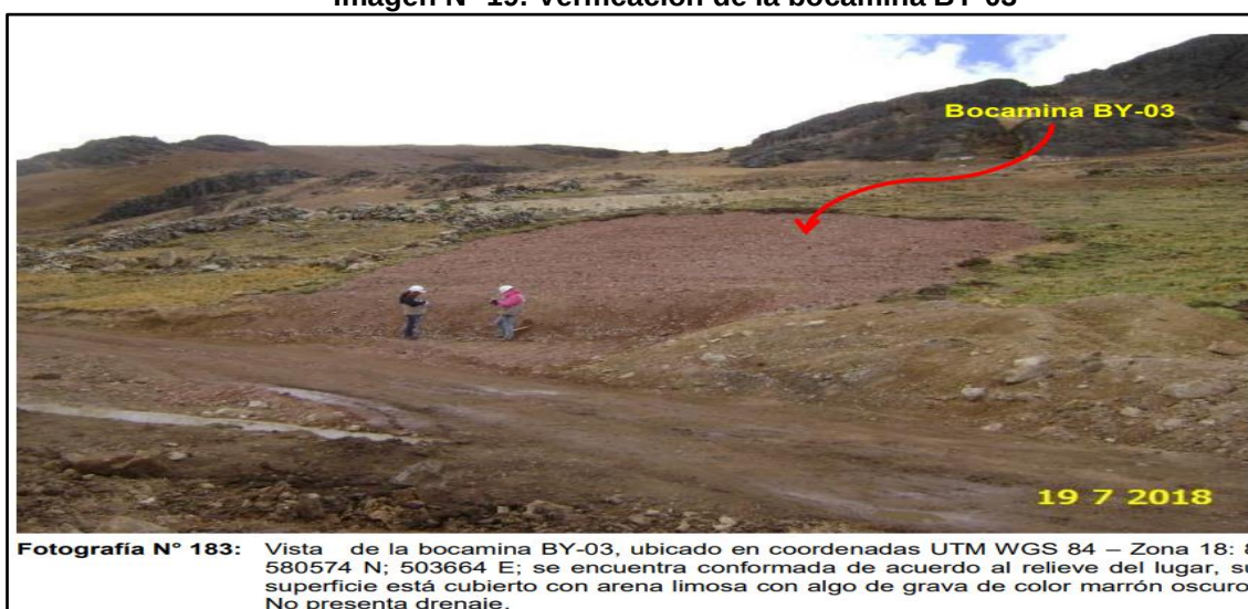
Imagen N° 19: Verificación de la bocamina BY-03
