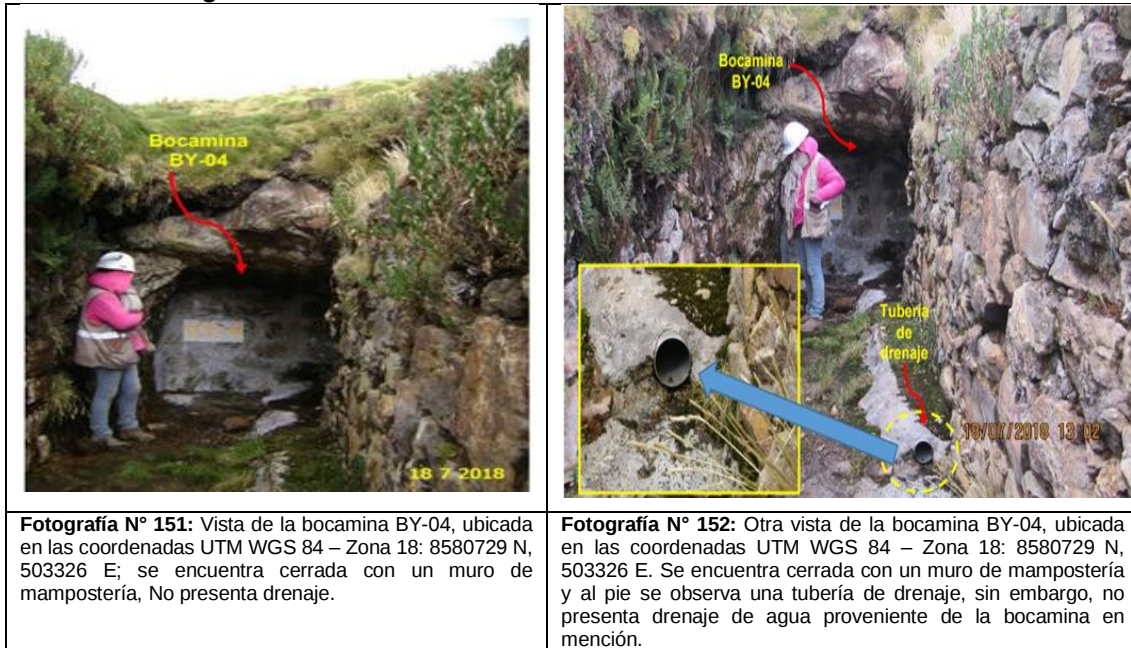
Imagen N° 23: Verificación del estado del efluente de la bocamina BY-04
