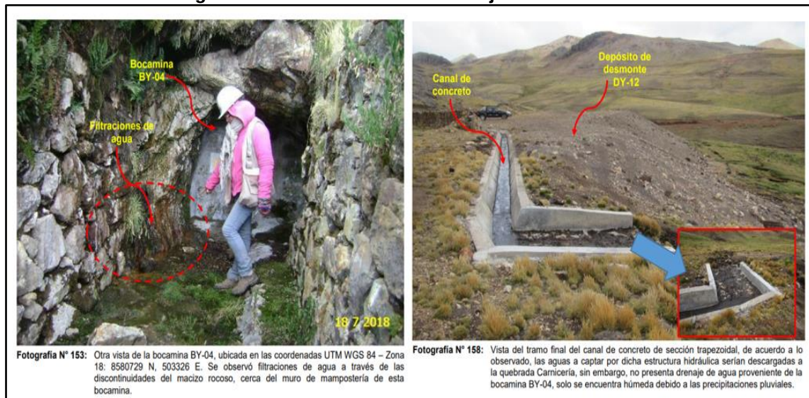
Imagen N° 24: Verificación del drenaje en la bocamina BY-04
