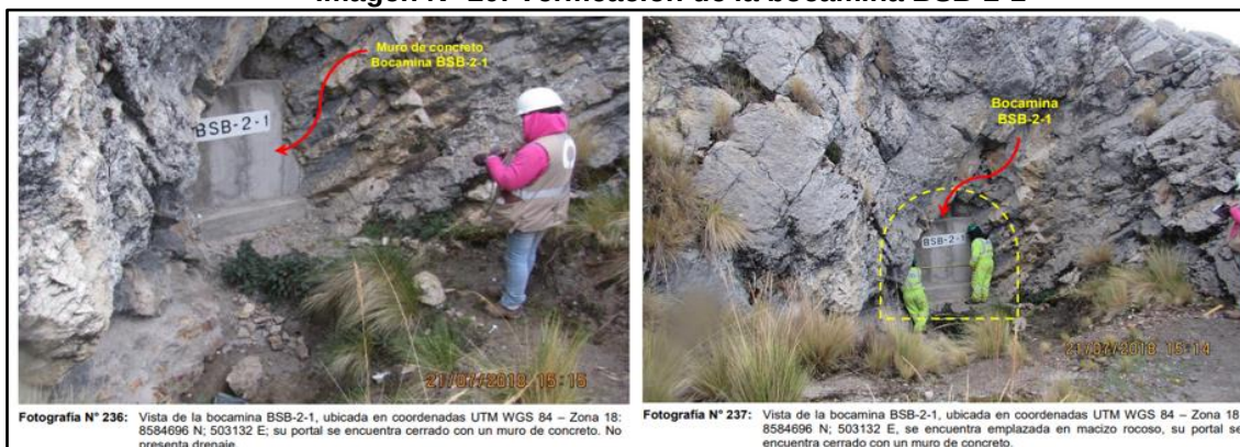
Imagen N° 20: Verificación de la bocamina BSB-2-1
