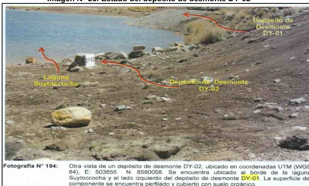
Imagen N° 36: Estado del depósito de desmonte DY-02
