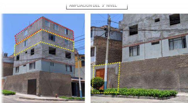
FOTO N.º 4: IDENTIFICACIÓN DE TRABAJOS DE CONSTRUCCIÓN (Fuente: equipo técnico SGOPC - La Perla 22.02.2023)
