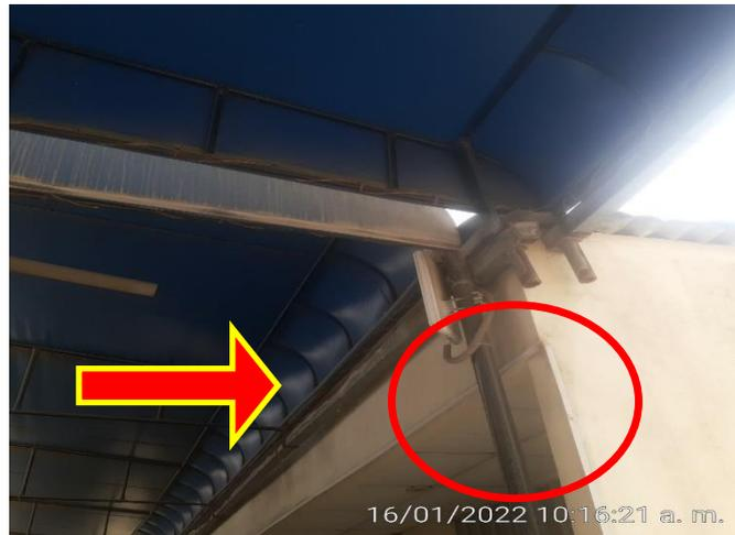
Estructura metálica oxidada y cunetas de PVC. No tiene zona de descarga CERITSS
