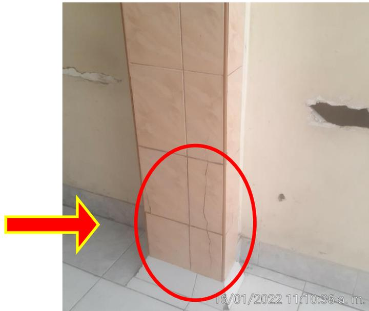
Clara evidencia que una columna que esta en condiciones críticas ni el enchapado lo arregla. Esto a causa de humedad y acero oxidado
