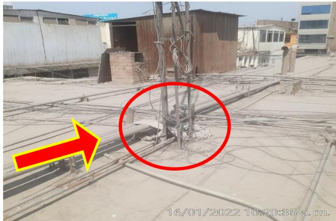
Antena sin base (Carga puntual) posible punzonamiento, puede perforar el techo eventualmente
