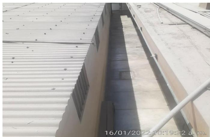
Falta de Canaletas en techo para evacuación y desvío de agua para no mojar las paredes.
