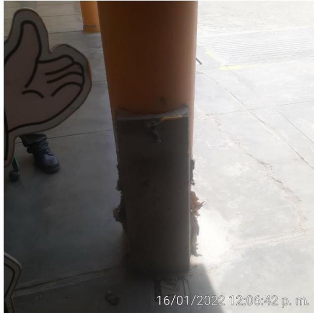
Grifo de riego o caño de limpieza está columna debe estar protegida del agua. Falta de desague de evacuacion de líquidos.
