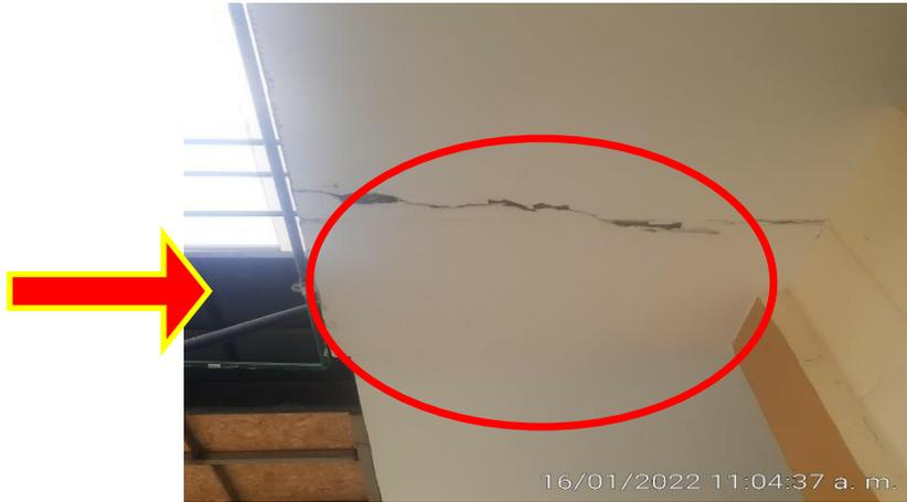
Fisura de techo por junta sísmica cerca a seguridad y salud
