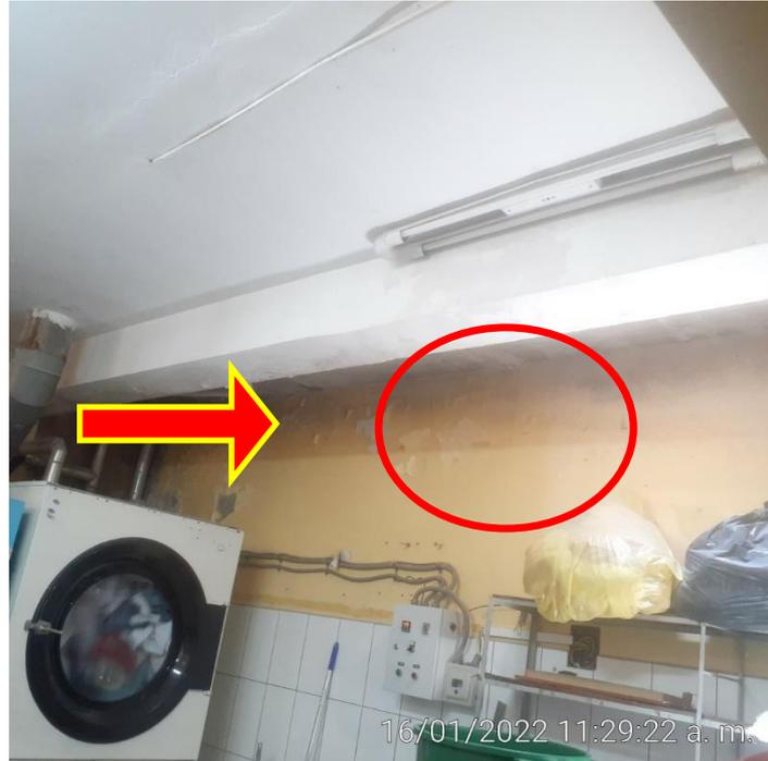
Zona fisurada en viga humedad constante.
