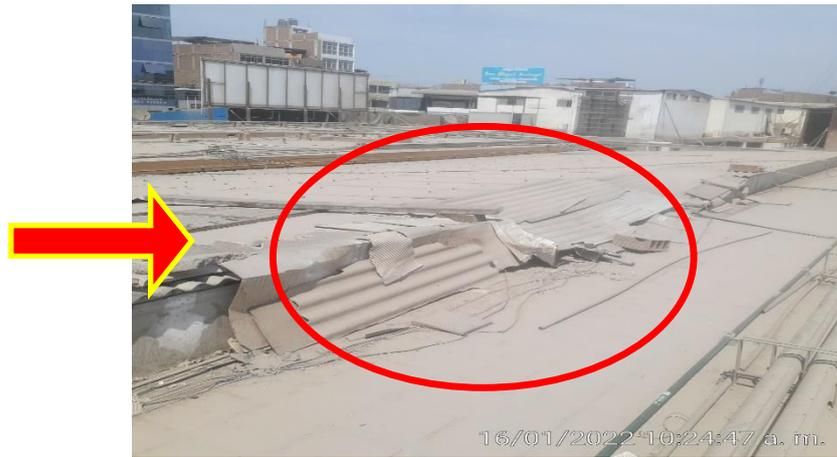
Calaminas mal colocada como tapas de ductos no esta fijadas al techo
