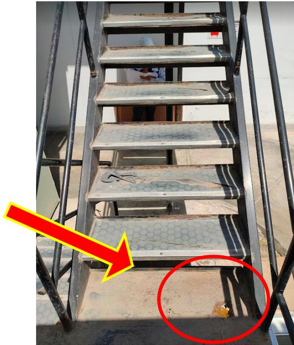
Escalera metálica deteriorada con perforación por desgaste, ubicado en el acceso a la jefatura de enfermería
