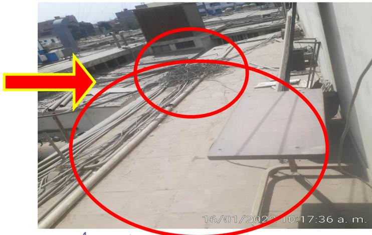
Cables amontonados o en desuso a foco de inflamación
