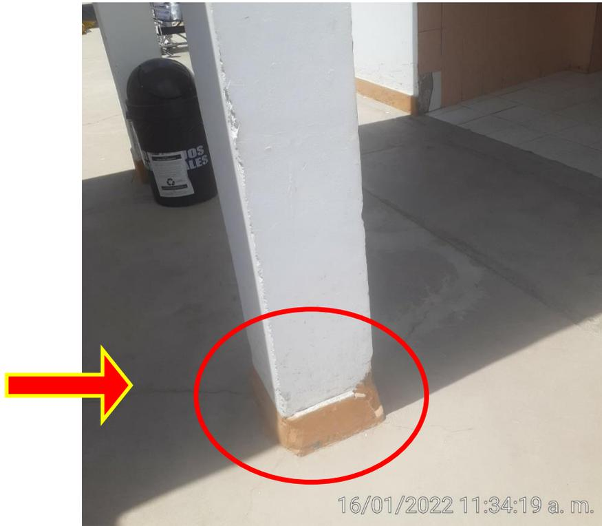
Columna dañada por impactos de otros objetos. Falta de protección en general de todas las columnas. Zona de servicios Generales
