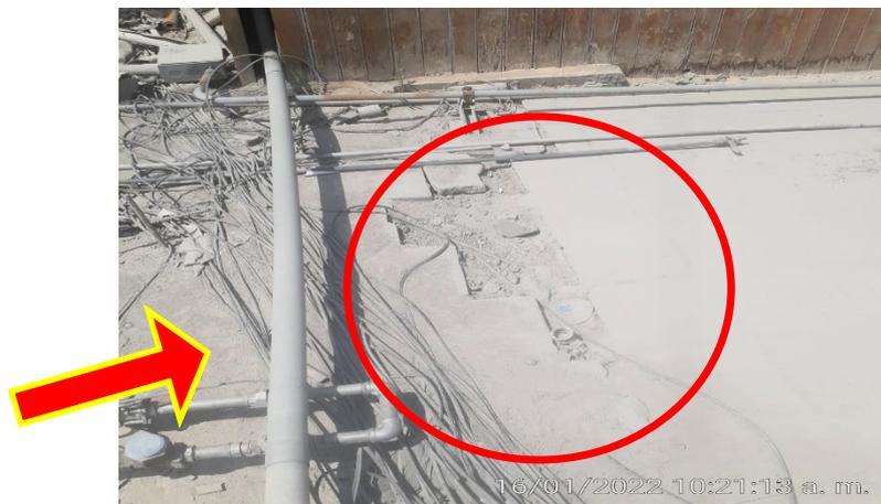
Ladrillo pastelero que sirve como protector posible humedad de techo y ocasiona oxidacion de acero de refuerzo
