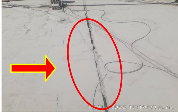
Falta de sellantes en la Juntas Sismicas que separan los bloque parte exterior em techos
