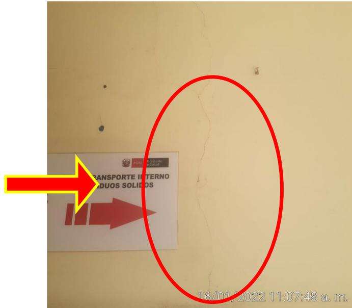
Muros con fisuras a causa de asentamiento diferenciales o a falta de una buena reparación de junta sísmica.
