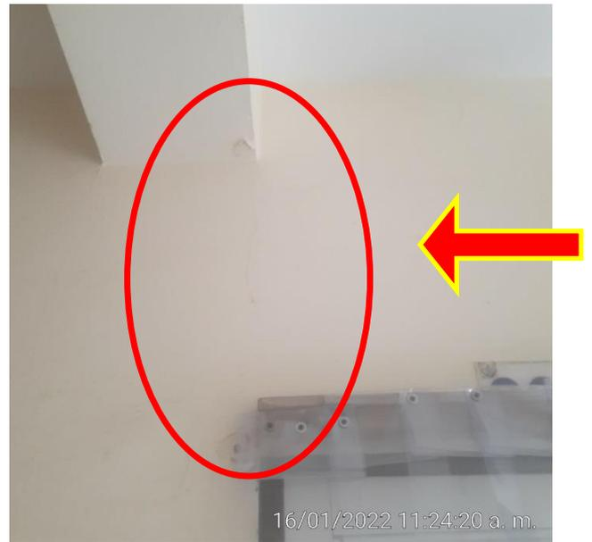
Fisura leve en Muro de bajo de Viga, esto indica una revisión total de este tipo Viga Muro o Viga Columna. Muchas veces las vigas se apoyan directamente em Muros Fisurandolos y no tener una adecuada separacion (cocina y corredores)
