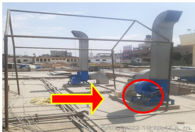
Falta de anclaje del extractor hacia las bases vibratorias esto genera vibraciones al techo generando que equipo colgados em el interior se suelten progresivamente.
