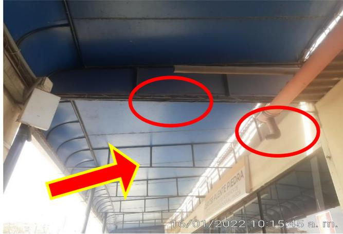
Estructura metálica Oxidada y cunetas de PVC. No tiene zona de descarga CERITSS
