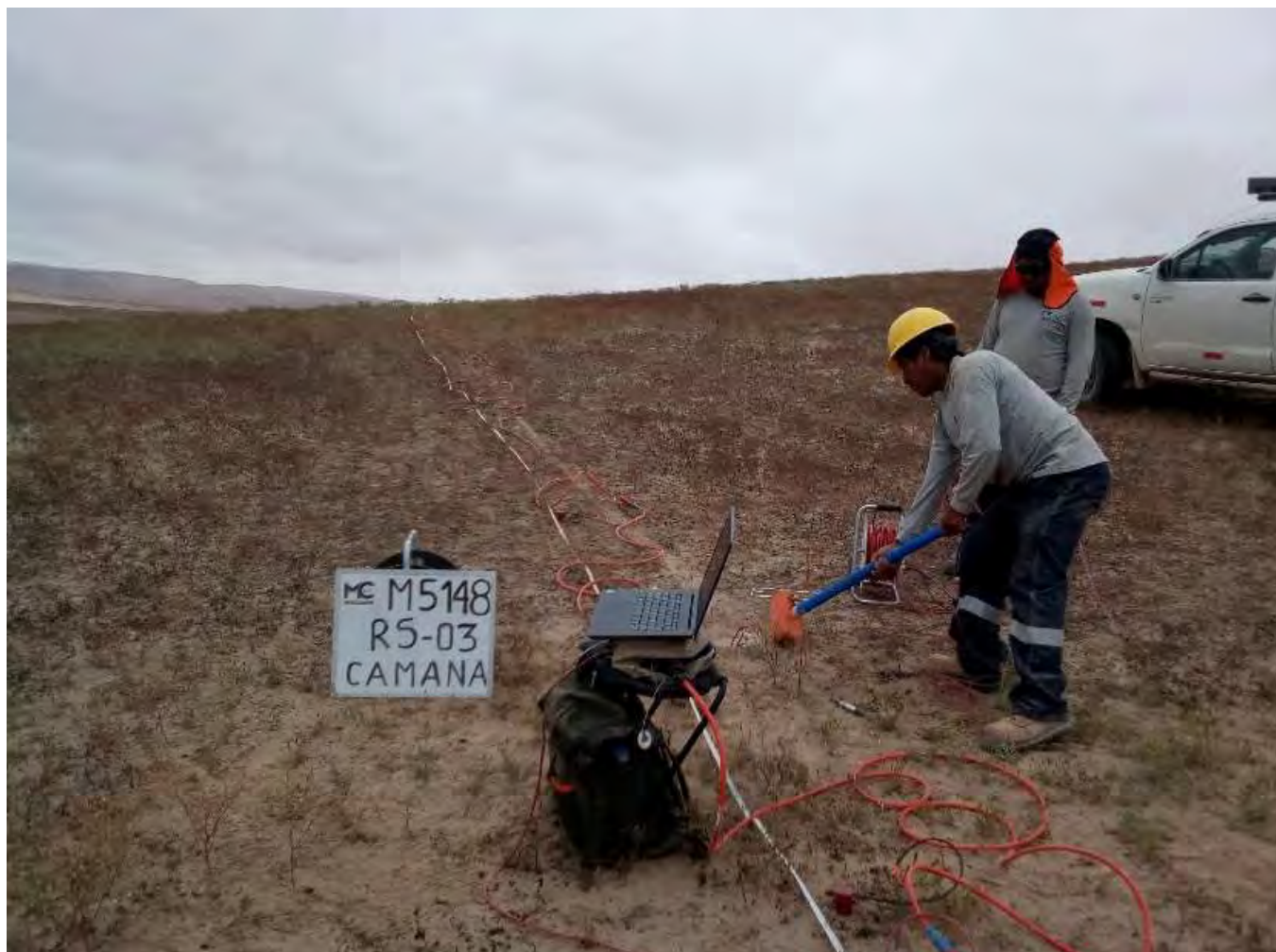
Foto 5: Ensayo Geofísico Refracción sísmica LS-3
