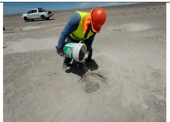
**Foto N° 12:** Adición de grava a la calicata 03 hasta un espesor de 5 cm.
