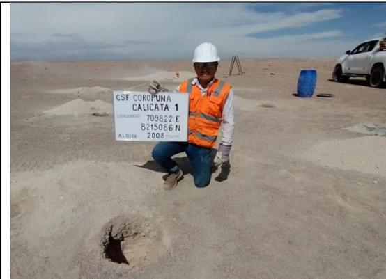
**Foto N° 03:** Excavación de la calicata 01 en superficie de 30cmx30cmx100cm de profundidad.
