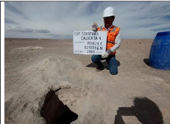
**Foto N° 15:** Excavación de la calicata 04 en superficie de 30cmx30cmx100cm de profundidad.
