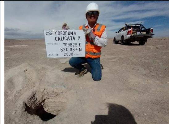
**Foto N° 07:** Excavación de la calicata 02 en superficie de 30cmx30cmx100cm de profundidad.
