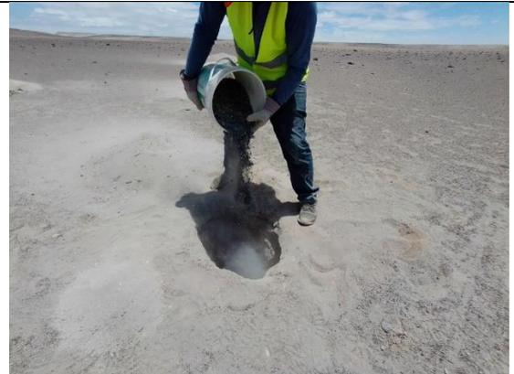
**Foto N° 20:** Adición de grava a la calicata 05 hasta un espesor de 5 cm.
