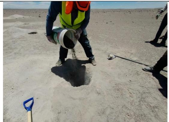
**Foto N° 24:** Adición de grava a la calicata 06 hasta un espesor de 5 cm.
