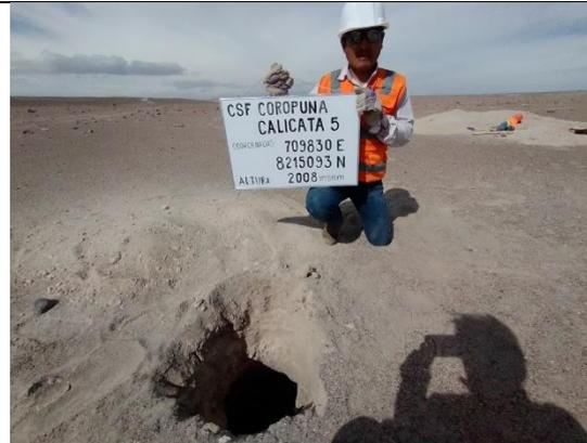
**Foto N° 19:** Excavación de la calicata 05 en superficie de 30cmx30cmx100cm de profundidad.
