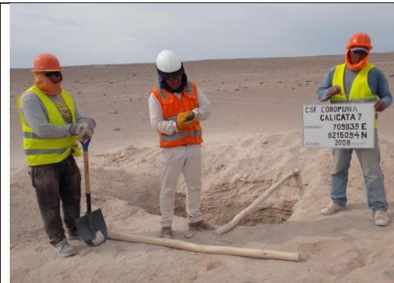
**Foto N° 27:** Excavación de la calicata 07 a profundidad de 2.5m x 2.5m x 4.5m de profundidad.
