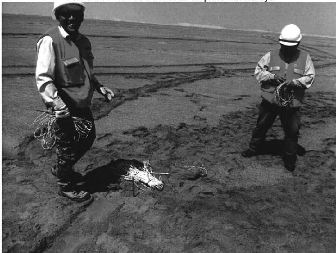
FOTO 06 SEV-01Tendido de cables electricos
