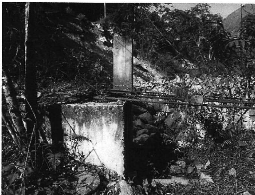
Fotografía 2.3.1-4: Estructura de concreto
