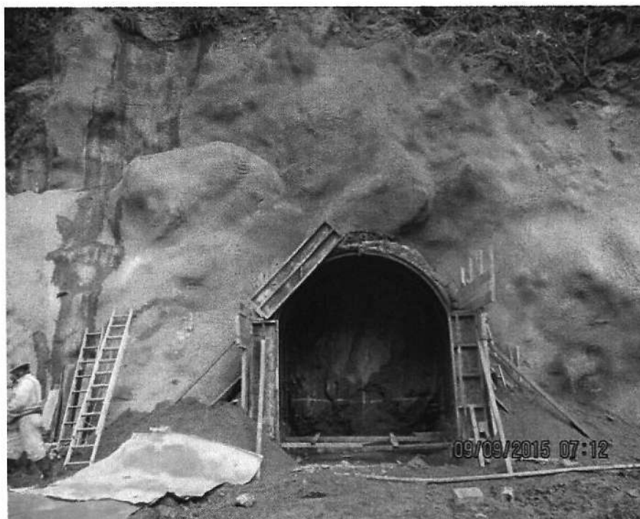
Foto Nº 01: V-0, Trabajos de afrontonamiento, mediante concreto lanzado, instalación de pernos sistemáticos, Spilling bar y malla electrosoldada, construcción del puente peatonal.
