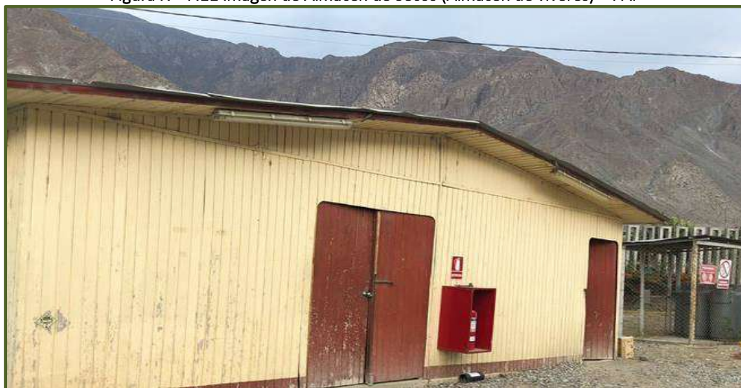
Figura N° 7.11 Imagen de Almacén de Secos (Almacén de víveres) – PAP
