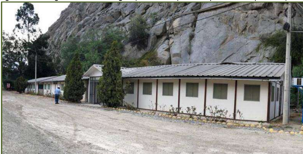
Figura N° 7.6 Imagen de "Oficinas Antiguas (Oficina de Supervisor 1 y Oficina de Supervisor 2) – PAP
