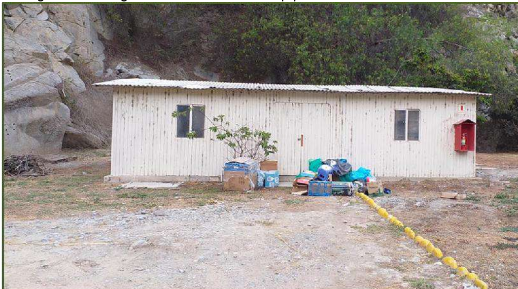
Figura N° 7.7 Imagen Frontal de “Almacén de equipos de materiales de monitoreo” – PAP
