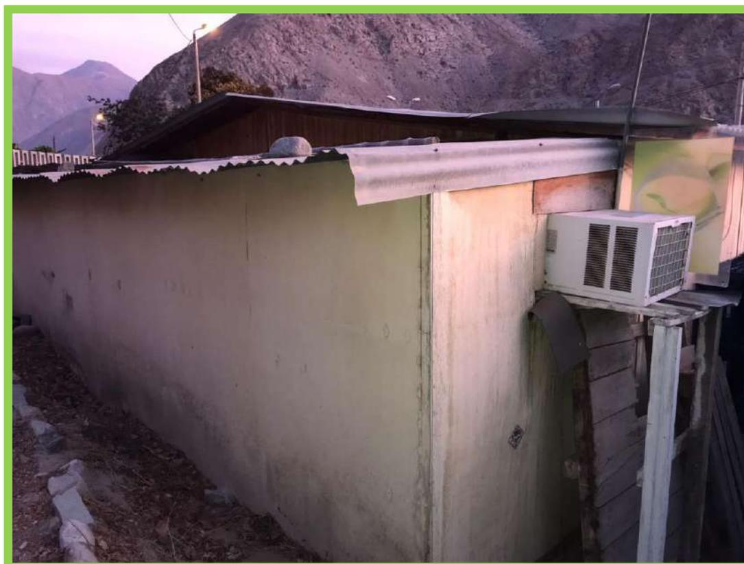
Imagen 05. Muros y cielo raso de paneles machiembrado prefabricado
