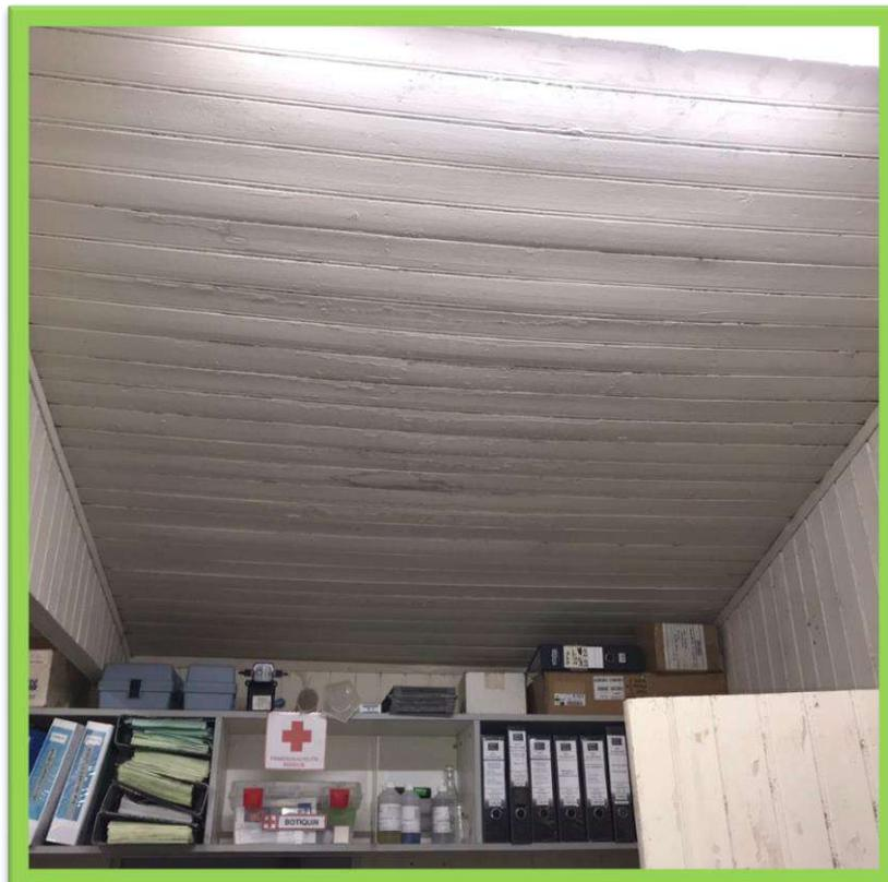
Imagen 08. Cielo raso con madera machiembrada prefabricada
