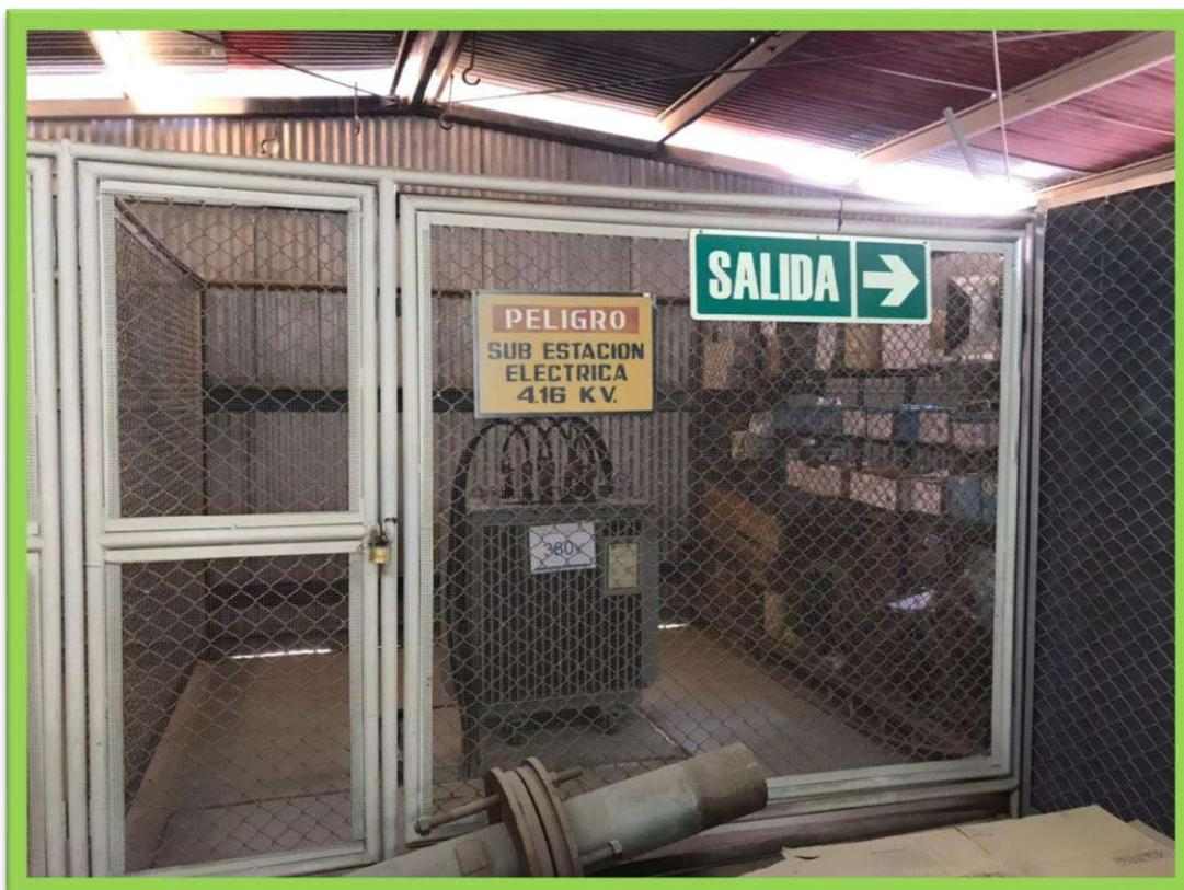
Imagen 7. División metálica con mallas olímpicas y tubos metálicos,
