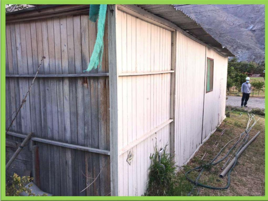
Imagen 06. Muros y cielo raso de paneles machiembreado prefabricado
