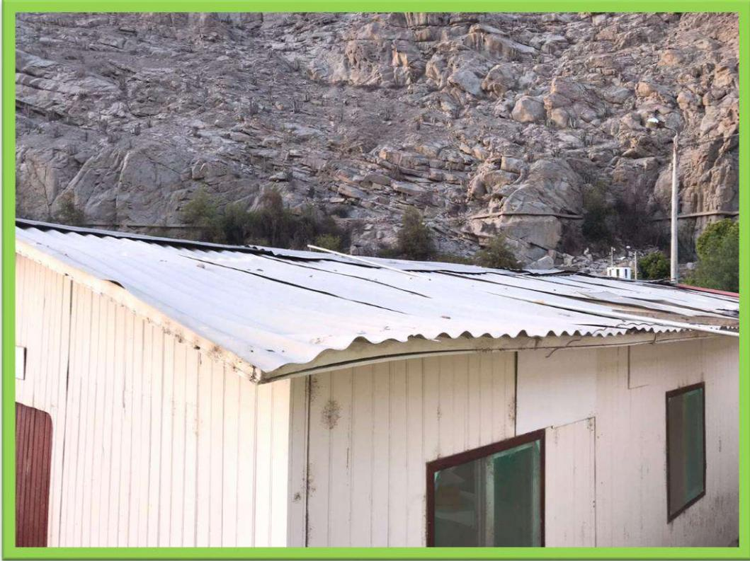
Imagen 05. Cobertura con calamina galvanizada del almacén 03
