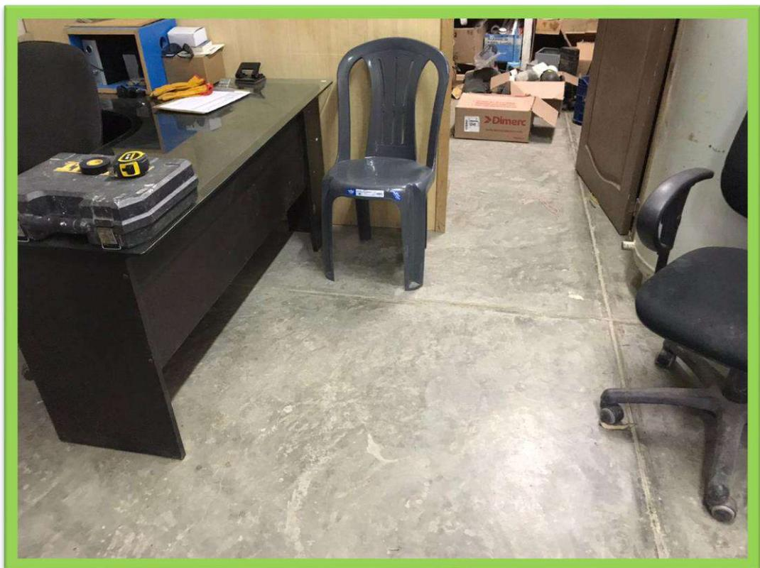
Imagen 10. Losa de concreto simple con acabado semi pulido.
