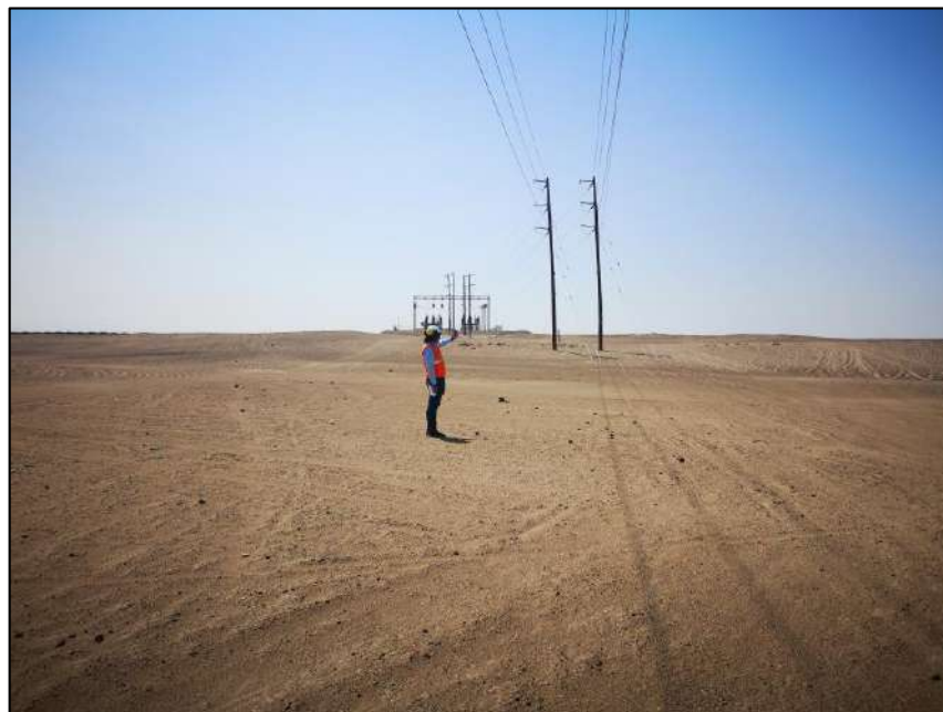
FOTO 1: MEDICIÓN DE LOS CAMPOS ELECTROMAGNÉTICOS EN LA PLANTA FOTOVOLTAICA MAJES SOLAR 20 TS
