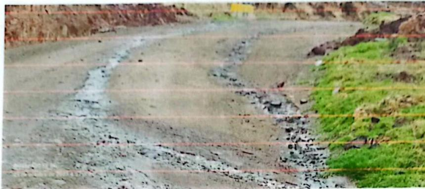
En la fotografía se muestra erosión creados por escurrimiento de agua que es paralelo al eje de la trocha carrozable:
