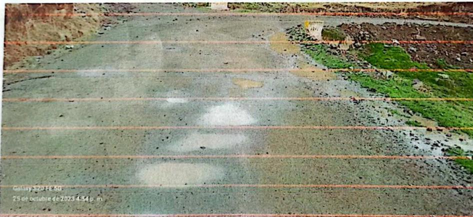
En la fotografía se muestra baches (huecos) resultan de aguas estancadas en la superficie de la trocha carrozable.
