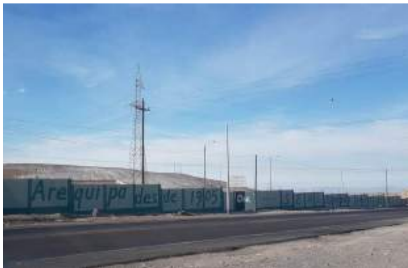
Fotografía N° 3.1 Vista del inicio de la línea de transmisión a la salida de la subestación Repartición
