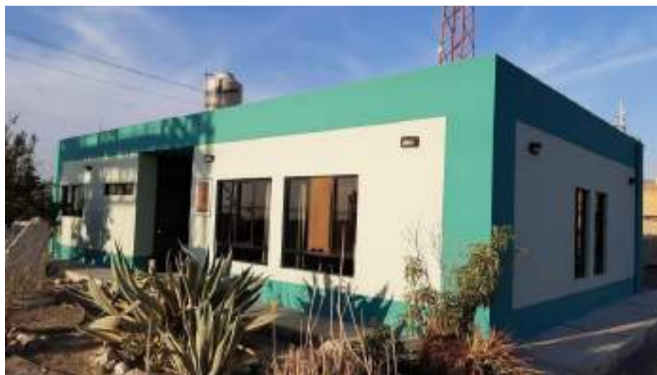
Fotografía N° 3.10 Vista de la Sala de Control
