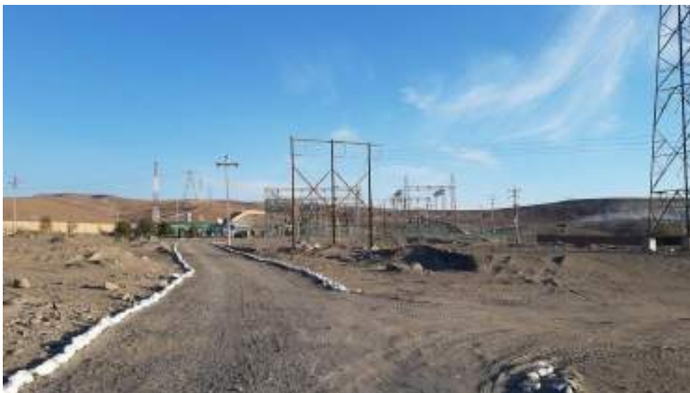
Fotografía N° 3.9 Vista del ingreso a la SE Repartición
