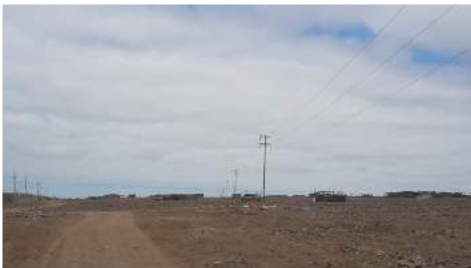
Fotografía N° 2: Vista de estructura intermedia de la línea de transmisión
