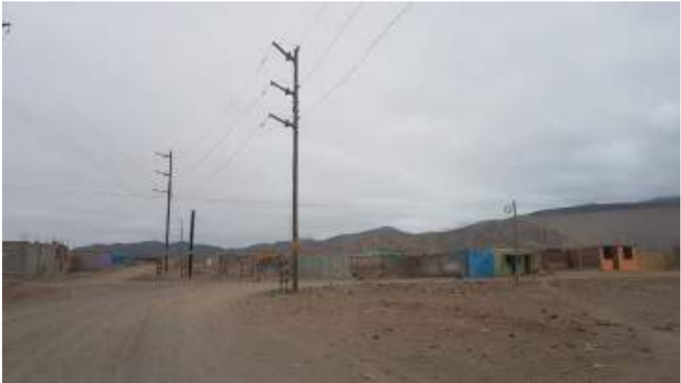
Fotografía N° 1: Vista de estructura intermedia de la línea de transmisión
