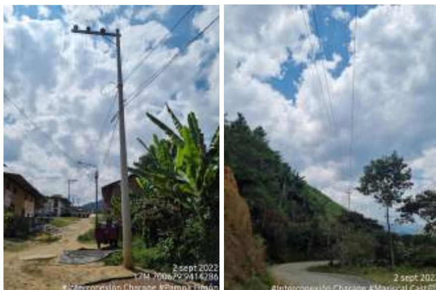
Ilustración 6: Vista de la ruta de acceso a la Línea de Interconexión Eléctrica en 22,9 kV C.H. Tabaconas – C.H. Charape
