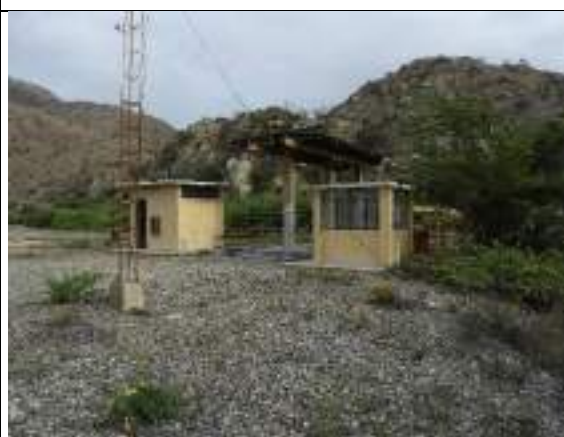
Fotografía 6.2-3 Caseta de control/vigilancia (PAD-CHG-02b)
