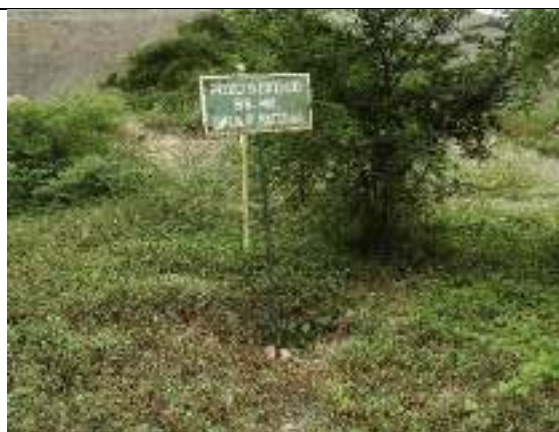
Fotografía 6.2-5 Pozo séptico (PAD-CHG-04)
