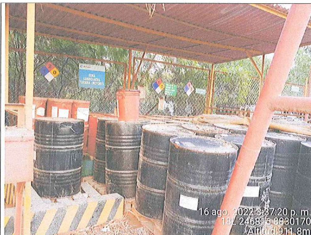
Fotografía N° 24: Almacén de lubricantes de la zona del Almacén Central de Materiales de la C.H. Cahua
