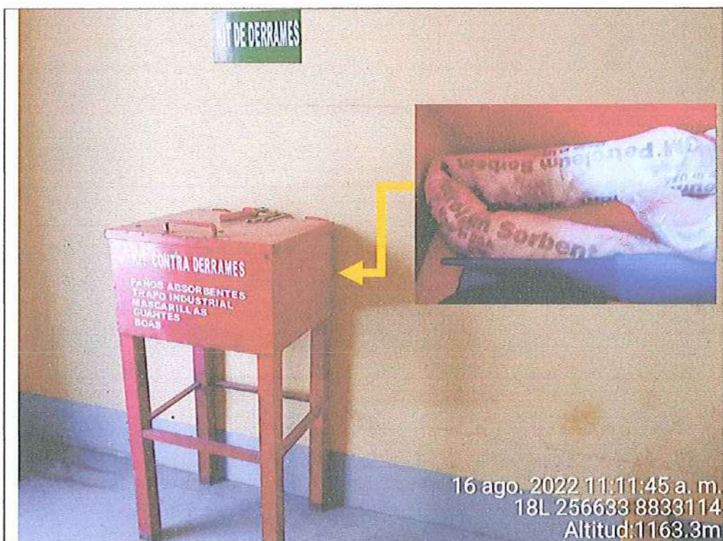
Fotografía N° 20: Almacén de lubricantes de la zona de la Bocatoma de la C.H. Cahua. Vista de la ubicación del Kit contra derrames,
