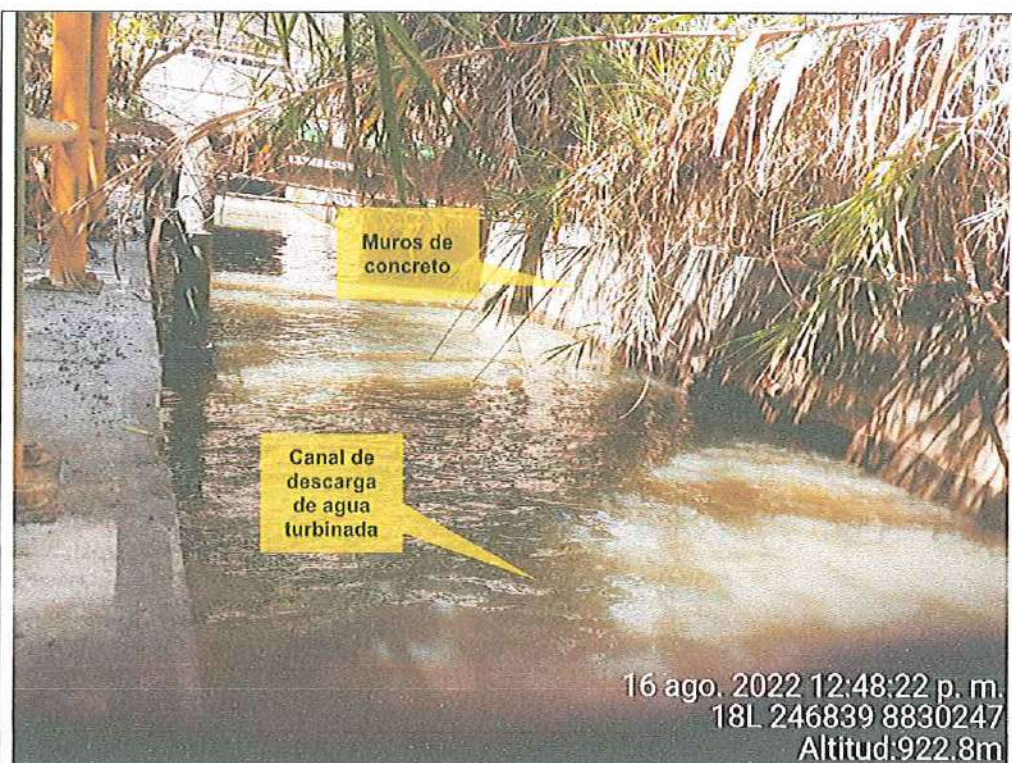
Fotografía N° 10: Muros de concreto del canal de descarga de las aguas turbinadas del grupo I
