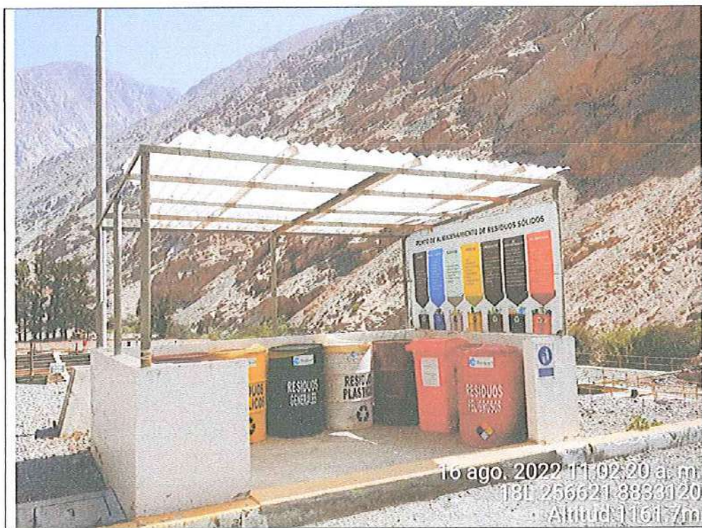
Fotografía N° 11: Punto de almacenamiento primario de residuos no peligrosos y peligrosos ubicado en el área de las instalaciones de la Bocatoma
