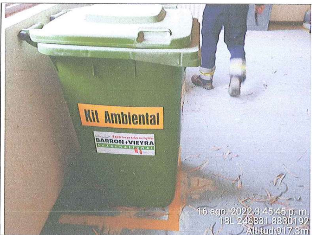
Fotografía N° 27: Kit contra derrames ubicado a unos 5m del Almacén de Pinturas y Solventes de la zona del Almacén Central de Materiales de la C.H. Cahua
