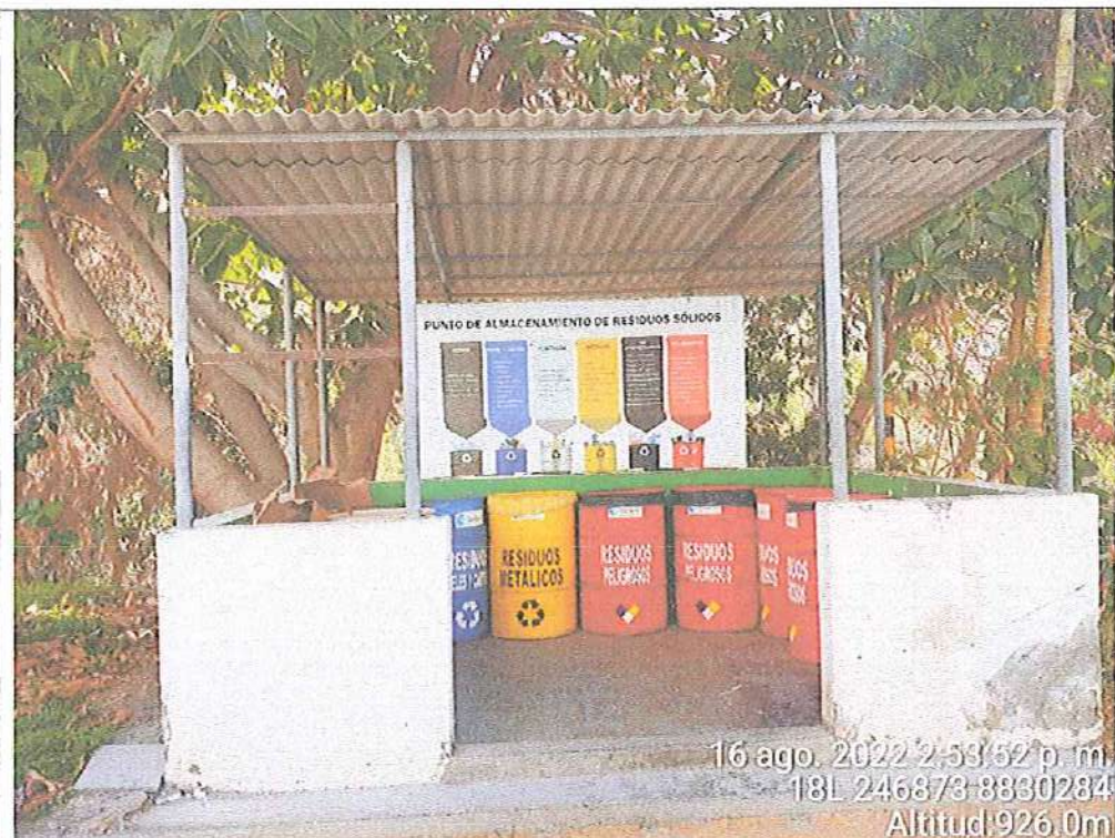
Fotografía N° 14: Punto de almacenamiento primario de residuos no peligrosos y peligrosos ubicado en el área de las instalaciones de la Casa de Máquinas, a 15m del Taller de Mantenimiento
