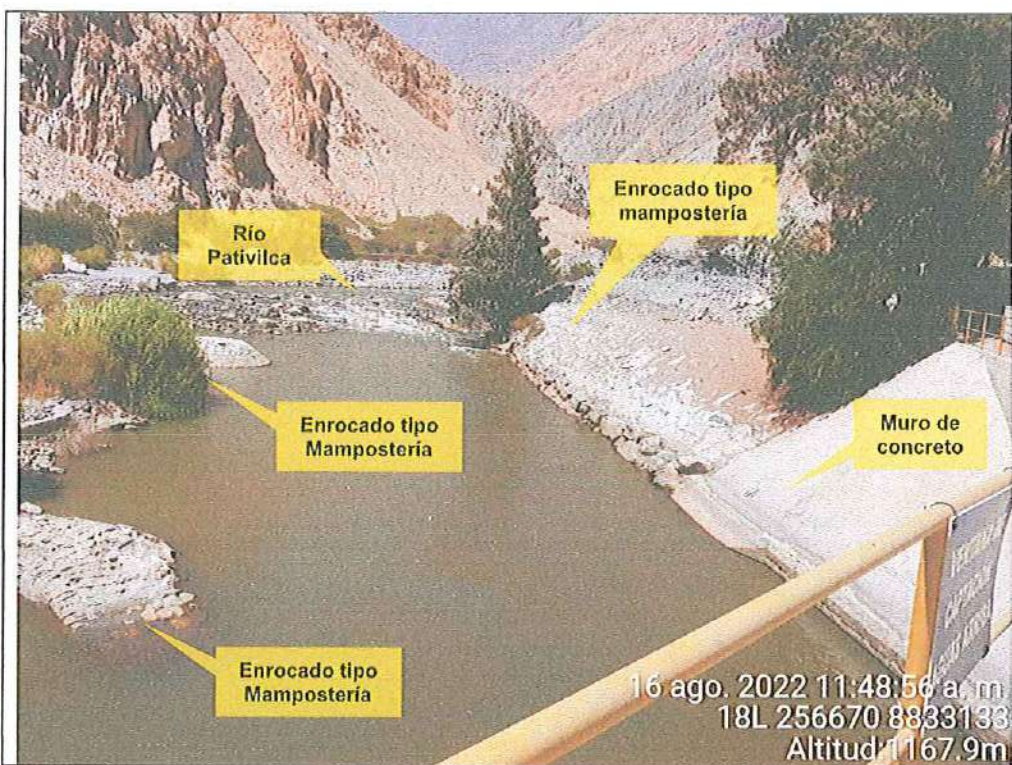
Fotografía N° 1: Vista panorámica de la zona de Bocatoma, aguas arriba de la presa, donde se cuenta con muros de concreto y enrocados tipo mampostería.
