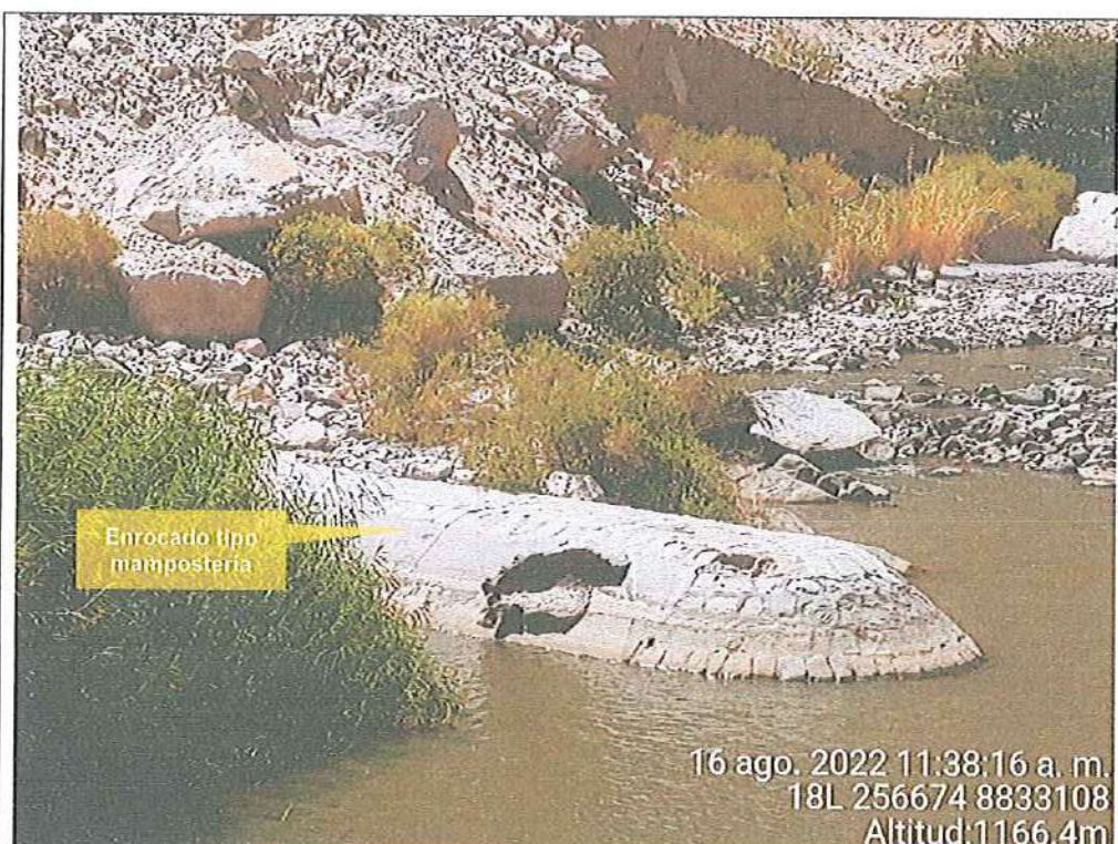
Fotografía N° 3: Zona de Bocatoma, aguas arriba de la presa, donde en la margen derecha de la presa se cuenta con muros de concreto y enrocados tipo mampostería.
