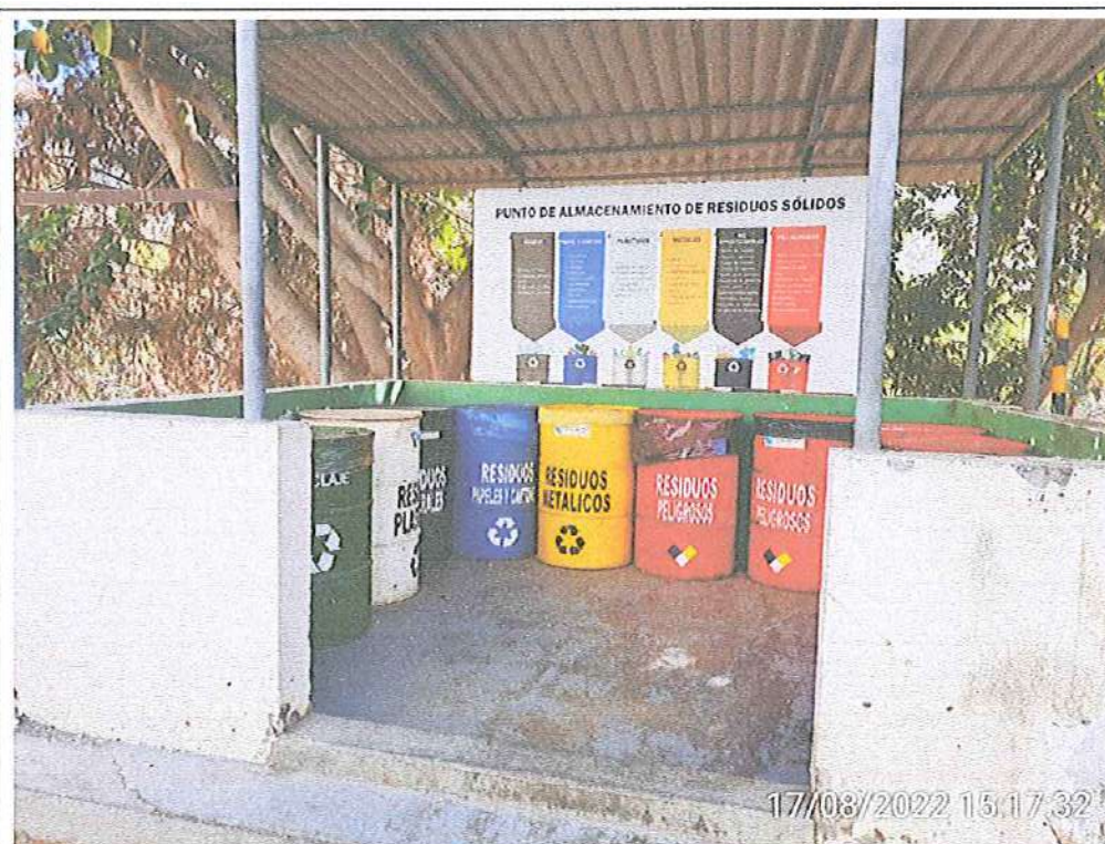
Fotografía N° 15: Otra vista interna del punto de almacenamiento primario de residuos no peligrosos y peligrosos ubicado en el área de las instalaciones de la Casa de Máquinas, a 15m del Taller de Mantenimiento
