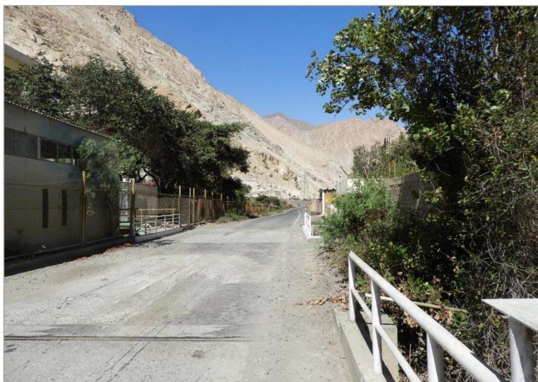
Fotografía 16. Vista del estado del sector de Vía Nacional Pativilca – Cajatambo, próximo a la Central Hidroeléctrica Cahua.
