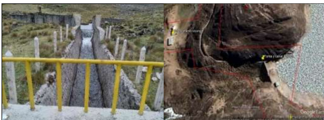
Imágenes 5 y 6. Componente principal Toma y canal Pushca, coordenadas UTM WGS 84, zona 18 L, 297 575 m E y 8 848 313 m S.
