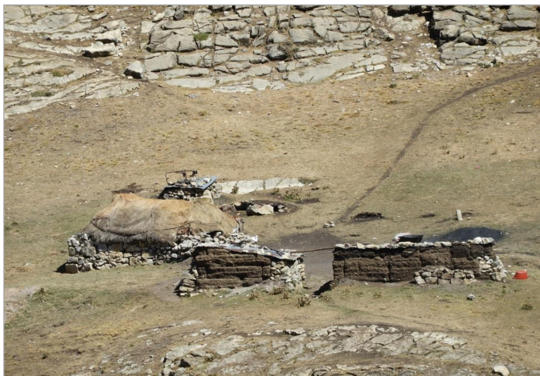
Fotografía 6. Vista de viviendas cercanas a la Estación Viconga (CH Cahua 1), conocida como zona Guñug. _Las viviendas están construidas de roca, adobe y barro, además de “paja” (la cual es parte de la vegetación del área). Las familias desarrollan la actividad ganadera con pastoreo estacionario.
