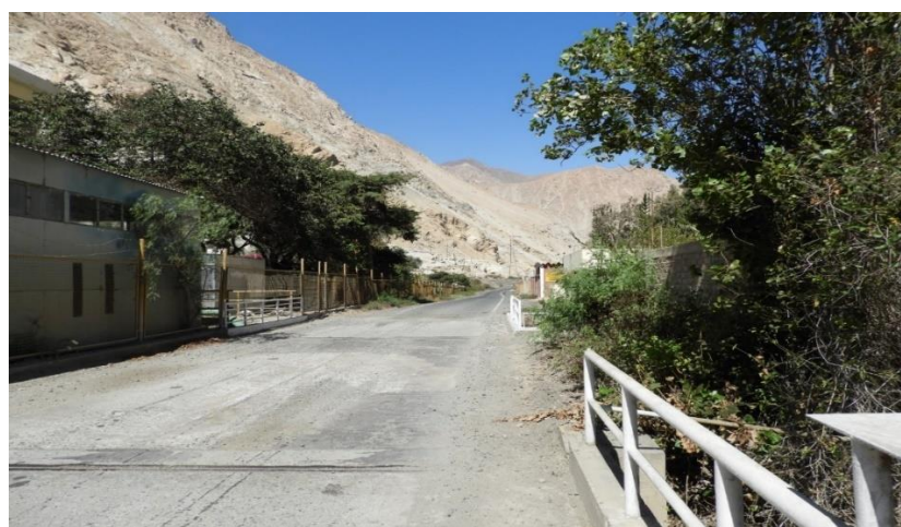
Fotografía 17. Estado de la Vía Nacional Pativilca-Cajatambo próximo a la central hidroeléctrica Cahua. Fecha: 03/07/2022
