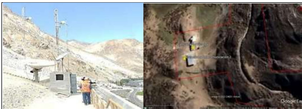
Imágenes 11 y 12. Componente auxiliar Estación de telecomunicación 2, coordenadas UTM WGS 84, zona 18 L, 297 410 m E y 8 848 342 m S.
