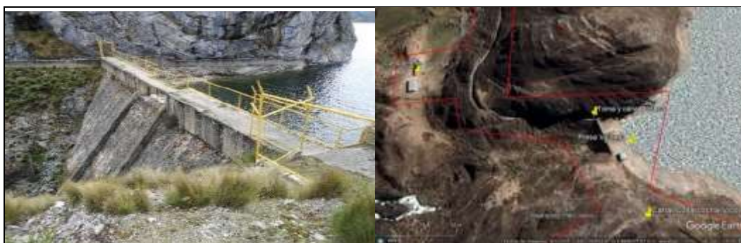
Imágenes 9 y 10. Componente principal Presa Viconga, coordenadas UTM WGS 84, zona 18 L, 297 603 m E y 8 848 287 m S.
