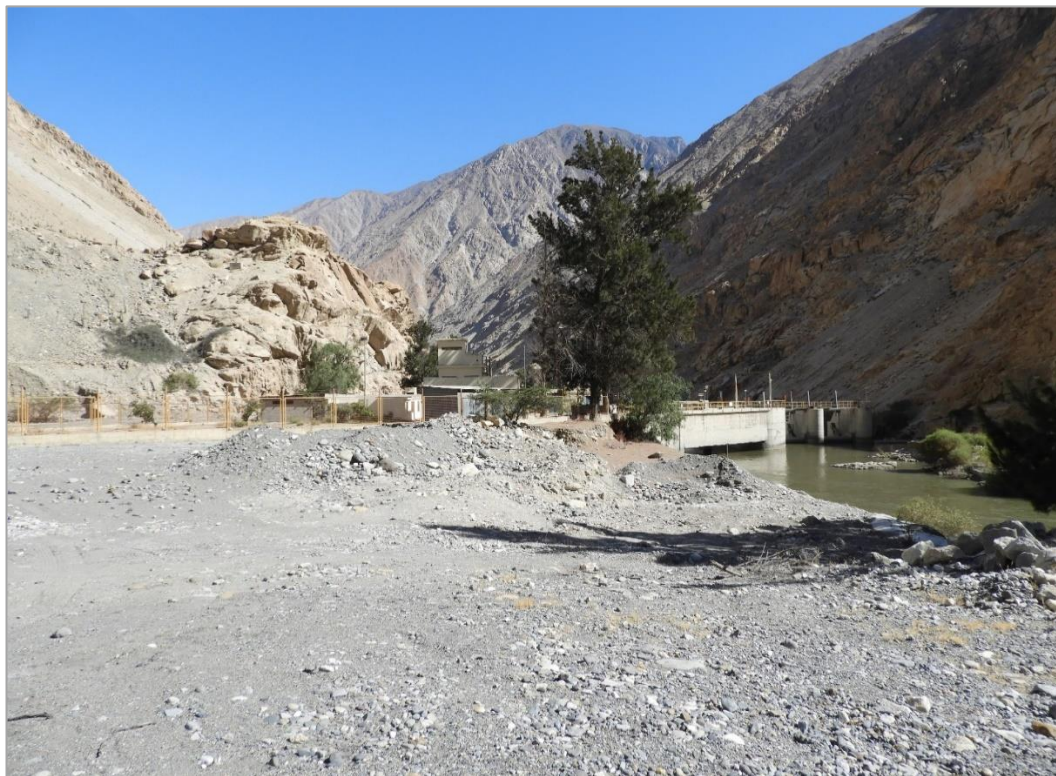
Fotografía 13. Vista trasera y lateral de la Central Hidroeléctrica Cahua "Bocatoma y el ingreso de aguas del Río Pativilca.
