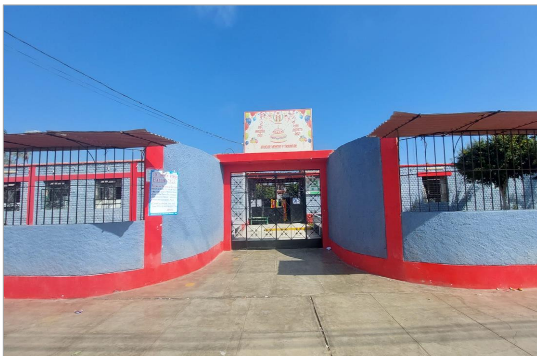
Fotografía 29. Institución Educativa 21578 ubicado frente a la Plaza Mayor del Distrito de Paramonga.
