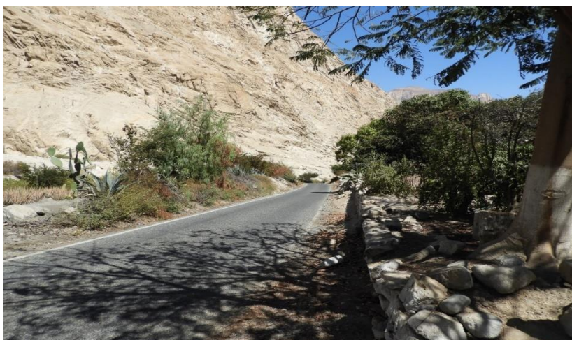
Fotografía 20. Estado de la Vía Pativilca-Cajatambo adyacente al Fundo Paccha. Fecha: 03/07/2022
