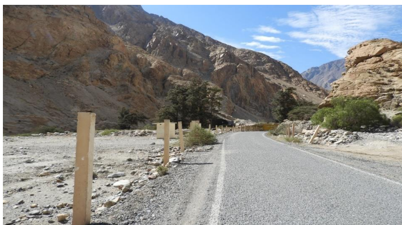
Fotografía 13. Vía Nacional Pativilca-Cajatambo.
