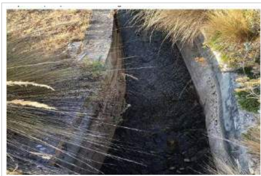
Figura 3.3 - 12 Canal de descarga
