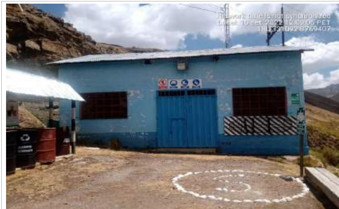
Figura 3.3 - 11 Vista panorámica de la Casa de máquinas
