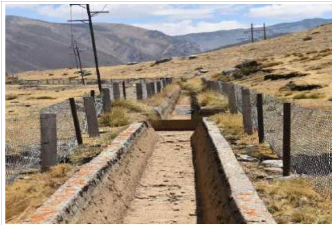
Figura 3.3 - 4 Canal de conducción
