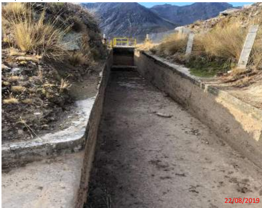
Componente principal: Cámara de carga
