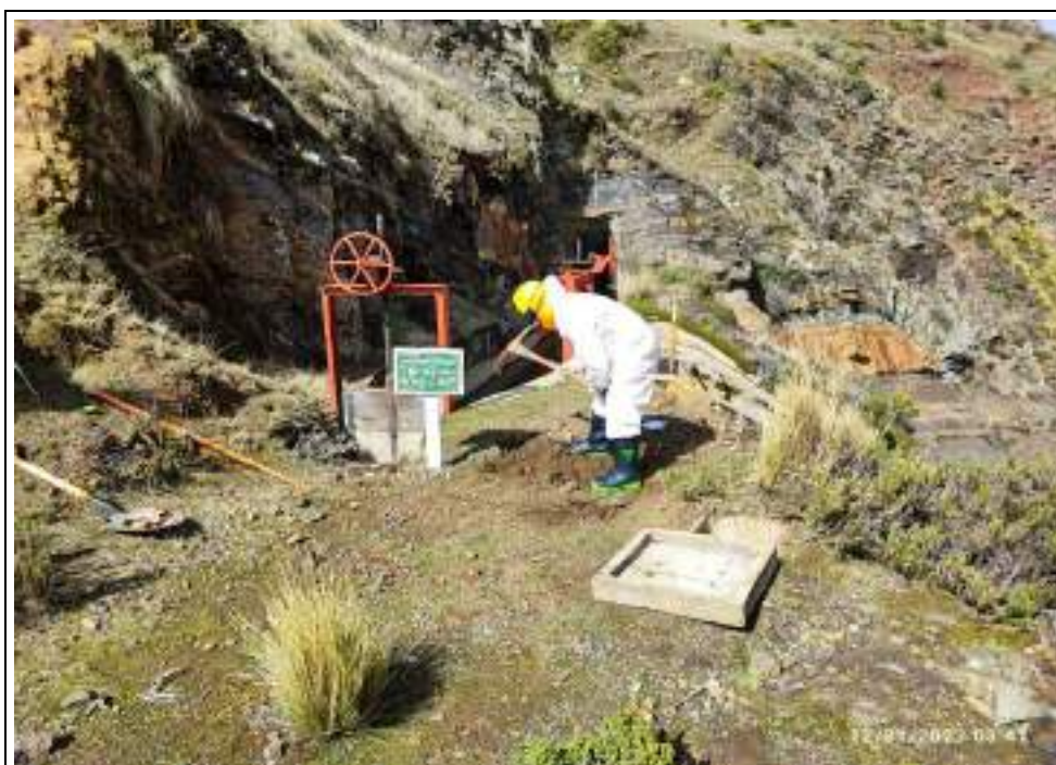
Foto N°2: Preparación de la calicata para dar inicio a la prueba de Percolación
