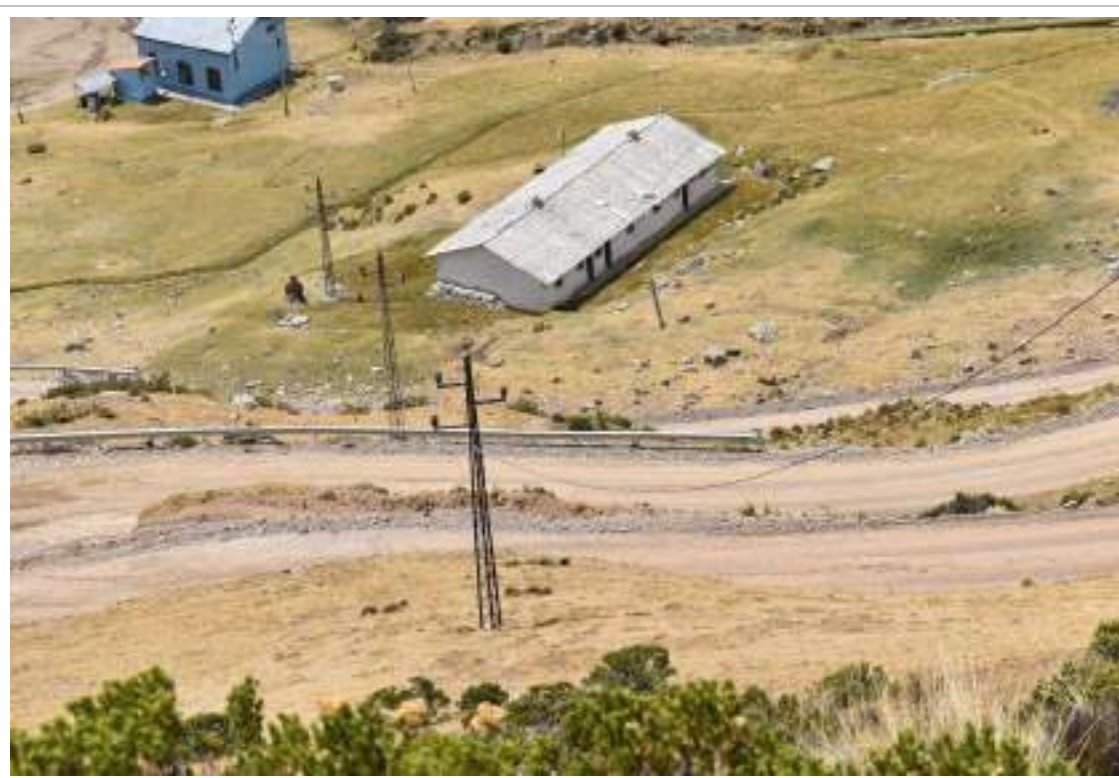
Figura 3.3 - 13 Línea de Transmisión
