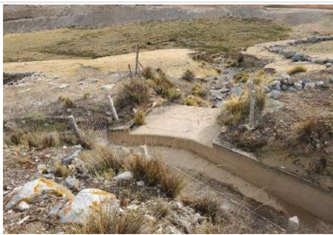
Figura 3.3 - 6 Canal de demasías
