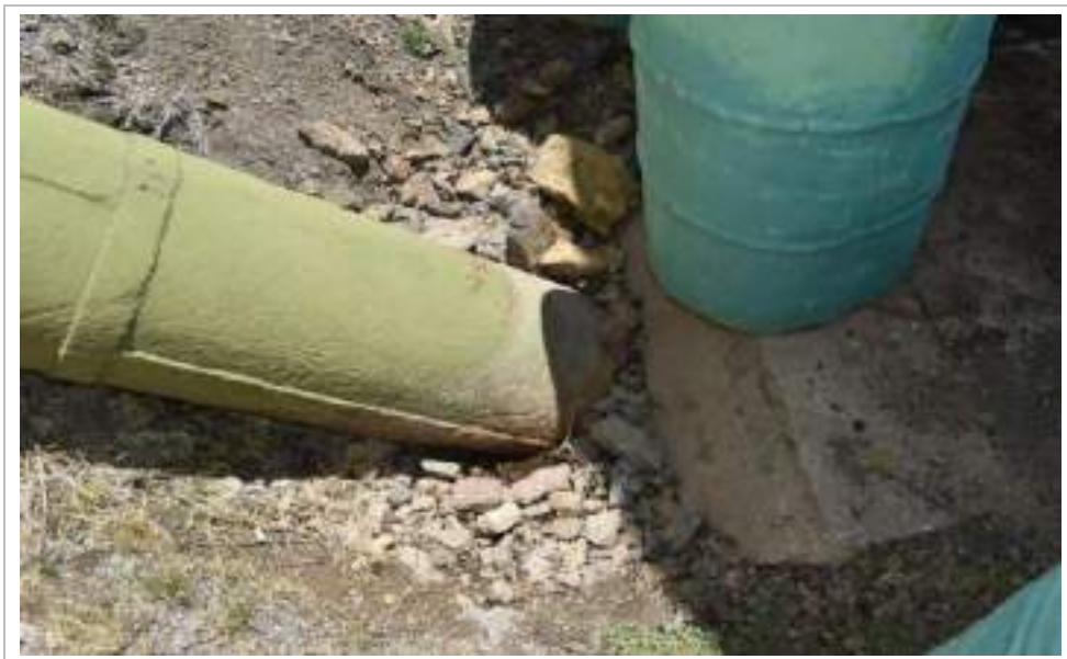
Figura 3.3 - 8 Llegada de la Tubería forzada a la Casa de máquinas
