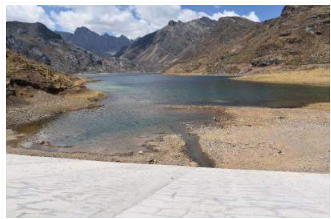
Figura 3.3 - 1 Laguna Cacray (Punto de captación)
