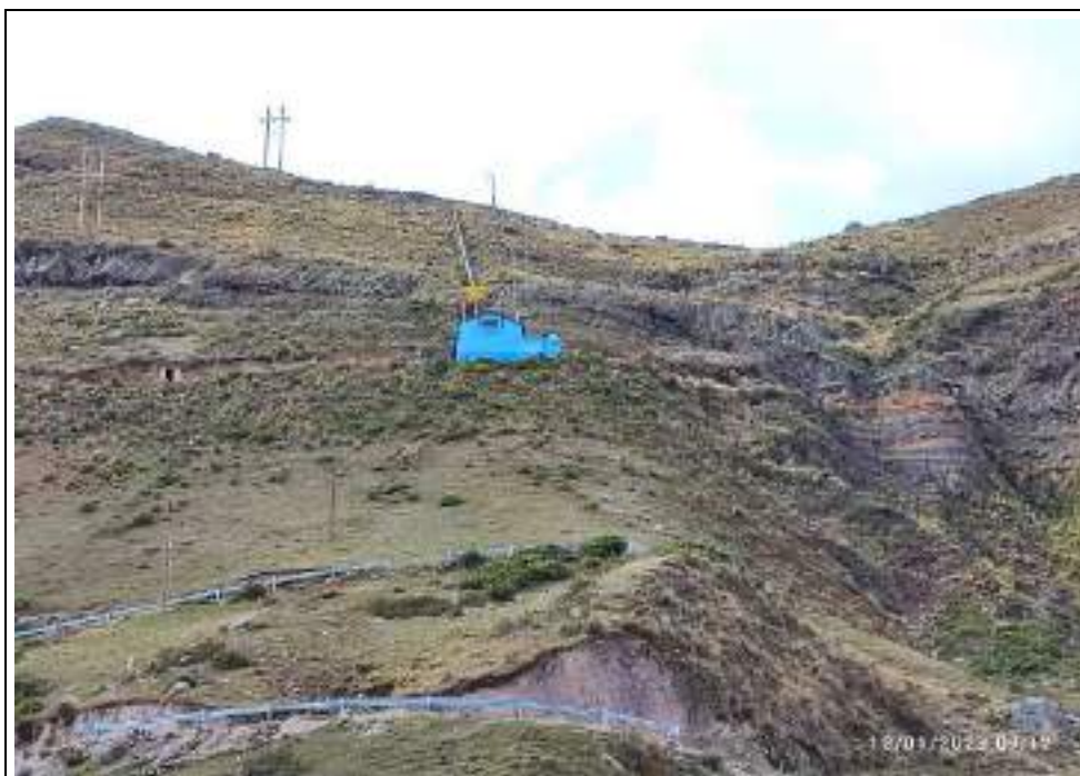
Foto N°1: Vista panorámica de la CH Cacray
