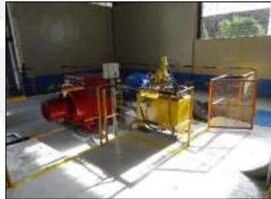
**Foto N° 35. Grupo electrógeno de reserva (izquierda), Generador y turbina fuera de uso (derecha).**
