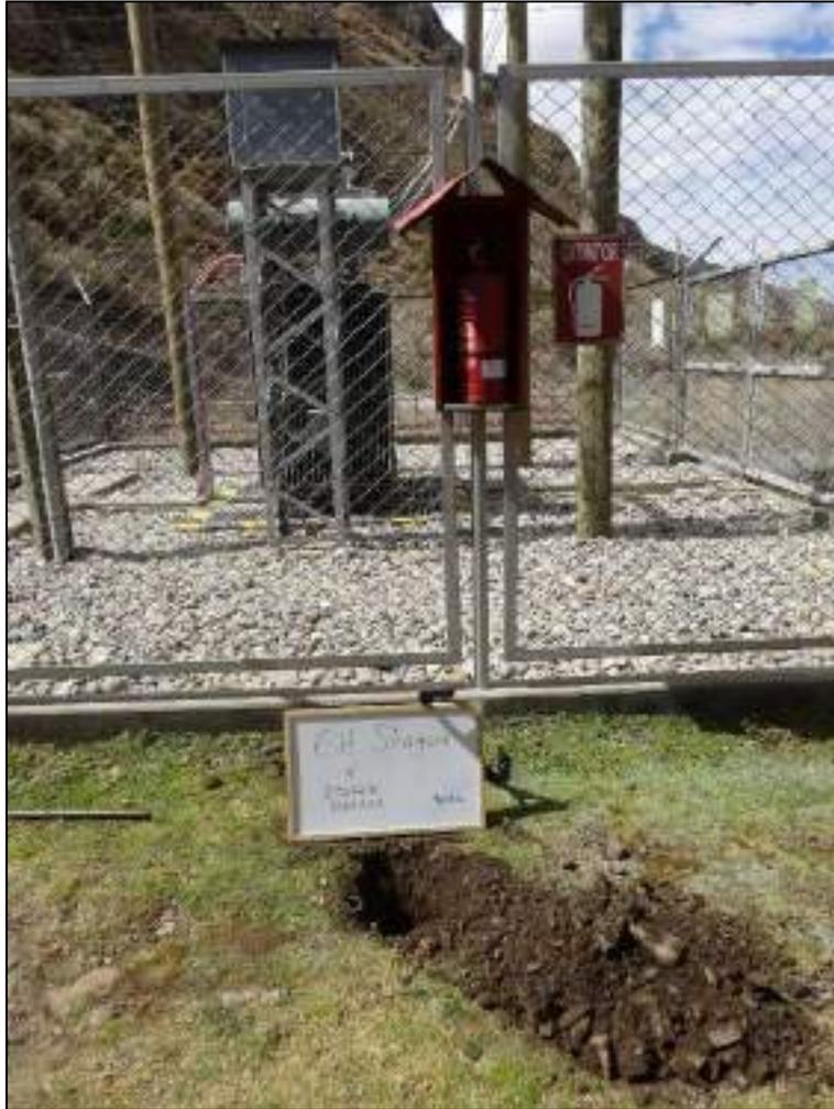
**Foto N° 9.** Ejecución de la calicata 6728-SJ, ubicado al este de la zona de transformadores.
