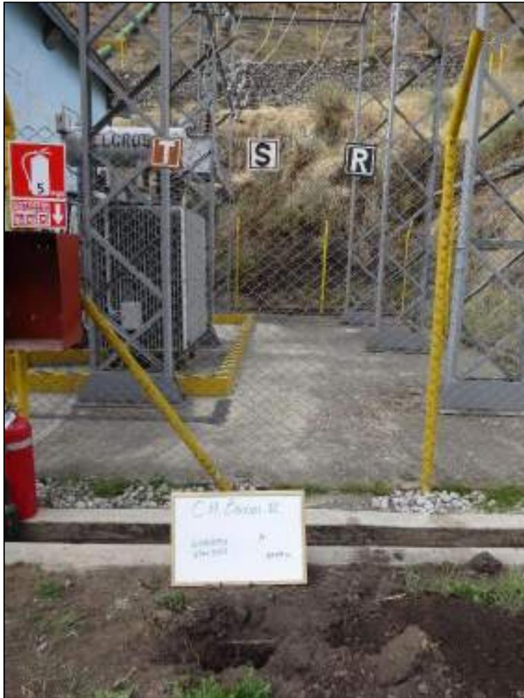
**Foto N° 3.** Ejecución de la calicata 6728-BIII, ubicado al suroeste de la zona de transformadores.
