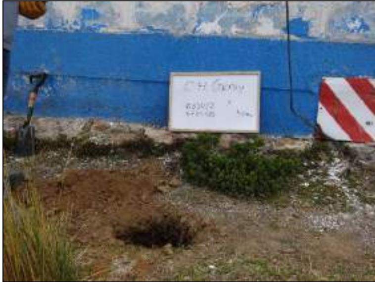
**Foto N° 7.** Ejecución de la calicata 6728-HU, ubicado al sur de la zona de transformadores.
