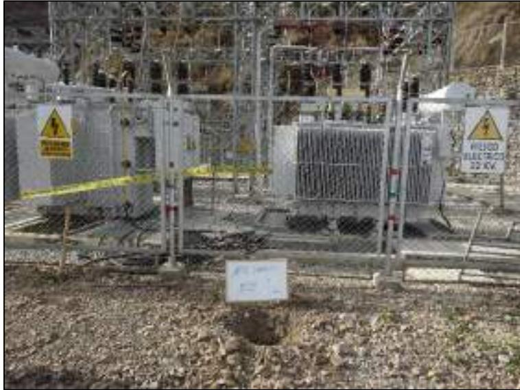
**Foto N° 5.** Ejecución de la calicata 6728-YA, ubicado al noreste de la zona de transformadores.
