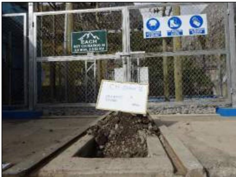
**Foto N° 4.** Ejecución de la calicata 6728-BIV, ubicado al sur de la zona de transformadores.
