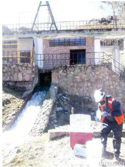
Salida de Aguas Turbinadas 0 520 785 E / 8 426 285 N / 18 L
