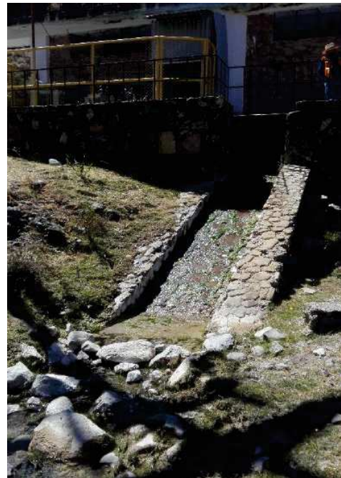
Salida de Aguas Turbinadas 0 520 785 E / 8 426 285 N / 18 L
