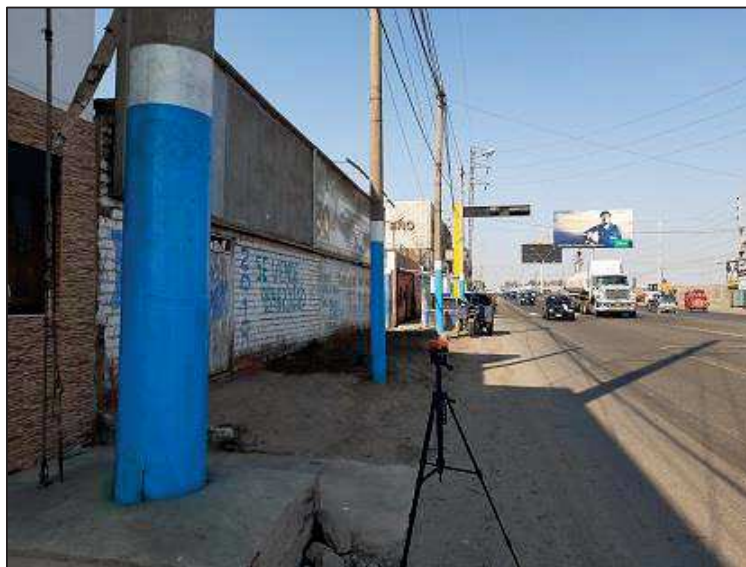
L-6605-01: Estructura N° 09 0 370 841 E / 8 8 483 937 N / 18 L
