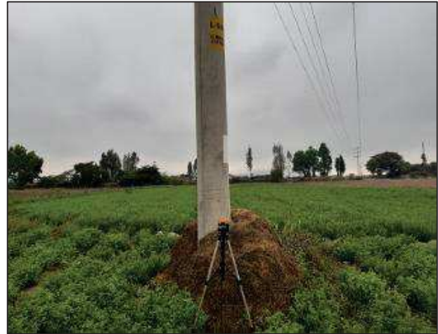
L-6605: Estructura N° 30 0 389 869 E / 8 486 129 N / 18 L
