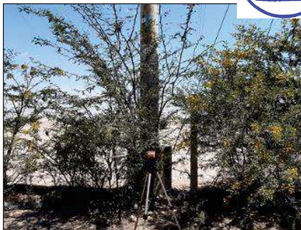
L-6625: Estructura N° 10 0 425 772 E / 8 445 543 N / 18 L
