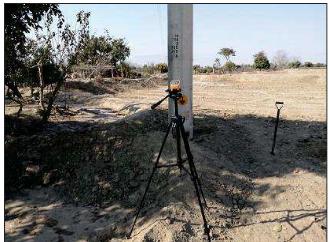
L-6624: Estructura N° 84 0 424 891 E / 8 431 110 N / 18 L
