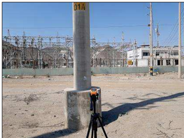
L-6625: Estructura N° 01 0 425 183 E / 8 445 975 N / 18 L
