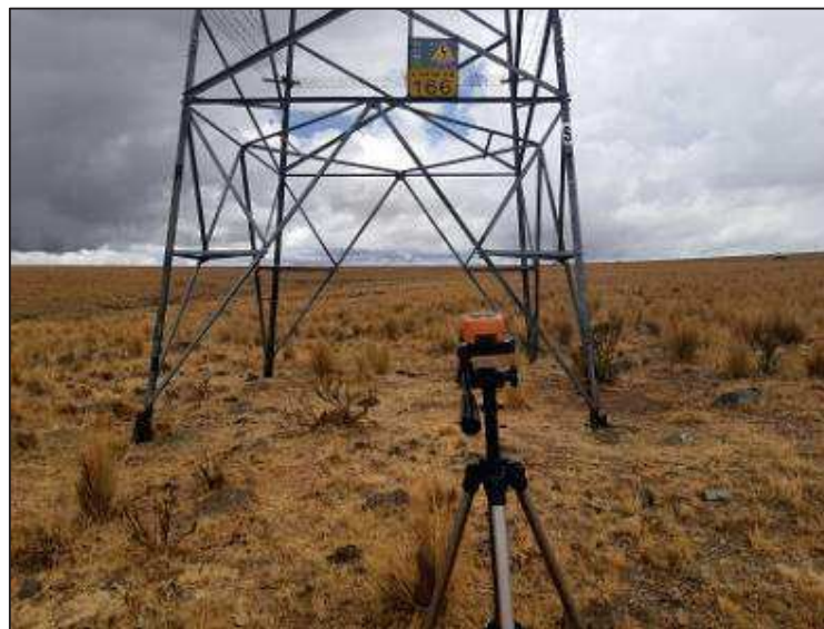
L-6630-02: Estructura N° 166 0 557 174 E / 8 378 114 N / 18 L
