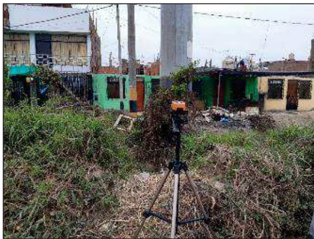
L-6604-02: Estructura N° 33 0 377 531 E / 8 512 669 N / 18 L
