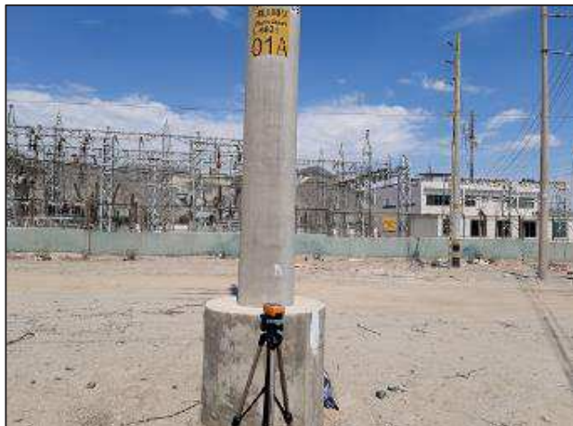
L-6625: Estructura N° 01 0 425 183 E / 8 445 975 N / 18 L
