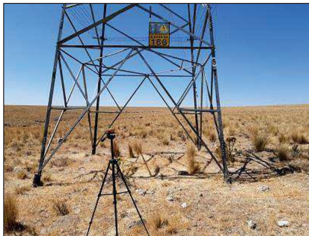
L-6630-02: Estructura N° 166 0 557 174 E / 8 378 114 N / 18 L
