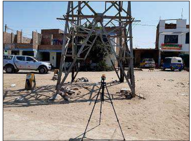
L-6623: Estructura N° 51 0 419 665 E / 8 447 203 N / 18 L
