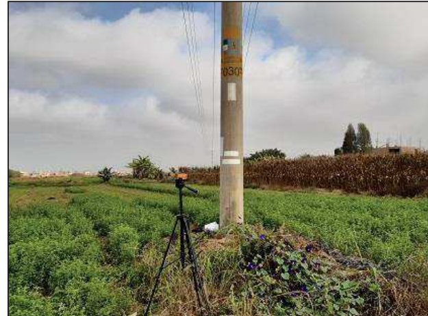
L-6605: Estructura N° 30 0 389 869 E / 8 486 129 N / 18 L
