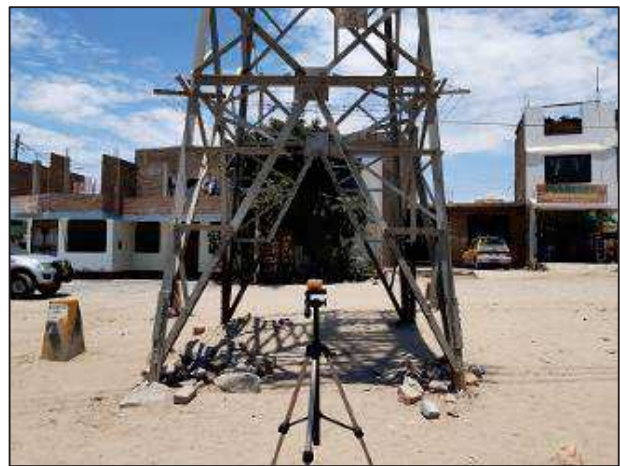
L-6623: Estructura N° 51 0 419 665 E / 8 447 203 N / 18 L
