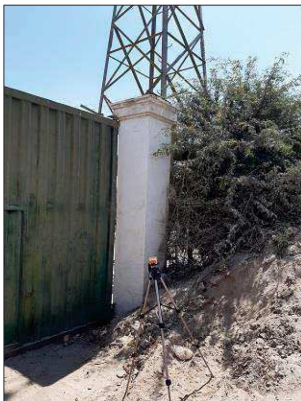
L-6625: Estructura N° 16 0 426 043 E / 8 445 320 N / 18 L
