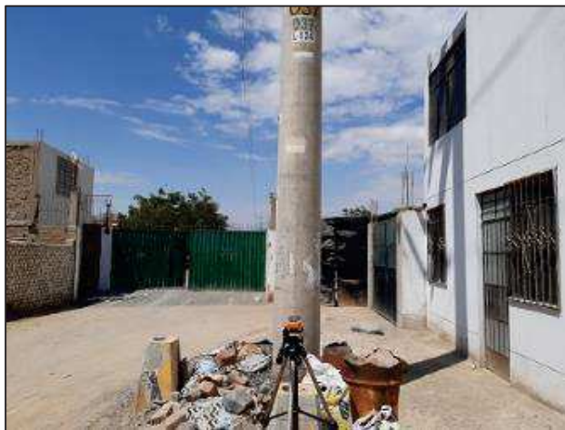
L-6624: Estructura N° 37 0 426 929 E / 8 139 526 N / 18 L
