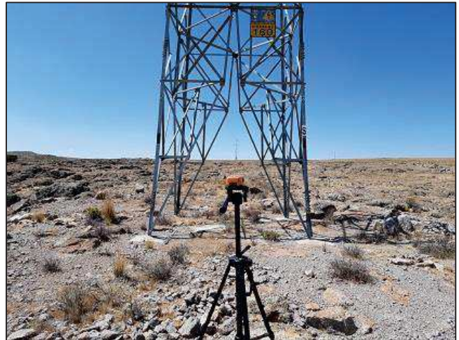
L-6630-02: Estructura N° 160 0 555 443 E / 8 377 011 N / 18 L
