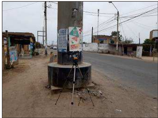
L-6604-02: Estructura N° 36 0 376 969 E / 8 512 697 N / 18 L
