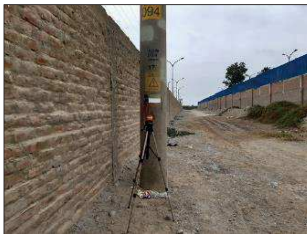
L-6604: Estructura N° 18 0 378 307 E / 8 519 035 N / 18 L
