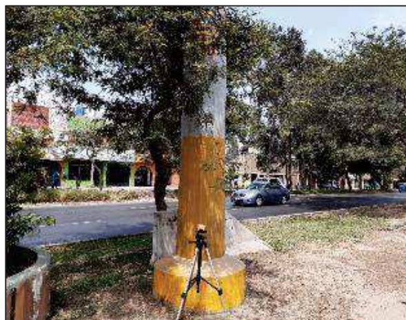
L-6615: Estructura N° 39 0 419 573 E / 8 446 141 N / 18 L
