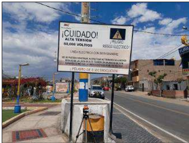
L-6630-02: Estructura N° 10 0 506 165 E / 8 359 071 N / 18 L
