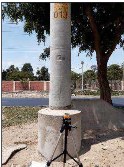
L-6615: Estructura N° 13 0 421 036 E / 8 442 790 N / 18 L
