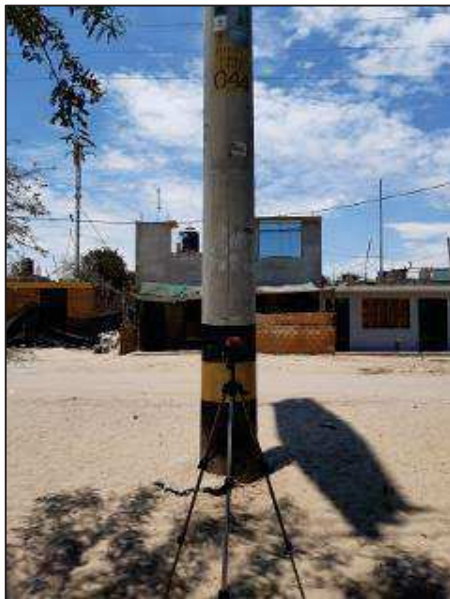
L-6623: Estructura N° 44 0 420 310 E / 8 447 902 N / 18 L
