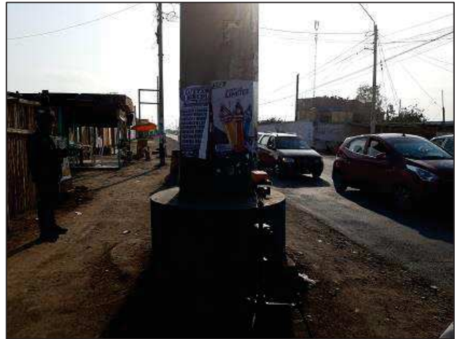
L-6604-02: Estructura N° 36 0 376 969 E / 8 512 697 N / 18 L
