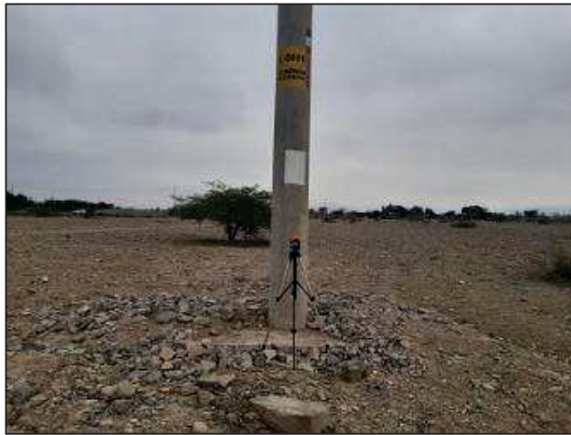
L-6605: Estructura N° 17 0 392 480 E / 8 484 799 N / 18 L
