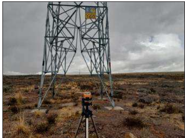
L-6630-02: Estructura N° 160 0 555 443 E / 8 377 011 N / 18 L
