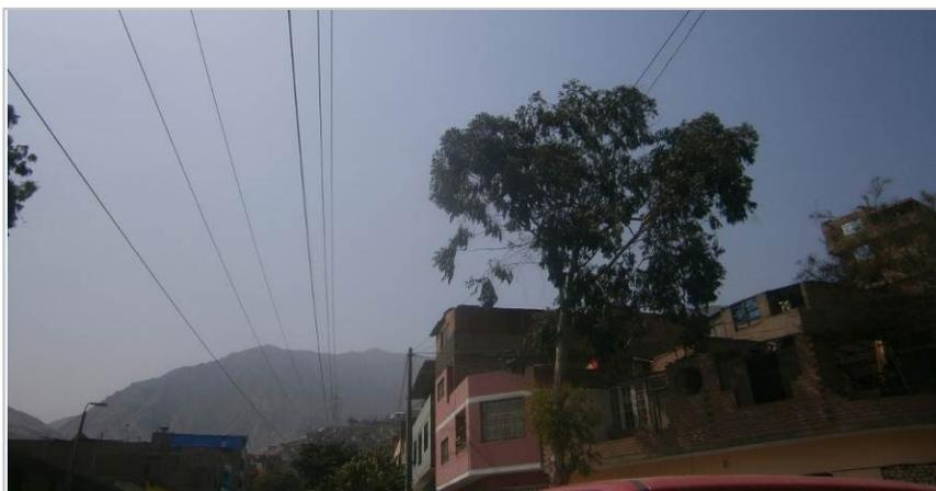
**Figura 1.3:** Acercamiento de Vegetación lateral al conductor
