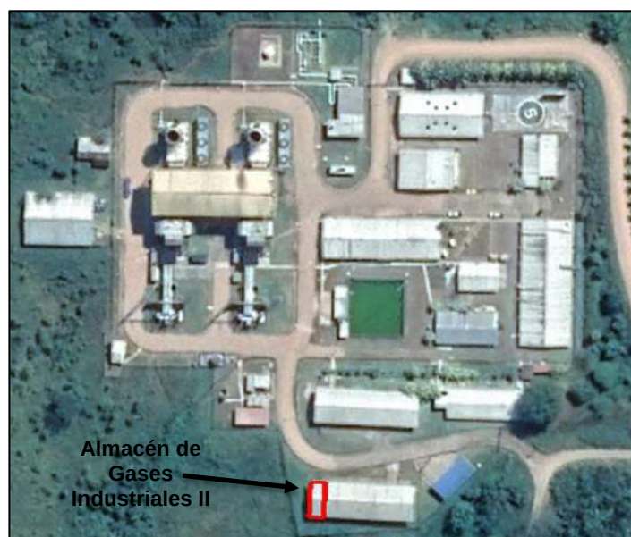
Figura 3.3.2-16. Ubicación del Almacén de Gases Industriales - II en la CT Aguaytía
