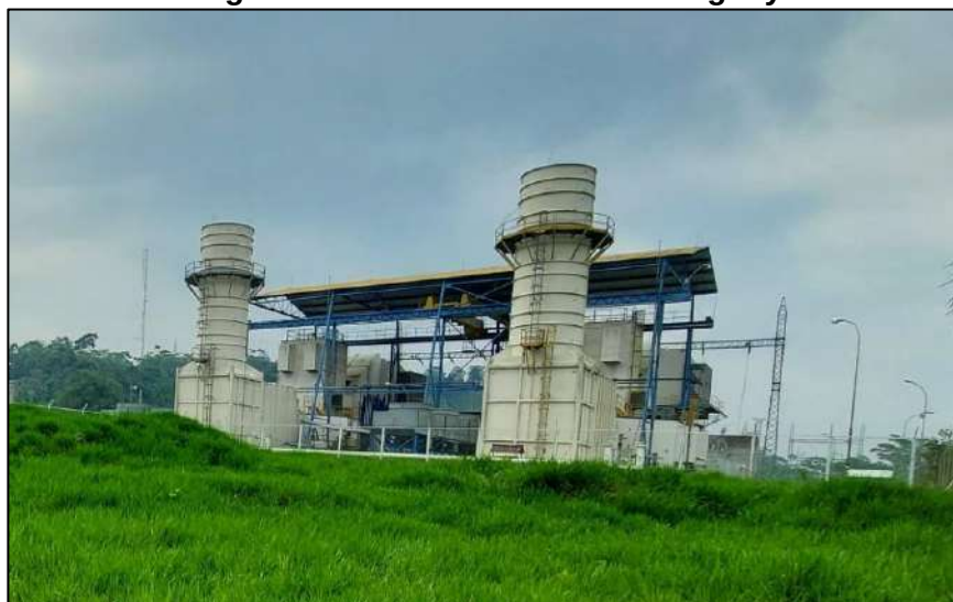
Fotografía 6.1.5-6. Central térmica Aguaytía
