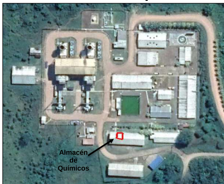
Figura 3.3.2-3. Ubicación del Almacén de Químicos en la CT Aguaytía
