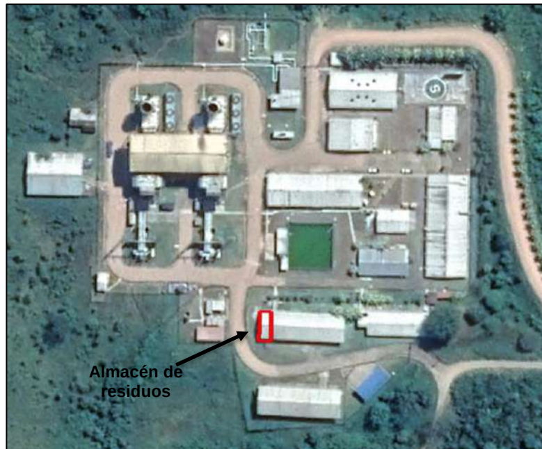
Figura 3.3.2-10. Ubicación del Almacén Residuos Sólidos en la CT
