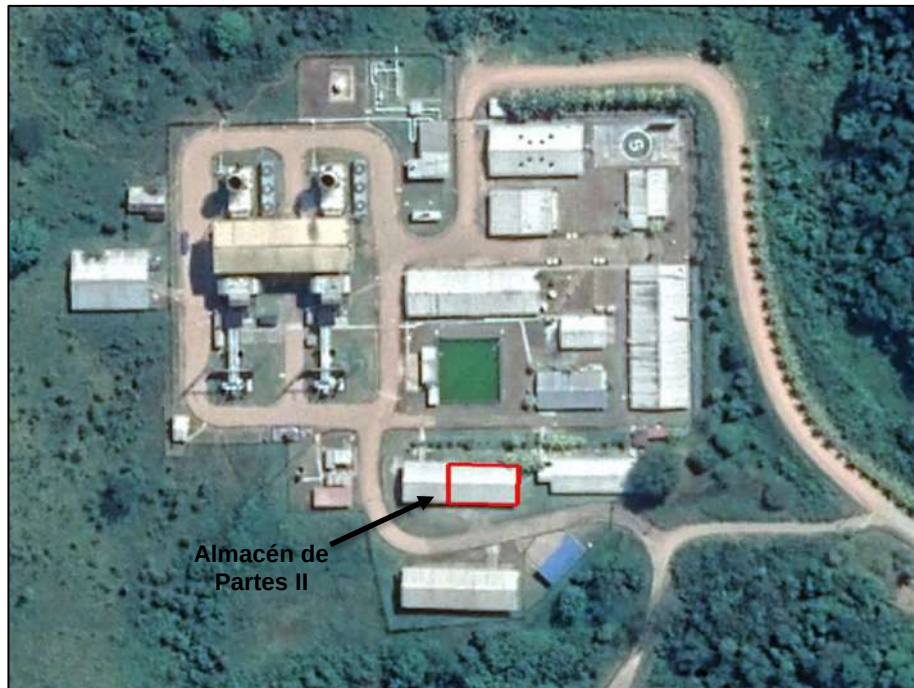
Figura 3.3.2-7. Ubicación del Almacén de Partes II en la CT Aguaytía
