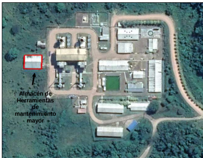
Figura 3.3.2-22. Ubicación del Almacén de herramientas de mantenimiento mayor en la CT
