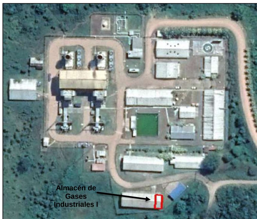
Figura 3.3.2-13. Ubicación del Almacén de Gases Industriales - I en la CT Aguaytía
