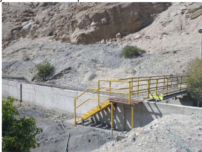
Figura N° 02: Puente peatonal sobre canal de demasías
