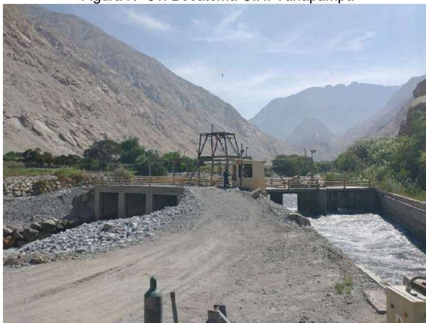
Figura N° 01: Bocatoma C.H. Yanapampa
