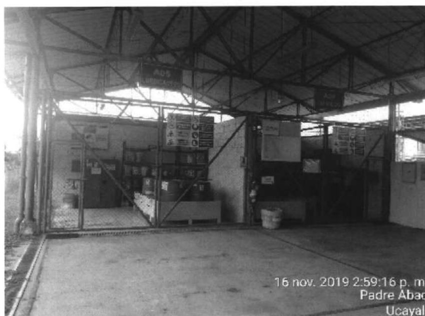
Almacén de Productos Químicos y Lubricantes Foto 4.2.2
