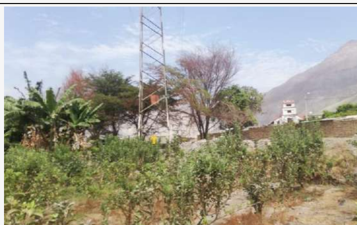
Foto N°03 Torres de alta tensión próximas al Centro Poblado Mayor de Llamachupan
