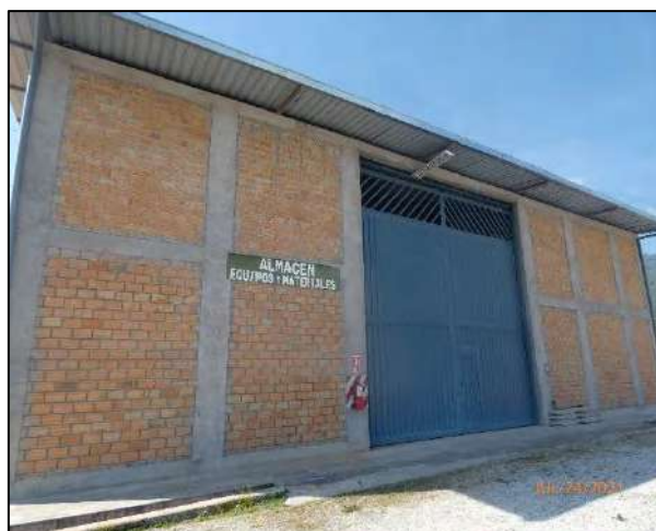
Figura 3.3.2.1- 3. Almacén de equipos y materiales
