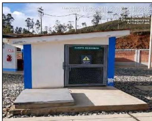
Figura 3.3.2.4- 5. Caseta de bombas
