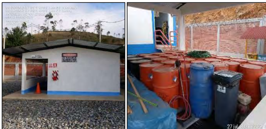
Figura 3.3.2.4- 2. Almacén de productos peligrosos
