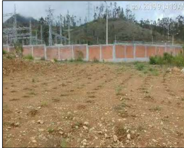
Figura 3.3.2.4- 6. Depósito de Material Excedente
