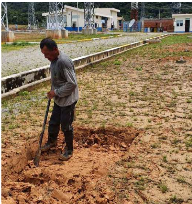
Foto 02.- Excavación de la Calicata B-2
