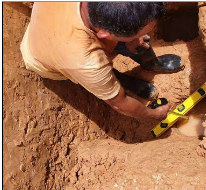
Foto 08.- Medición de niveles en la Calicata B-2
