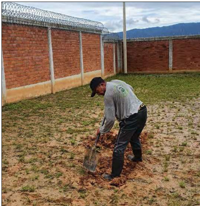
Foto 01.- Excavación de la Calicata B-1
