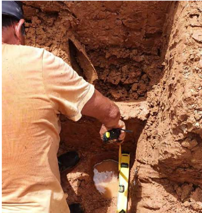
Foto 07.- Medición de niveles en la Calicata B-1
