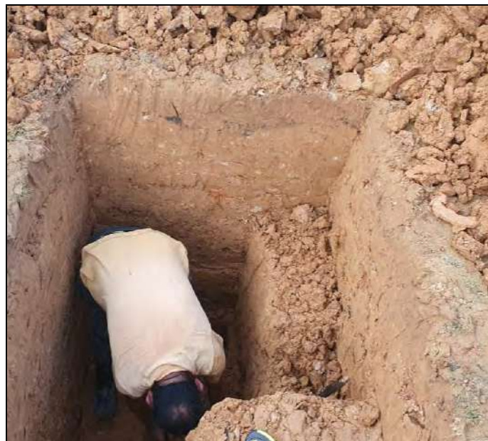
Foto 04.- Excavación de la Calicata B-4
