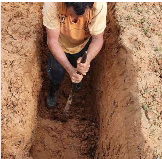
Foto 06.- Excavación de la Calicata B-6
