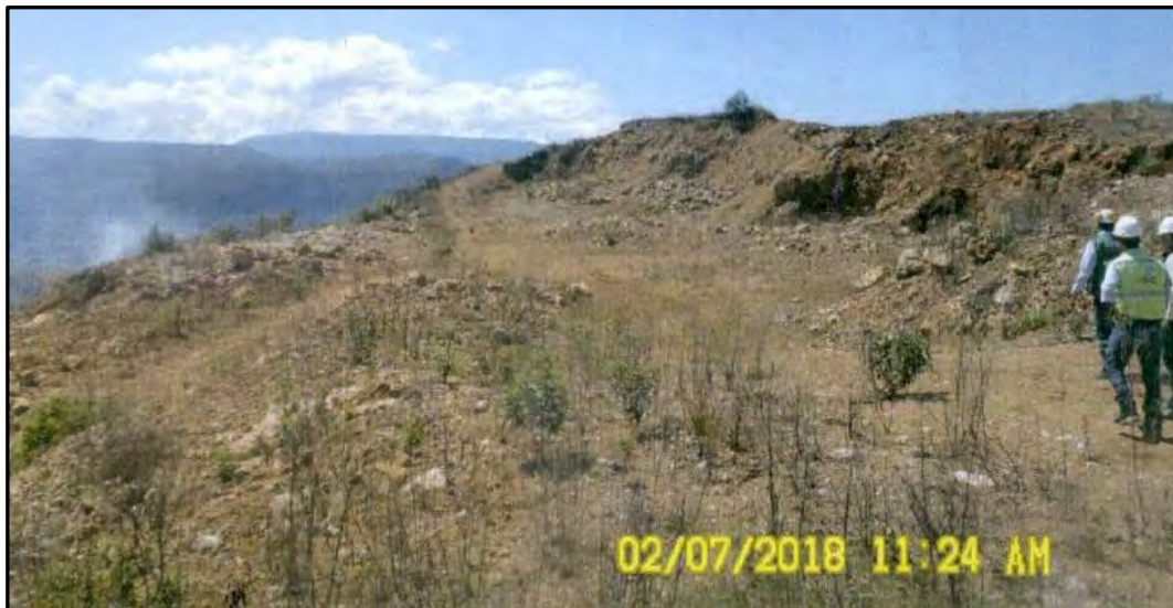
Imagen 3. Fotografía H01-4 del Informe de Supervisión. Vista de la zona de corte de talud, la cual fue utilizada como cantera de material de relleno utilizada en la construcción de la SE Cáclic.
