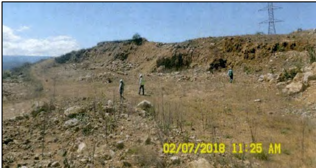
Imagen 4. Fotografía H01-5 del Informe de Supervisión. Vista de la zona de corte de talud, este corte de talud tiene una altura aproximada de 6 metros y un área aproximada de 730 m 2 .
