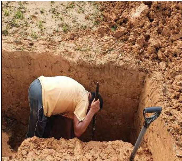
Foto 03.- Excavación de la Calicata B-3
