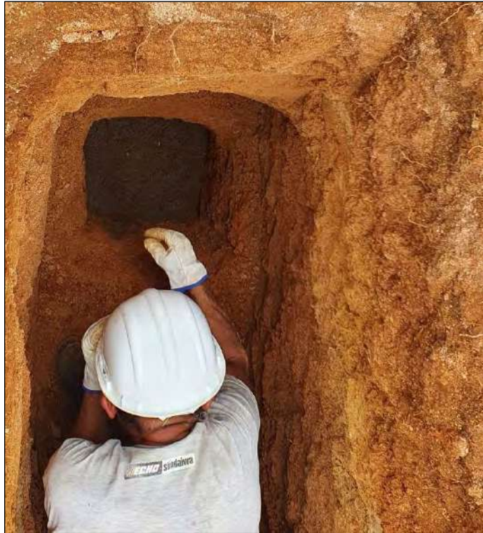
Foto 05.- Preparación del agujero en la Calicata C-5
