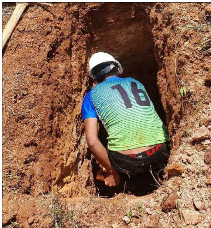
Foto 04.- Excavación de la Calicata C-4
