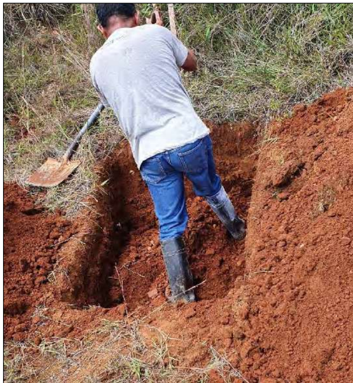
Foto 03.- Excavación de la Calicata C-3
