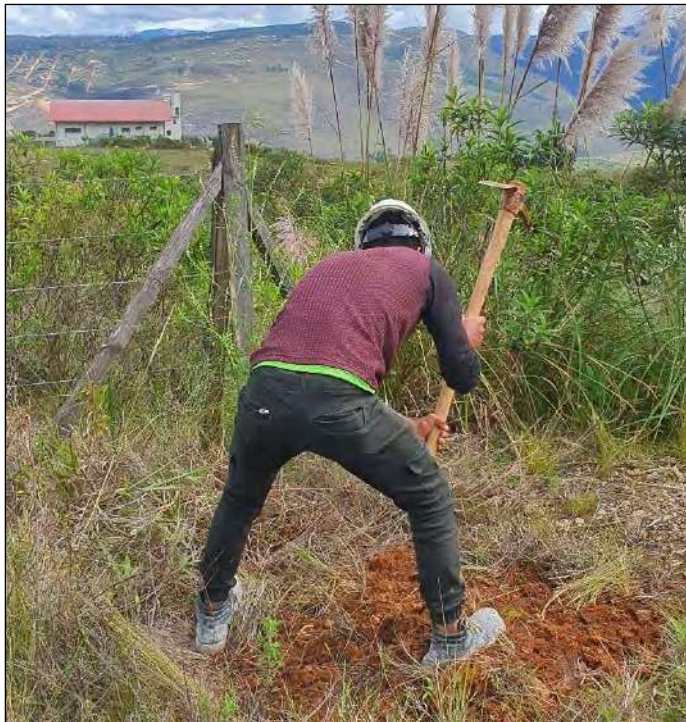
Foto 01.- Excavación de la Calicata C-1
