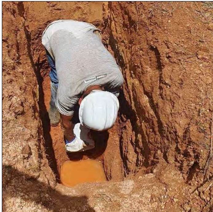
Foto 07.- Llenado de agua en Calicata C-5
