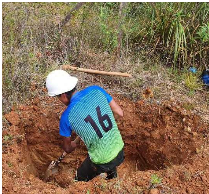
Foto 02.- Excavación de la Calicata C-2
