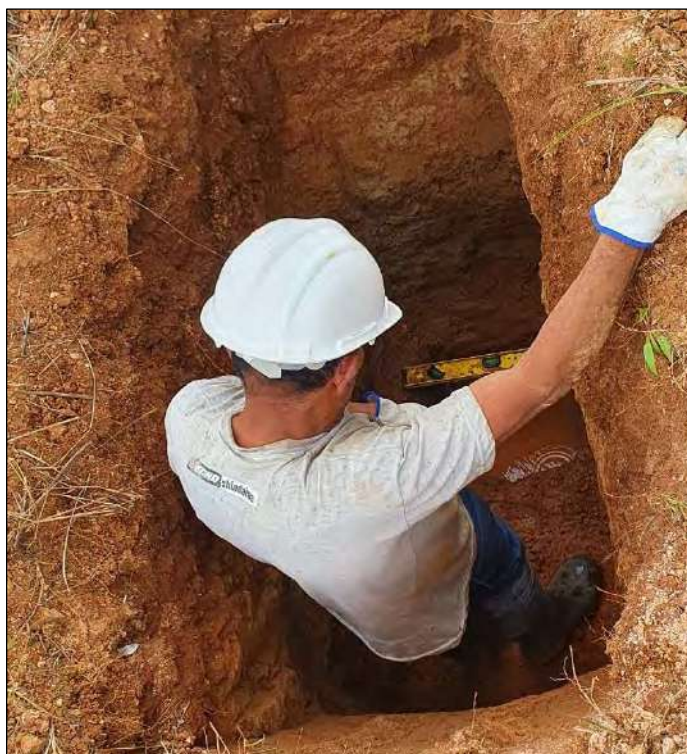
Foto 08.- Medición de niveles en la Calicata C-2
