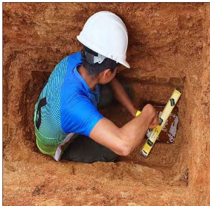
Foto 06.- Medición de niveles en la Calicata C-6
