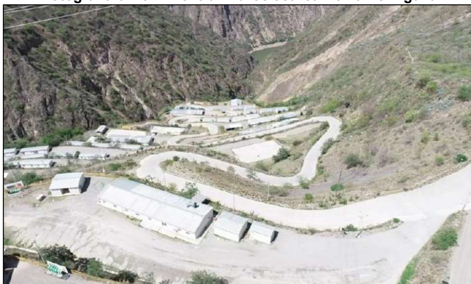
Fotografía 6.1.5-7. Central hidroeléctrica Cerro Del Águila
