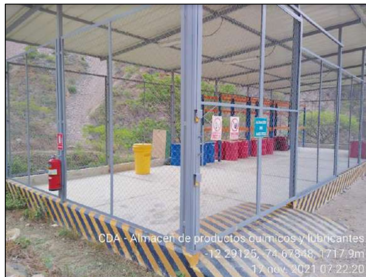
Figura 3.3.2-13. Malla ciclónica y rampa de accesibilidad
