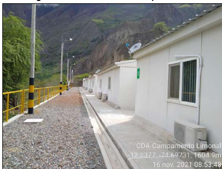
Figura 3.3.2-3. Estructura Campamento Limonal
