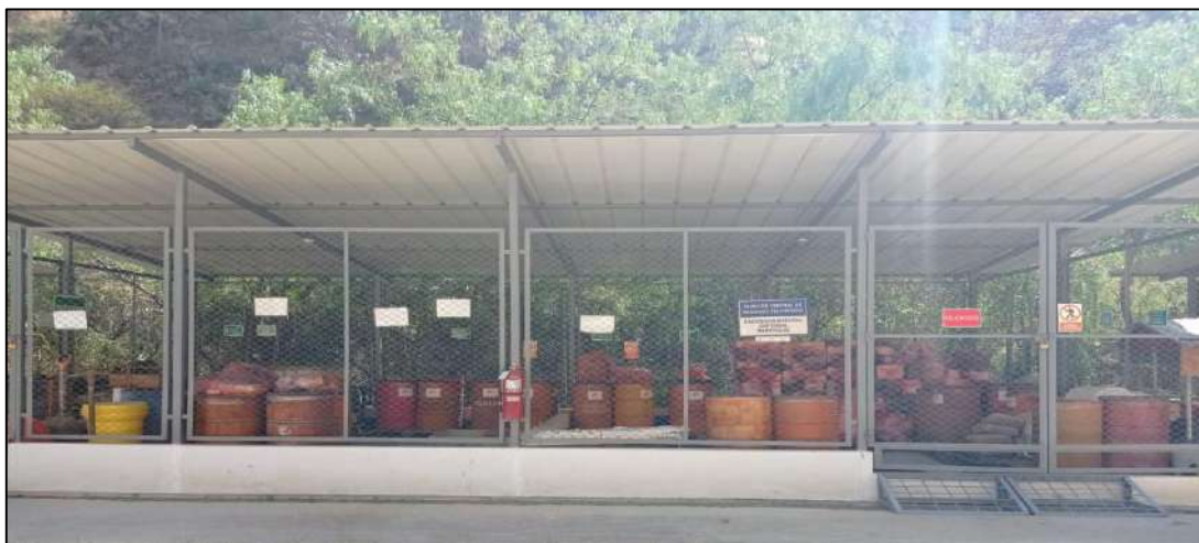
Figura 3.3.2-25. Área de Almacenamiento de Residuos Peligrosos
