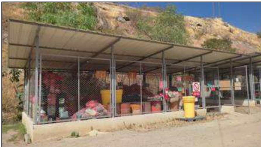
Figura 3.3.2-18. Área de Almacenamiento de Residuos Peligrosos
