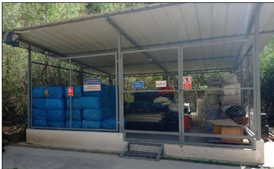
Figura 3.3.2-22. Área de acopio de Residuos Comerciables y Comunes
