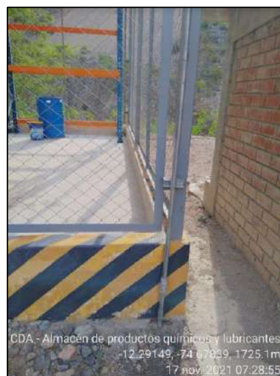
Figura 3.3.2-14. Muro de albañilería del almacén de Productos Químicos y Lubricantes
