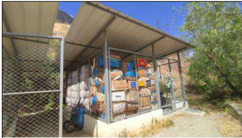
Figura 3.3.2-15. Área de acopio de Residuos Comerciables y Comunes
