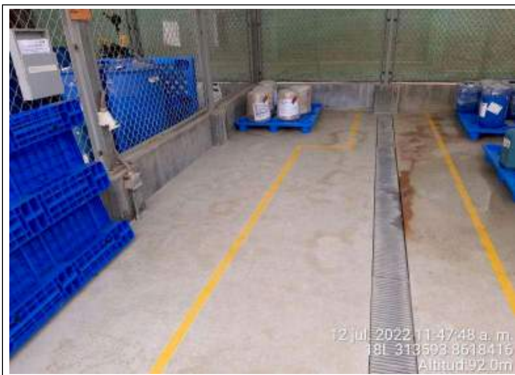
Fotografía N° 35: Interior del Almacén de Químicos No Fiscalizados 2 de la C.T. Santo Domingo de Los Olleros. Se observa drenaje perimetral e intermedio.
