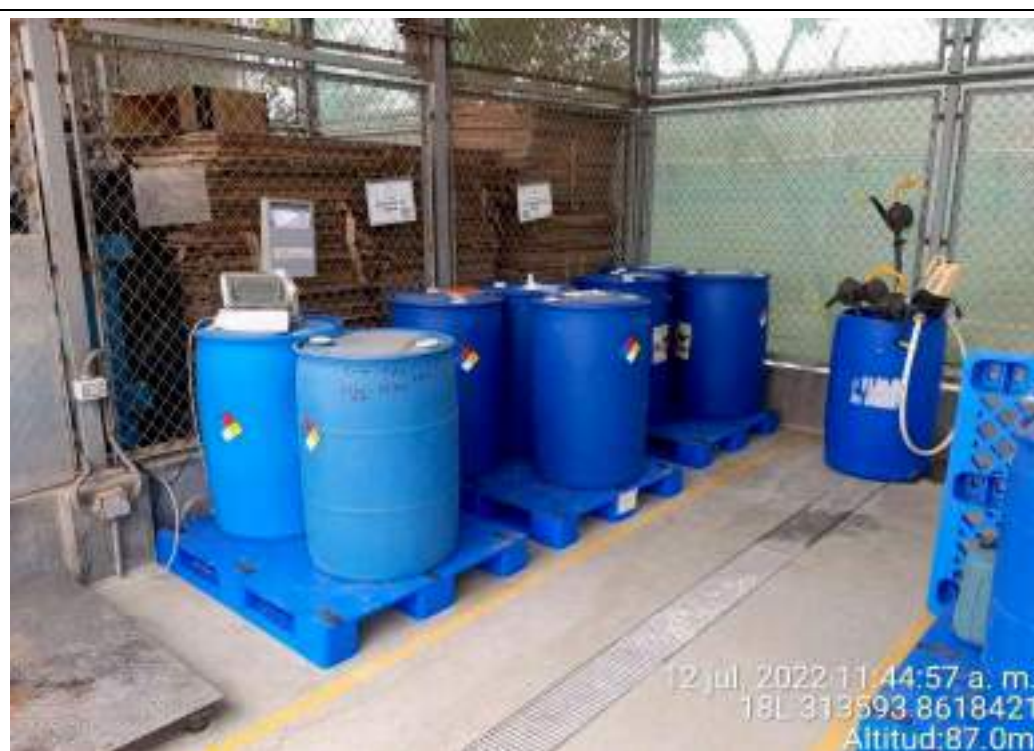
Fotografía N° 27: Interior del Almacén de Químicos No Fiscalizados 1 de la C.T. Santo Domingo de Los Olleros. Se observa drenaje intermedio.
