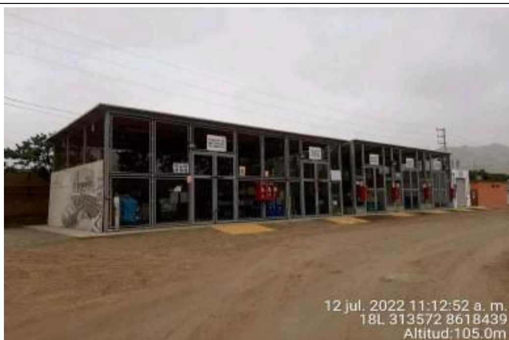
Fotografía N° 13: Almacenes de Materiales Peligrosos de la C.T. Santo Domingo de Los Olleros.
