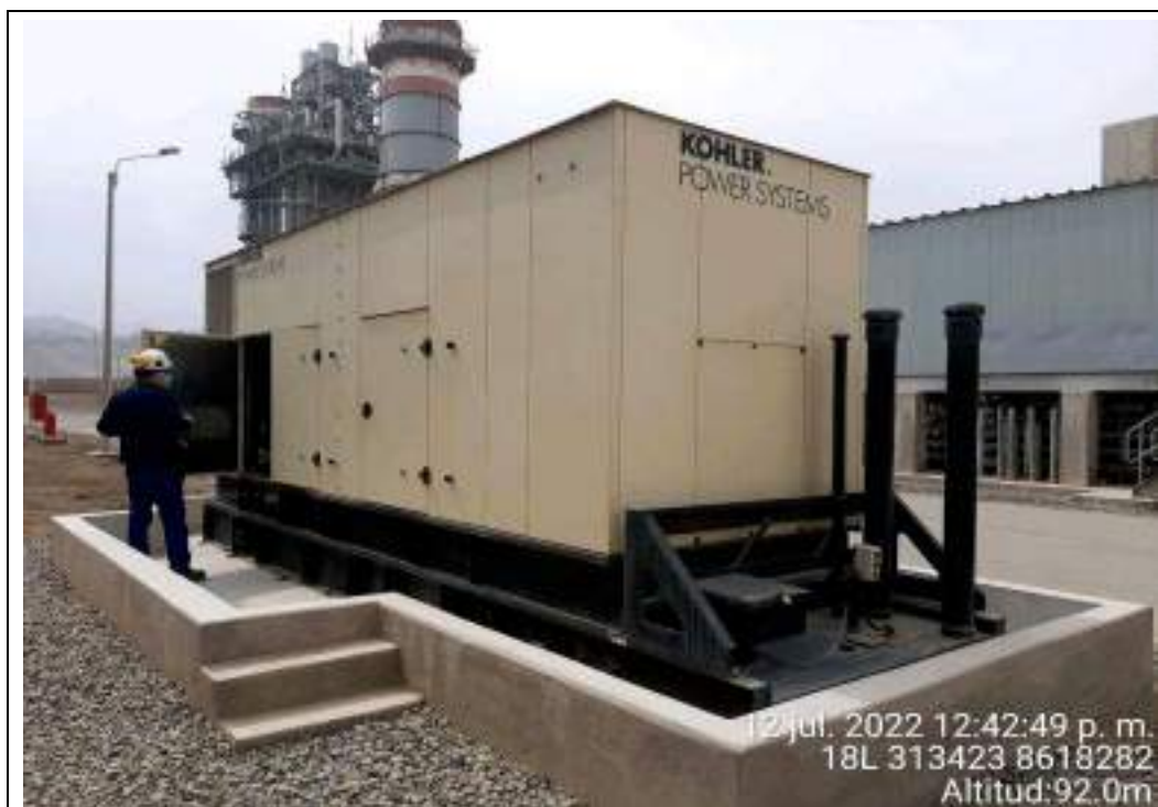
Fotografía N° 59: Grupo electrógeno de la C.T. Santo Domingo de Los Olleros. Se observa el grupo electrógeno encapsulado al interior de un sistema de contención de concreto impermeabilizado con pintura epóxica y berma de contención.
