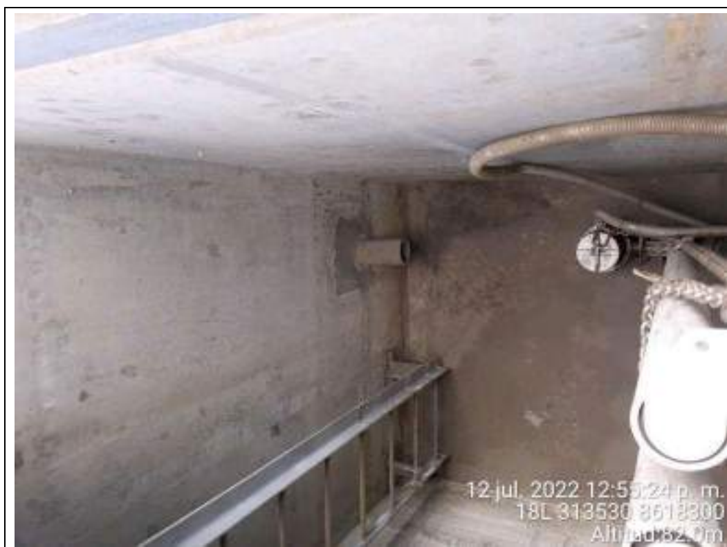
Fotografía N° 70: Pozza colectora y de bombeo de derrames hacia el sistema de separación de grasas.
