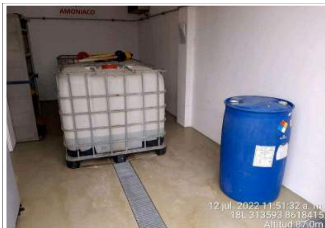
Fotografía N° 45: Interior del Almacén de Químicos Fiscalizados de la C.T. Santo Domingo de Los Olleros. Se observa drenaje intermedio.
