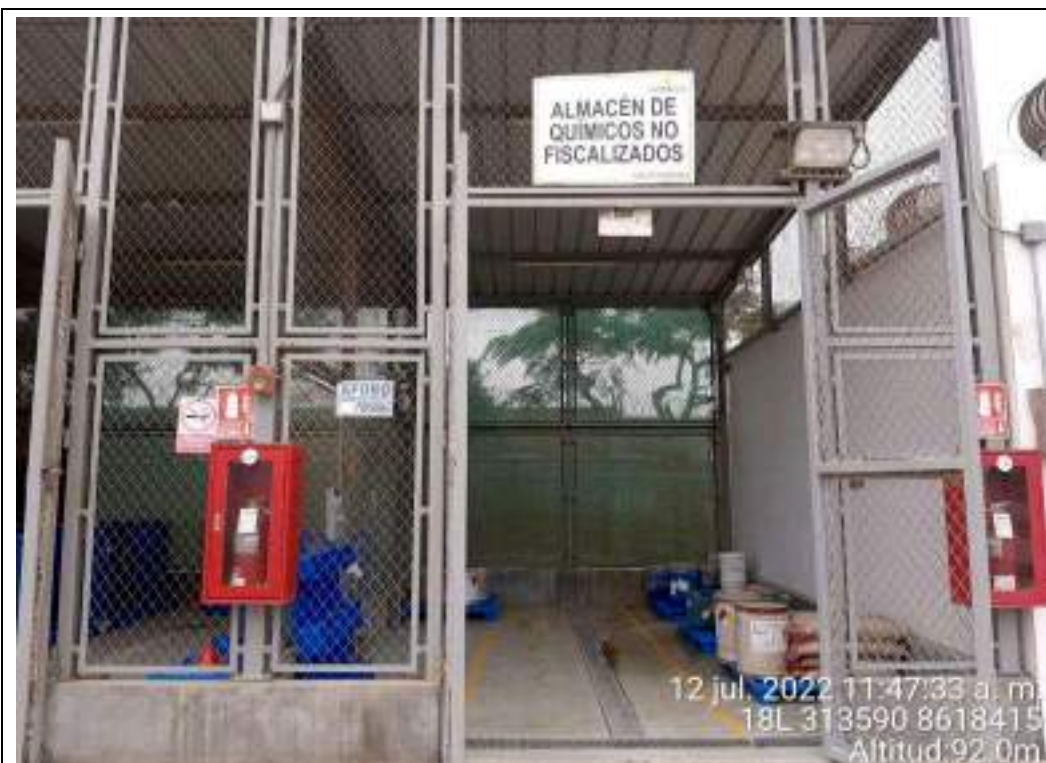
Fotografía N° 34: Almacén de Químicos No Fiscalizados 2. Se observan los extintores en la zona exterior.
