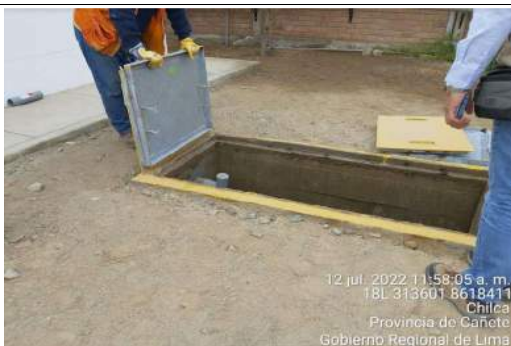
Fotografía N° 54: Poza colectora de los almacenes de materiales peligrosos de la C.T. Santo domingo de Los Olleros.
