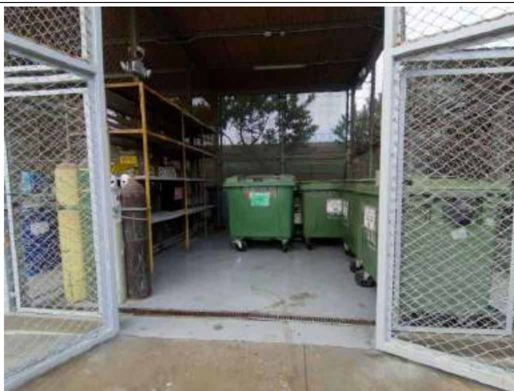
Fotografía N° 3: Almacén de Residuos Peligrosos de la C.T. Santo Domingo de Los Olleros. Se observa sistema de drenaje en la zona de acceso.
