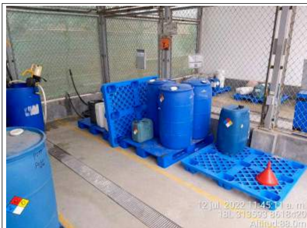
Fotografía N° 28: Interior del Almacén de Químicos No Fiscalizados 1 de la C.T. Santo Domingo de Los Olleros. Se observa drenaje intermedio.
