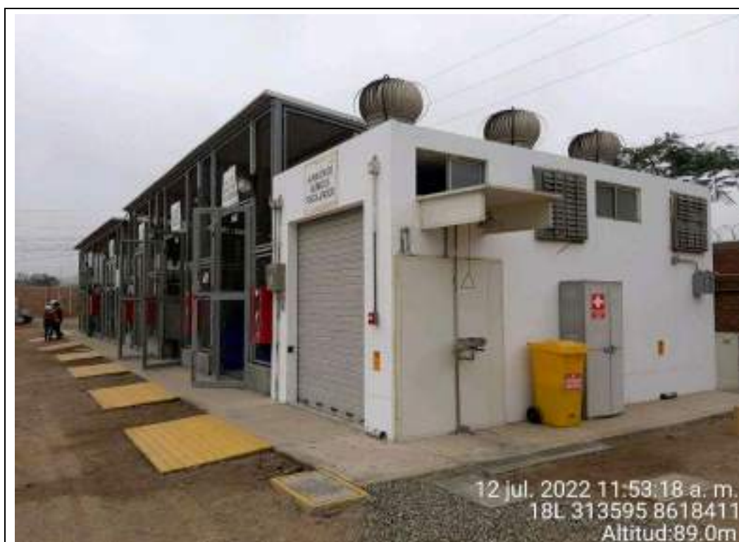
Fotografía N° 52: Exterior del Almacén de Químicos Fiscalizados de la C.T. Santo Domingo de Los Olleros.
