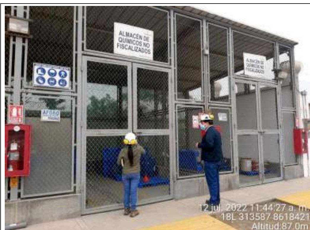
Fotografía N° 25: Almacén 1 y 2 de Químicos No Fiscalizados. Se observan los extintores en la zona exterior.
