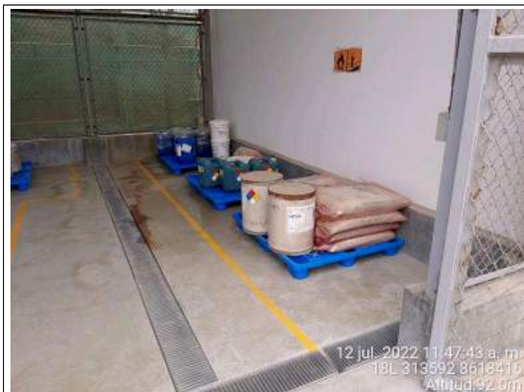
Fotografía N° 35: Interior del Almacén de Químicos No Fiscalizados 2 de la C.T. Santo Domingo de Los Olleros. Se observa drenaje perimetral e intermedio.
