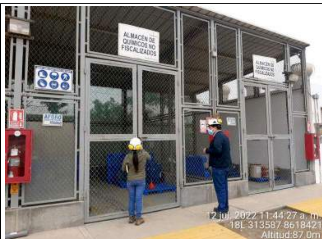
Fotografía N° 33: Almacén 1 y 2 de Químicos No Fiscalizados. Se observan los extintores en la zona exterior.
