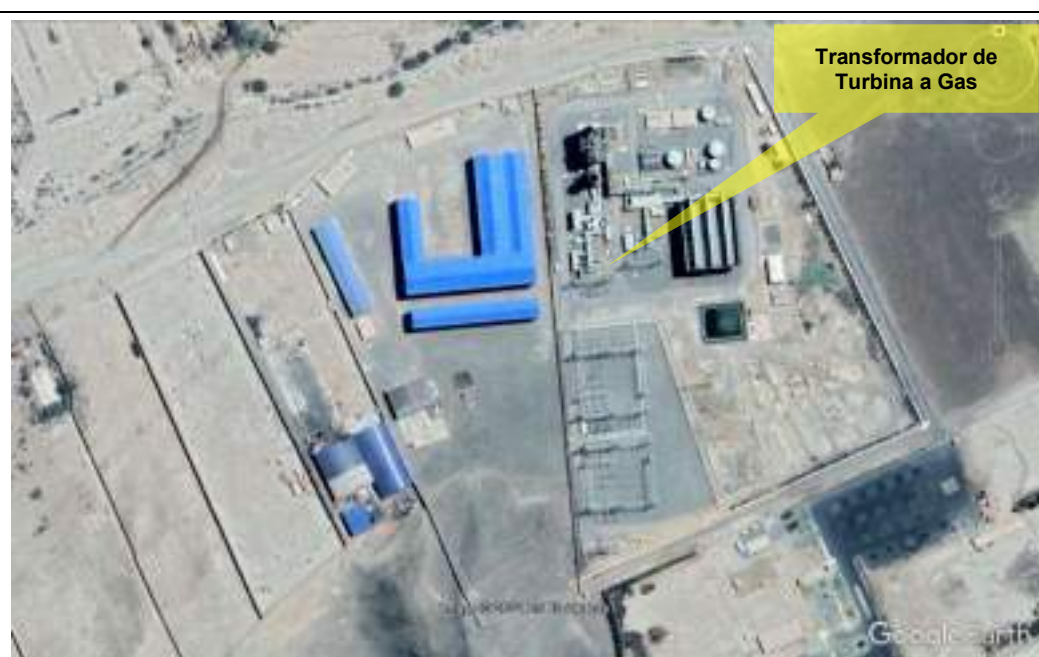
Imagen N° 8: Imagen satelital de la ubicación de la ubicación del Transformador de a Gas.
