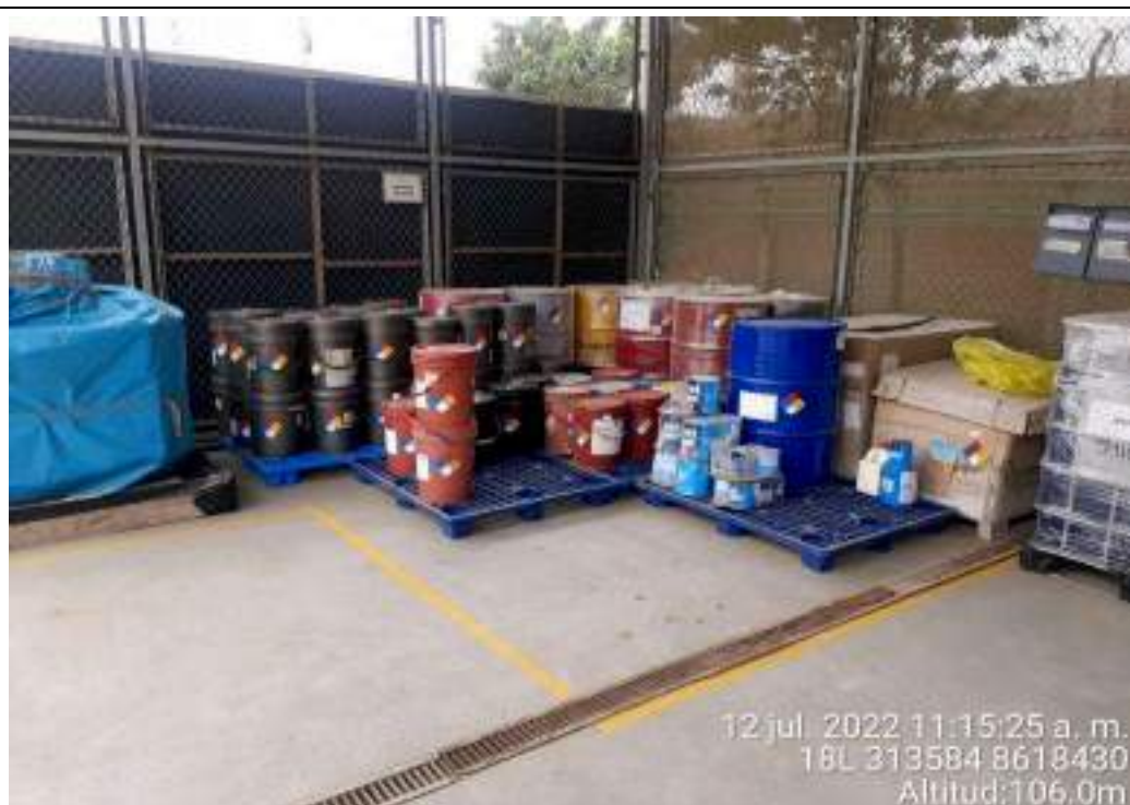
Fotografía N° 16: Interior del Almacén de Materiales Peligrosos de la C.T. Santo Domingo de Los Olleros. Se observa drenaje perimetral.
