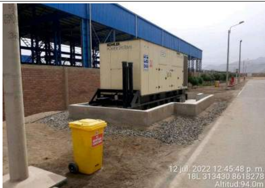
Fotografía N° 59: Grupo electrógeno de la C.T. Santo Domingo de Los Olleros. Se observa el grupo electrógeno encapsulado al interior de un sistema de contención de concreto impermeabilizado con pintura epóxica y berma de contención.
