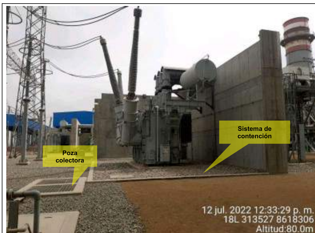
Fotografía N° 67: Transformador de la Turbina a Vapor sobre el sistema de contención de concreto. Se señala la poza colectora de concreto.
