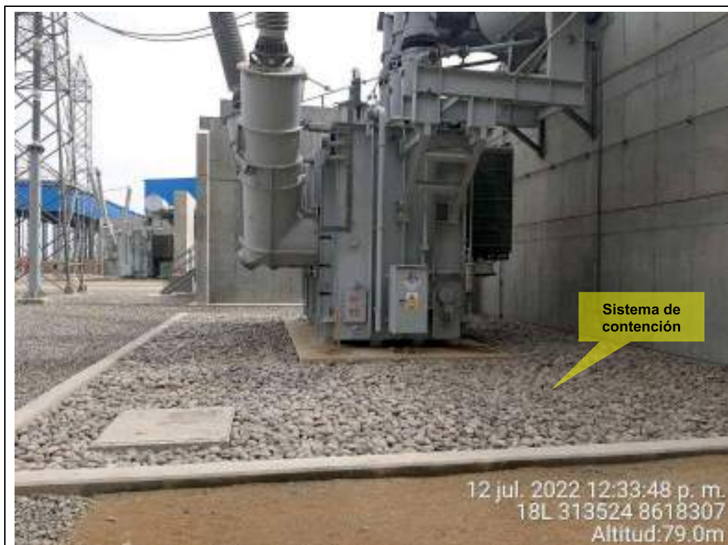
Fotografía N° 67: Transformador de la Turbina a Vapor sobre el sistema de contención de concreto. Se señala la poza colectora de concreto.
