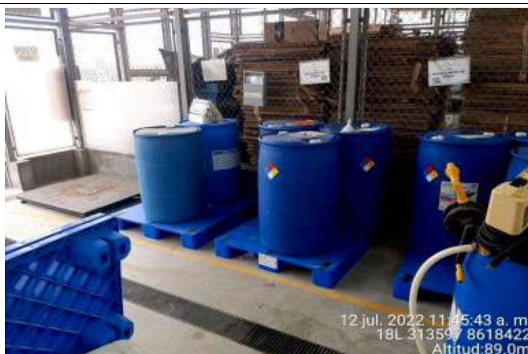
Fotografía N° 29: Interior del Almacén de Químicos No Fiscalizados 1 de la C.T. Santo Domingo de Los Olleros. Se observa drenaje intermedio.
