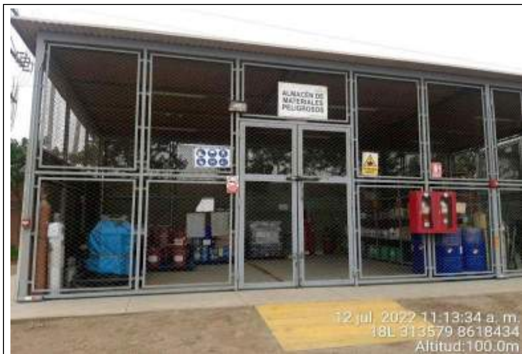
Fotografía N° 14: Almacenes de Materiales Peligrosos de la C.T. Santo Domingo de Los Olleros.
