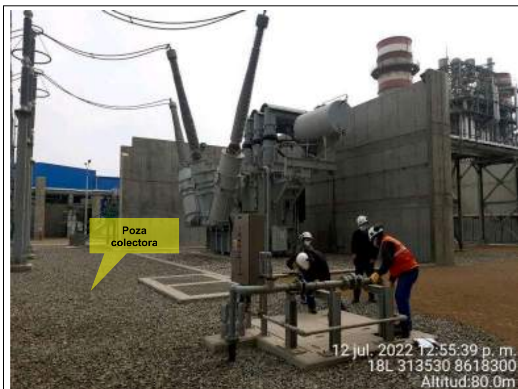
Fotografía N° 70: Pozza colectora y de bombeo de derrames hacia el sistema de separación de grasas.
