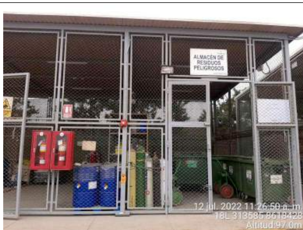
Fotografía N° 2: Almacén de Residuos Peligrosos de la C.T. Santo Domingo de Los Olleros.
