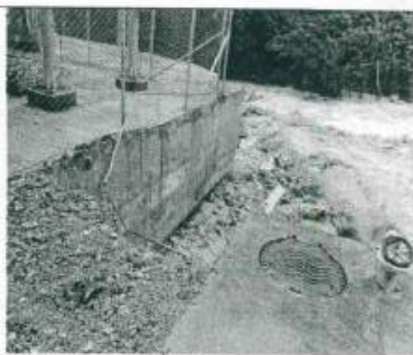
Figuras 10 y 11. Desmoronamiento del terreno Base TE03.
