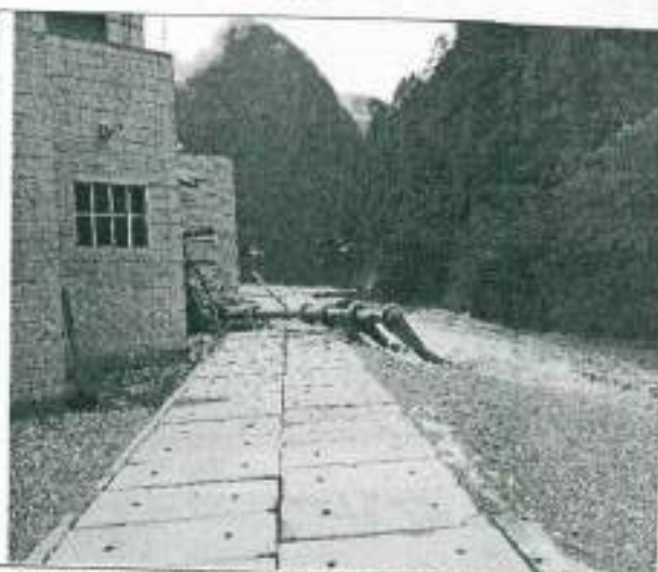
Figuras 12 y 13. Colapsa subestación Mono-poste y transformador TD.CF (13.8/0.38 kV) Y Subestación Biposte y transformador de 22.9/0.38 kV.
