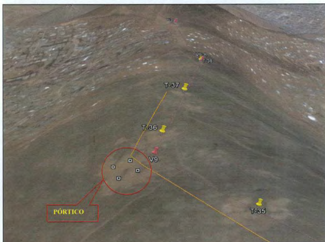
Foto 4. Vista referencial tomada del google earth (fecha mayo 2017) del pórtico de la L.T 220 kV S.E. Mirador - S.E. Malvinas (puntos blancos) el cual está instalado fuera de la franja de servidumbre (línea naranja).
