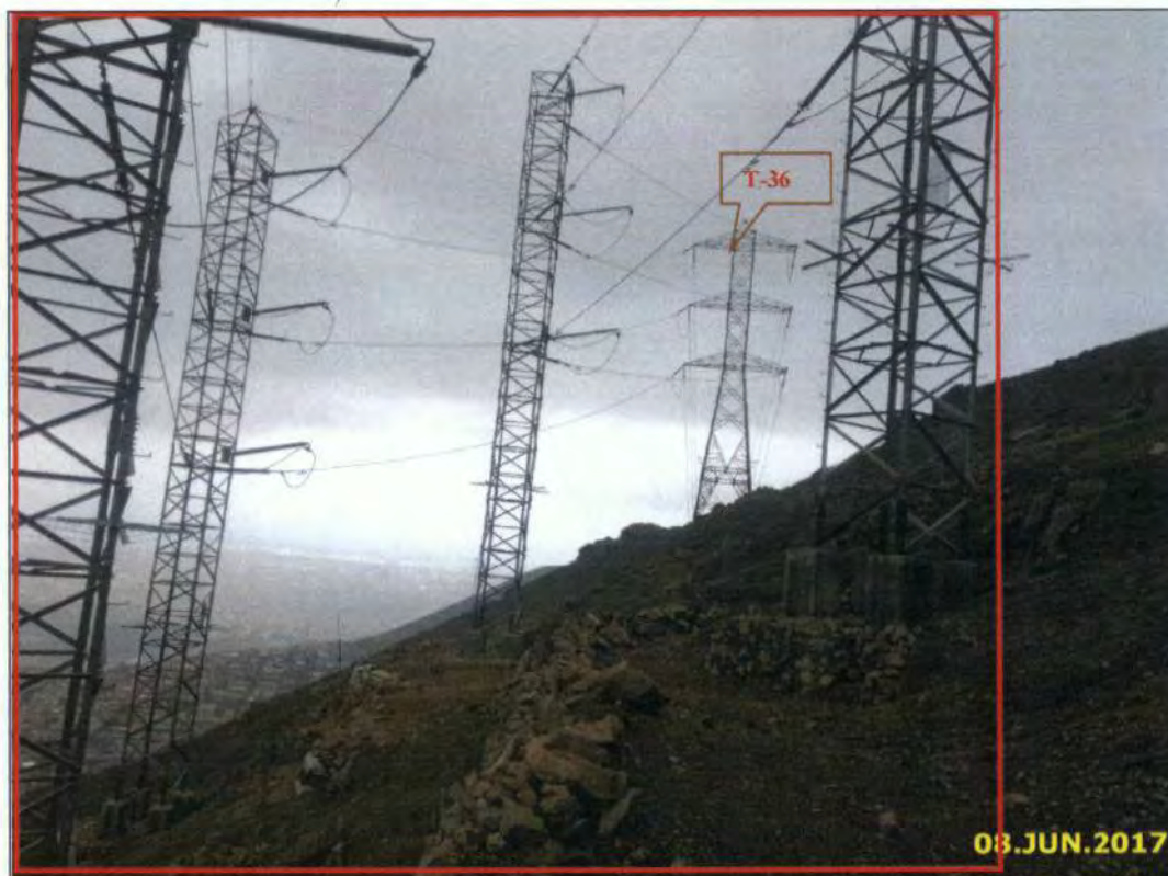
Foto 3. Vista de la estructura tipo pórtico de la L.T 220 kV S.E. Mirador - S.E. Malvinas, se observa las áreas disturbadas (tipo terrazas) para la instalación de las torres.
