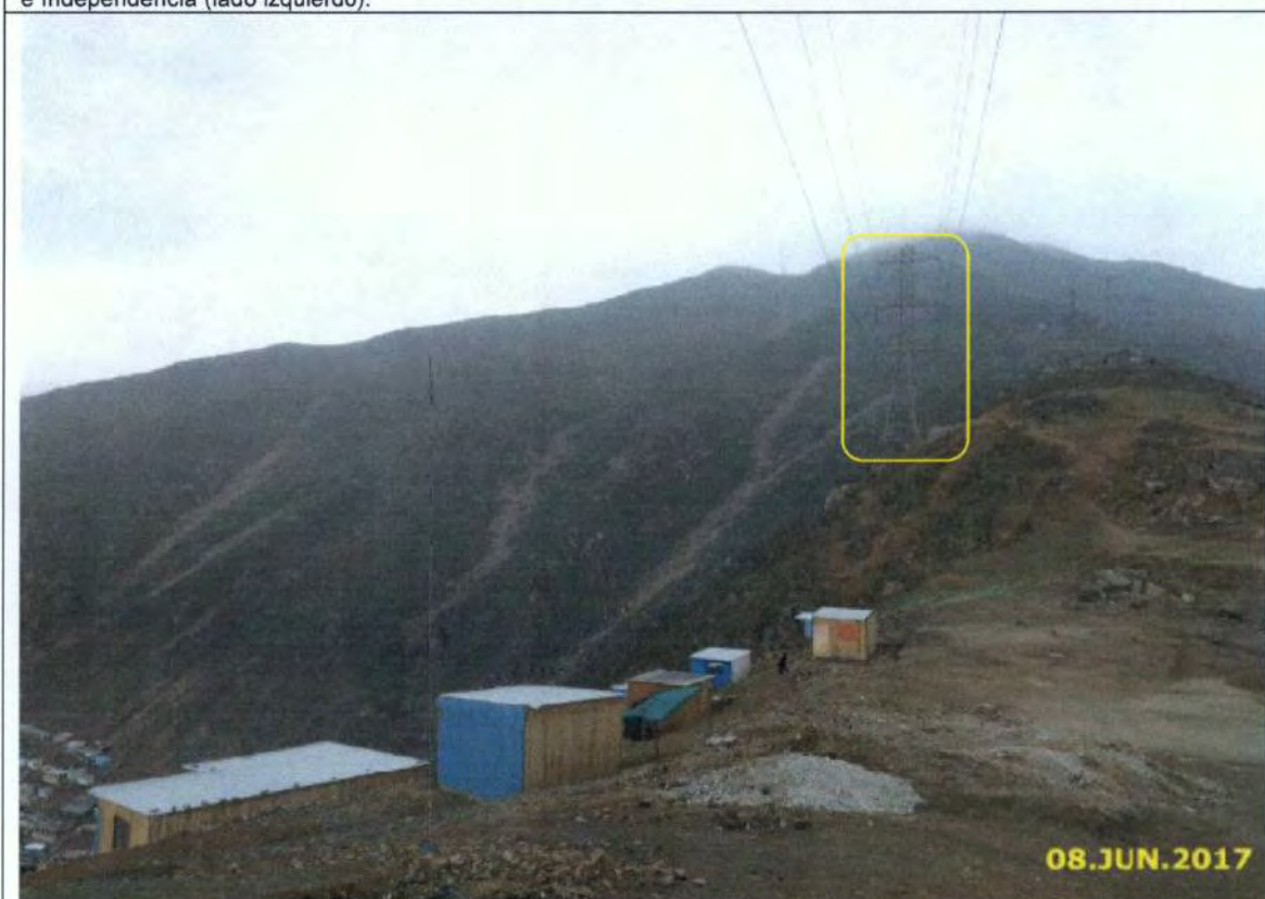
Fotografía N°6: Vista de las viviendas (distrito de Independencia) construidas debajo de la franja de servidumbre de la L.T 220 kV S.E. Mirador - S.E. Malvinas.
